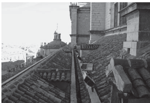
Canal oculta, estado previo y reformado. Las tejas se han retranqueado para facilitar el mantenimiento. Cubierta c/ Campanas. Catedral de Jaén.
