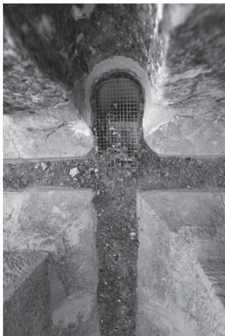
Entrada a una de las bajantes embutidas en contrafuertes protegida con rejilla después de la intervención. Catedral de Jaén.
