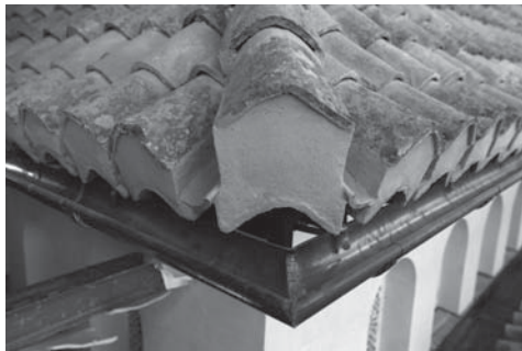
Detalle de canalón de cobre suspendido bajo el alero. Sala de los Reyes en la Alhambra de Granada.
