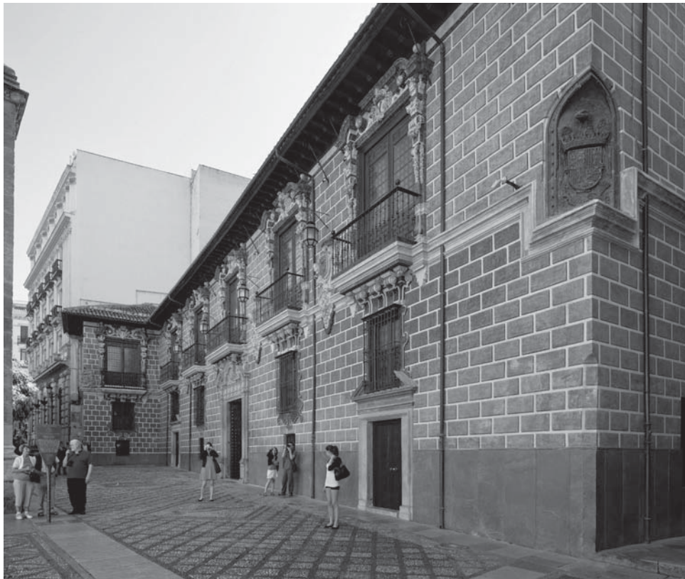
Bajantes exteriores de cobre. El sistema combinado de canales y bajantes evita la caída directa del agua en el plano inferior de fachada. Palacio de la Madraza, Granada. FOTOGRAFÍA: Fernando Aida.
