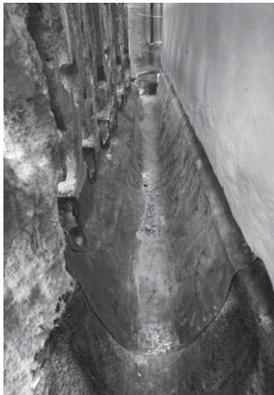
Tela asfáltica de alta durabilidad protegida con lámina de plomo de 2 mm en la canal del cimborio del Hospital Real, Granada.
