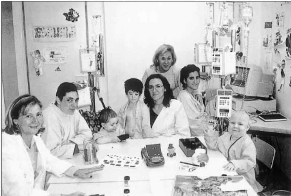
A aula de oncoloxía do Hospital Infantil La Fe, Valencia. Para satisfacer as necesidades emocionais, curriculares e sanitarias necesítase a colaboración de equipos multidisciplinares.
