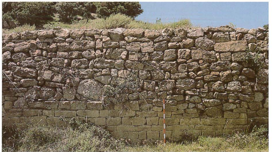
Arriba: Vista general del largo muro de opus caementicium desde el SE. Abajo: Tramo central de dicho muro, con recubrimiento de opus vittatum .
