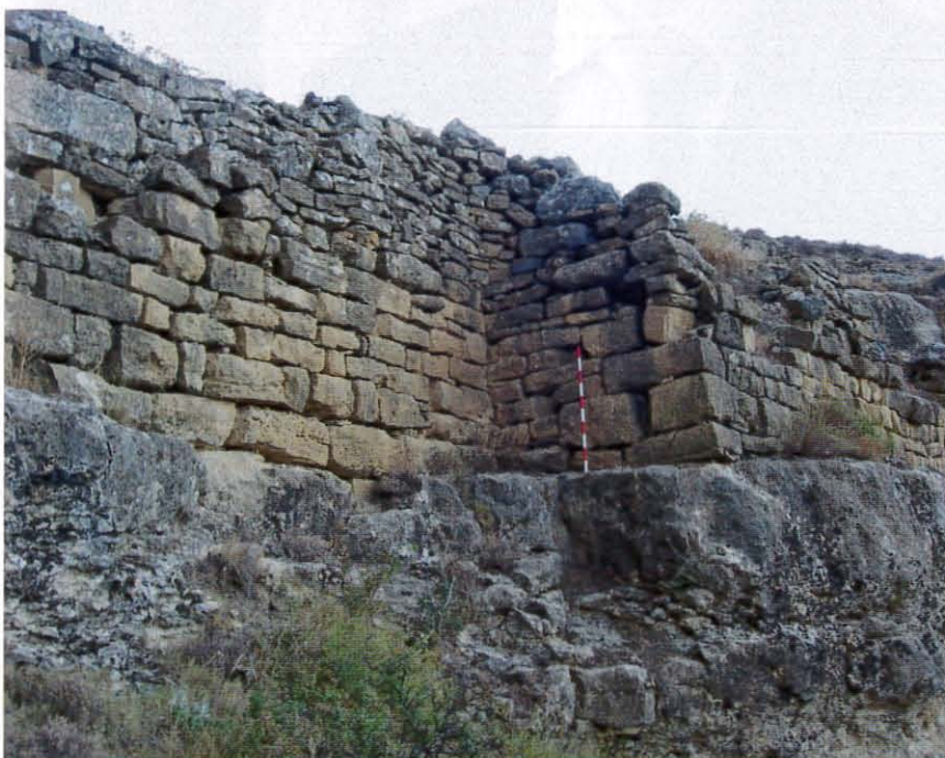
A la izquierda: Tramo de muralla visible en el lado este de la Moleta dels Frares.
