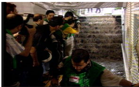
(Imagen 2: Escaleras de vestuarios totalmente inundadas)
