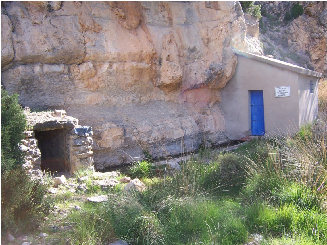
Foto 1. Bocaminas antigua y moderna de la Fuenlozana (Mora de Rubielos, Teruel).
