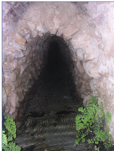
Mina de la Rampa (Mula, Murcia)
