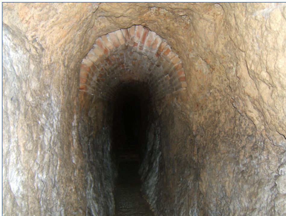
Foto 9. Bóveda reforzada con ladrillos cerámicos en el Alcavor de Santa Bárbara o dels Teulars (Bocairent, Valencia).
