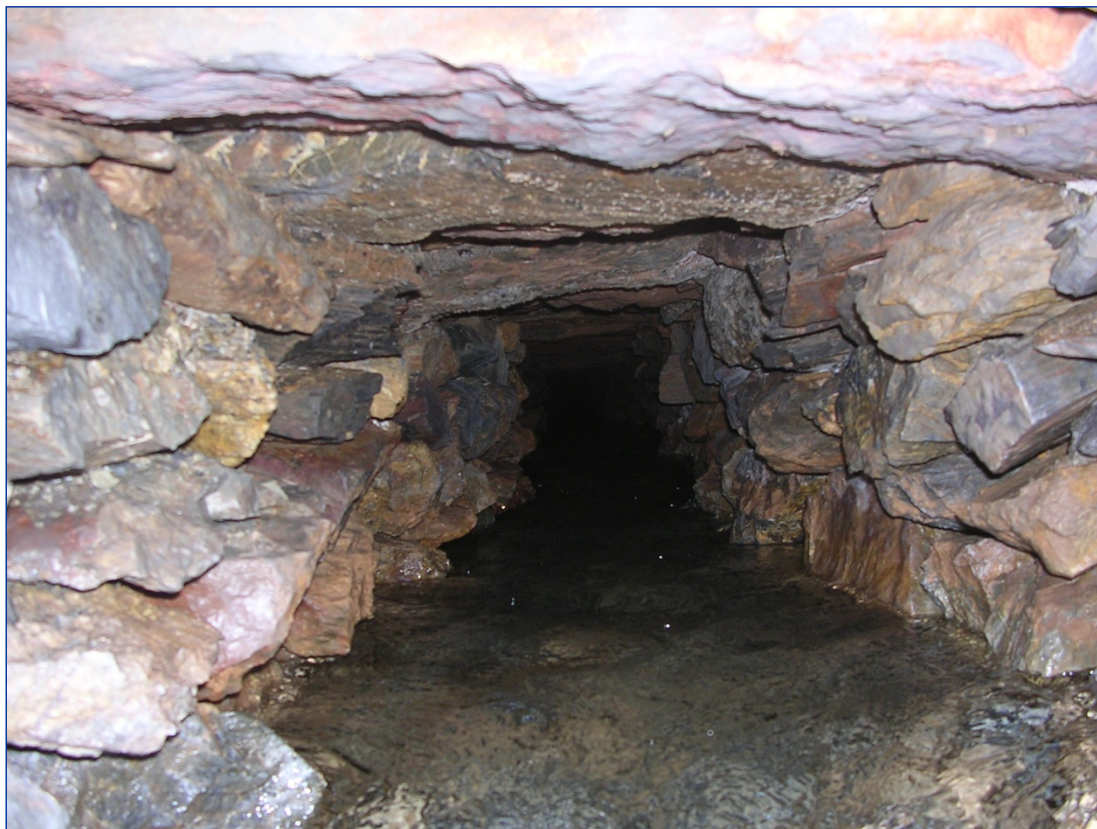
Foto 29. Canal subterráneo de conducción del caudal en la Fuente Nueva (Dalías, Almería).
