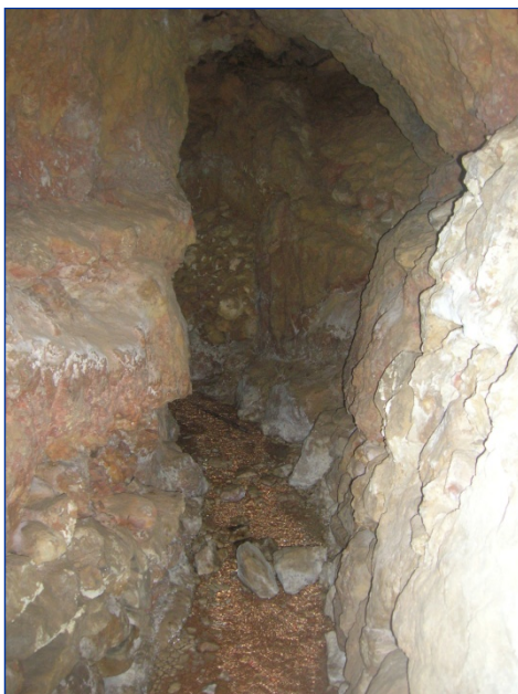
Foto 12. Sección excavada directamente en los materiales en la Mina de Aguas de Zucaña (Almansa, Albacete).
