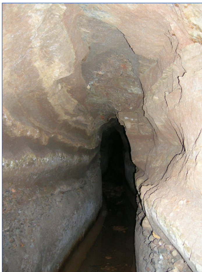
Foto 27. Sección irregular en la Fuente del Abastecimiento Público (Santa Fe de Mondújar-Gádor).
