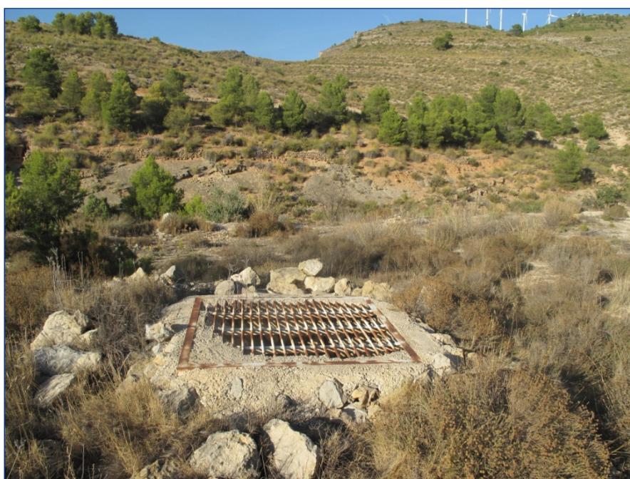
Foto 13. Lumbrera de la Mina Nueva de Aguas del Paraíso (Caudete, Albacete).
