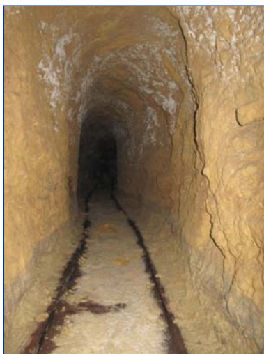
Foto 15. Restos de raíles y traviesas en la Mina de San Juan (Biar, Alicante).
