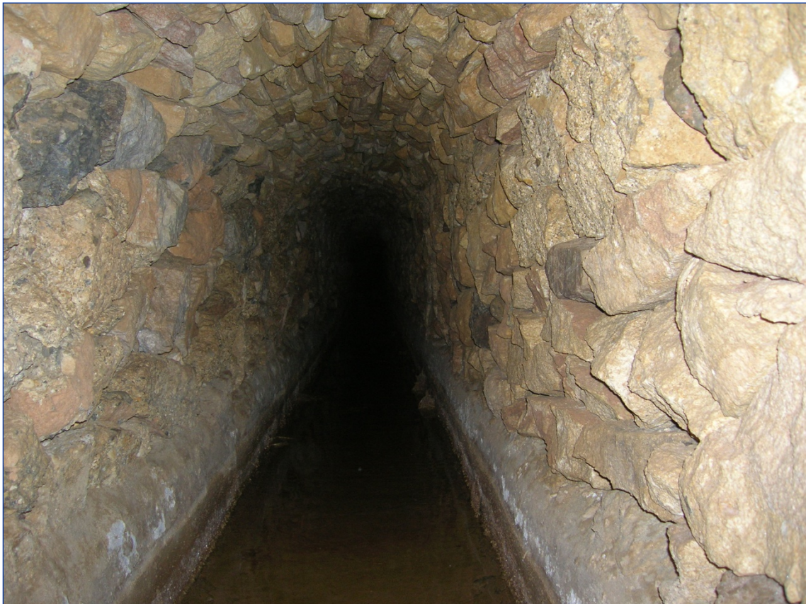
Foto 21. Sección revestida con piedra en seco en la Mina del Agua Nueva o del Talabartero (Alhama de Murcia, Murcia).
