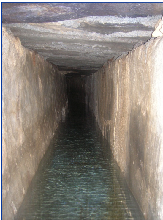
Foto 22. Cubierta plana o arquitrabada en la galería del Caño Viejo y el Contracaño (Puerto Lumbreras, Murcia).
