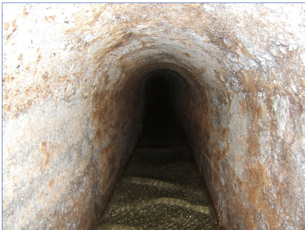
Foto 3. Sección con bóveda de cañón en la Font d'Arguines (Segorbe, Castellón).
