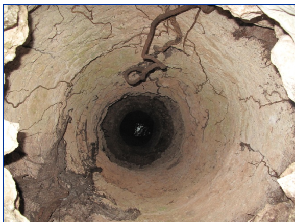
Foto 19. Lumbrera circular en la Mina de Tobarrillas Bajas (Yecla, Murcia).
