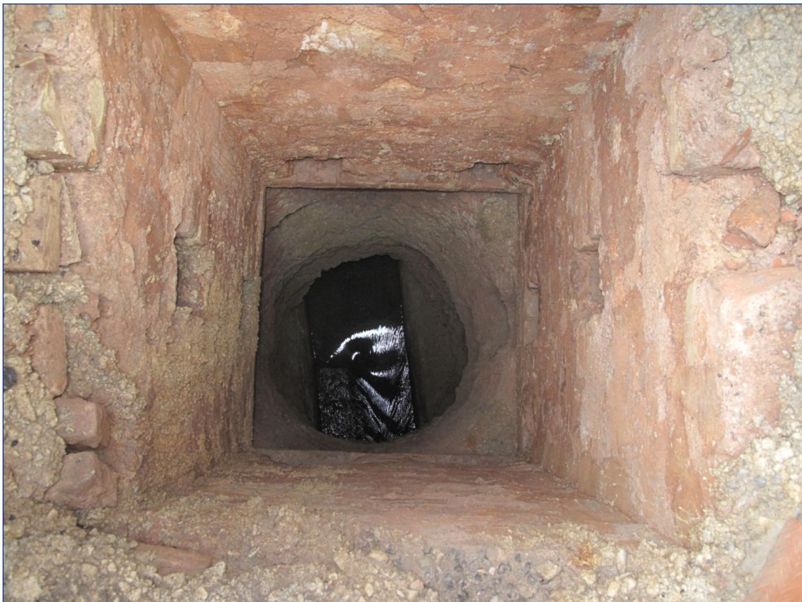
Foto 6. Respiradero en El Minat o Mina de Bufilla (Moncada, Valencia).
