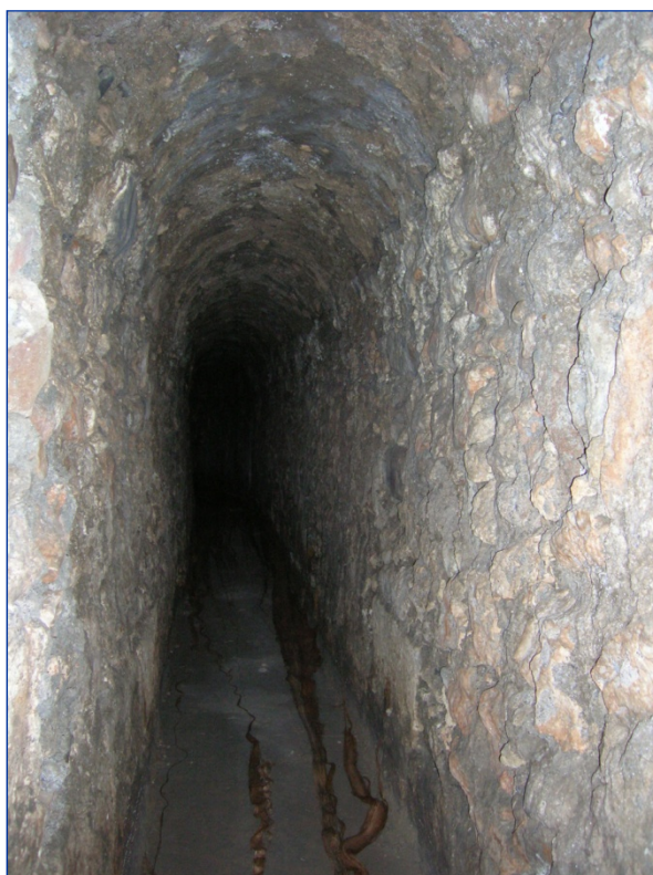
Foto 28. Cimbra de la Fuente de Pechina (Pechina, Almería).
