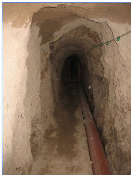
Foto 17. Sección excavada directamente en los materiales en la Font del Molí (Finestrat, Alicante).
