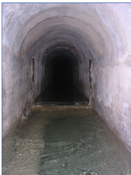
Foto 16. Bóveda de cañón en la Fuente de Santa María (Ibi, Alicante).
