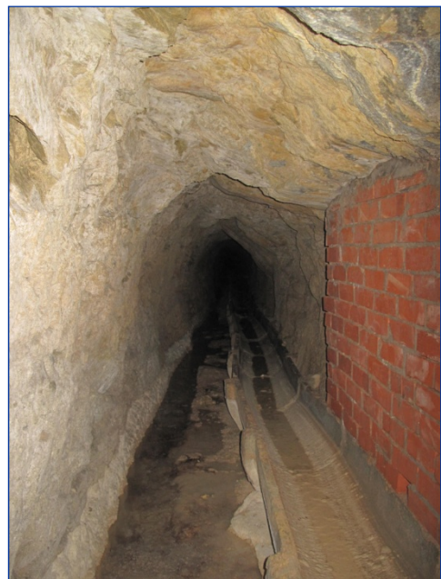
Mina del Figueral o del Puerto (Biar, Alicante)
