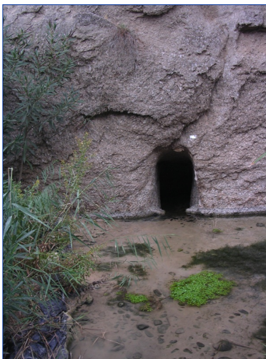
Foto 25. Lumbrera lateral en la Fuente de los Molinos del Río Aguas (Sorbas, Almería).
