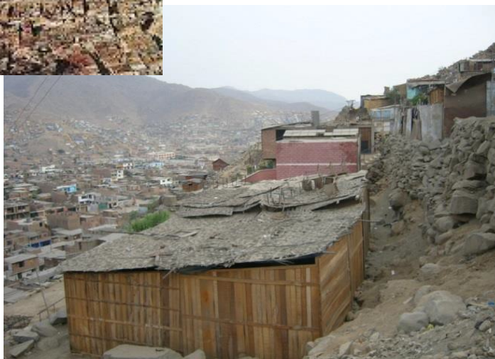
Foto N° 2. Viviendas en ladera del cerro
