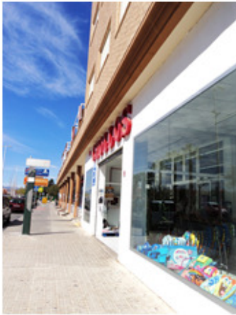
Figura 2. Zona situada en la parte Este del colegio.
