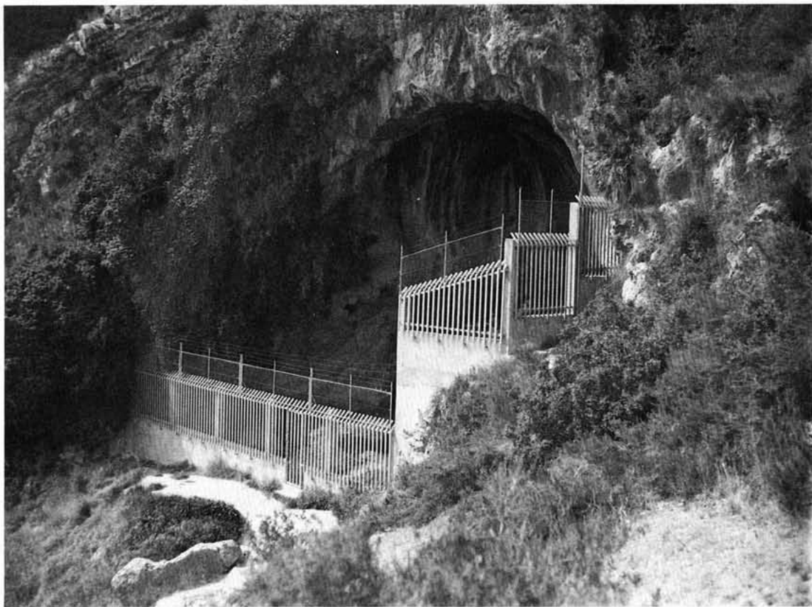
Cova Negra: Vista general y detalle de la entrada
