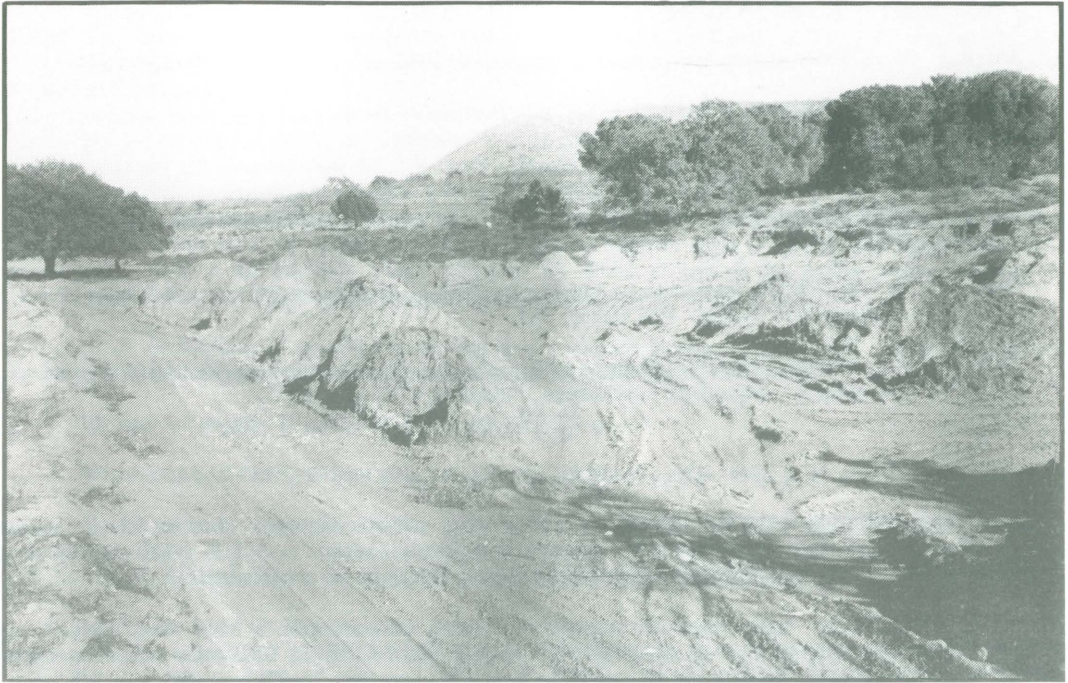
La parcel·la contigua al Camí dels Romans després de les remocions de terra.
