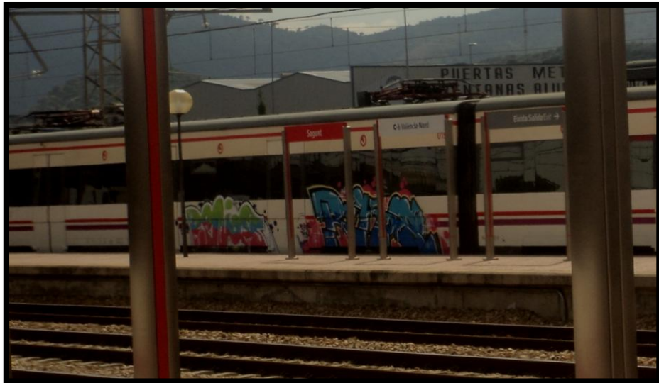
Img.: 6. Estación Sagunto. Renfe Línea Valencia-Castellón. Fot.: BG
