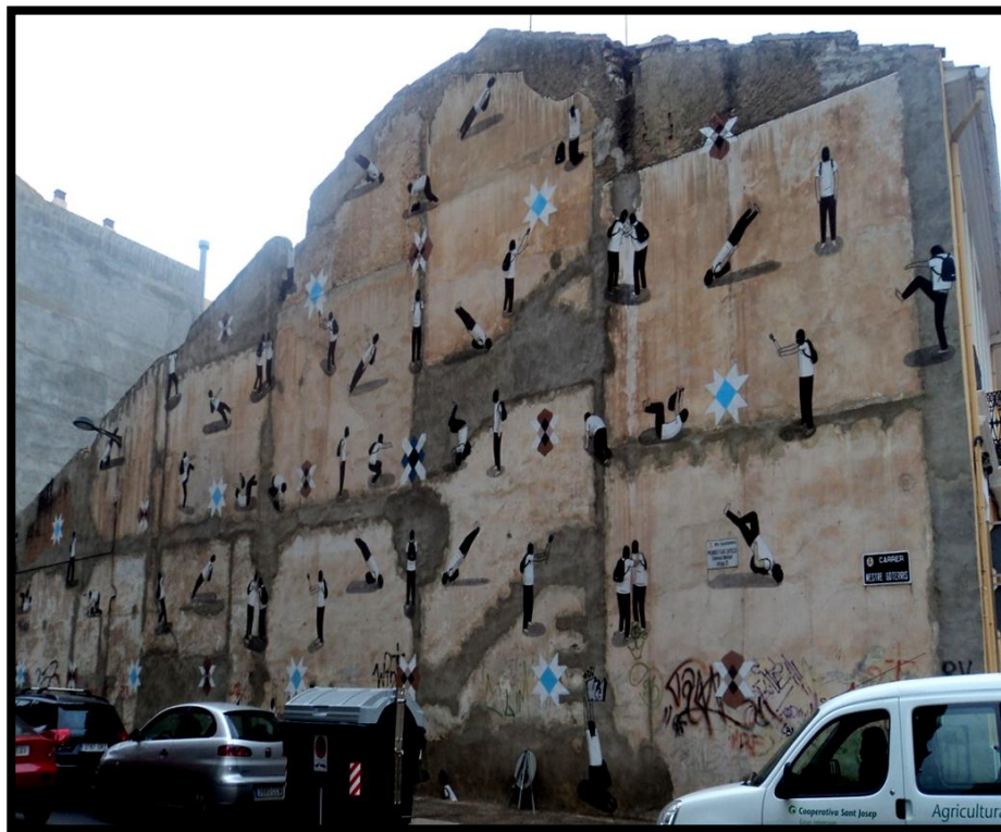
Img.: 94 Escif. “Vandalismo Ilustrado” Vila-real Castellón 2013. Fot.: BG
