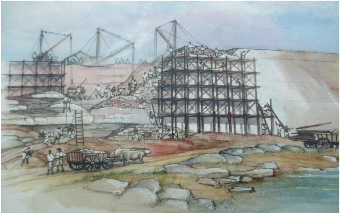
1.5 DIBUJO DE ACUARELA MOSTRANDO OBREROS ALZANDO MURO DE SILLERÍA, 1790
