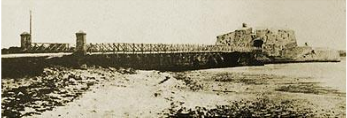
4.4 PUENTE FORTIFICADO DE SAN ANTONIO EN LA AVENIDA PONCE DE LEÓN, SAN JUAN PUERTO RICO.
