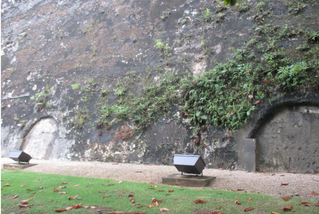
3.37 CONTRAMINA EXTERIOR CUBIERTA DESDE EL BALUARTE DE LA PRINCESA
