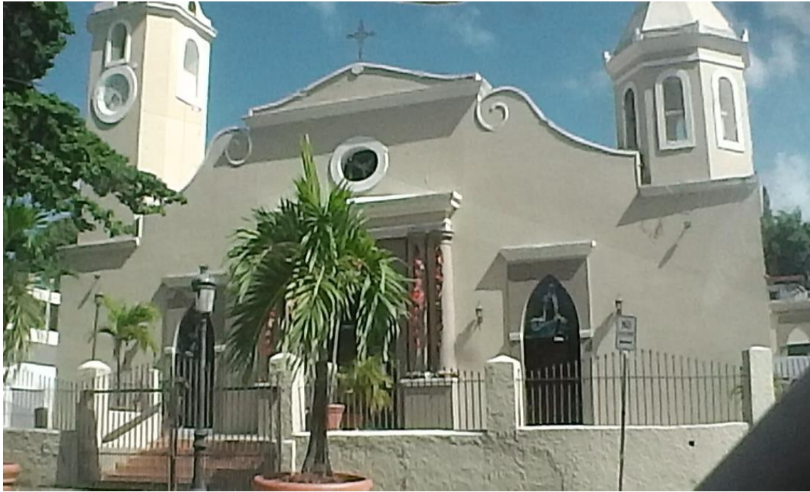
6.34 IGLESIA SAN CARLOS BORROMEO.
