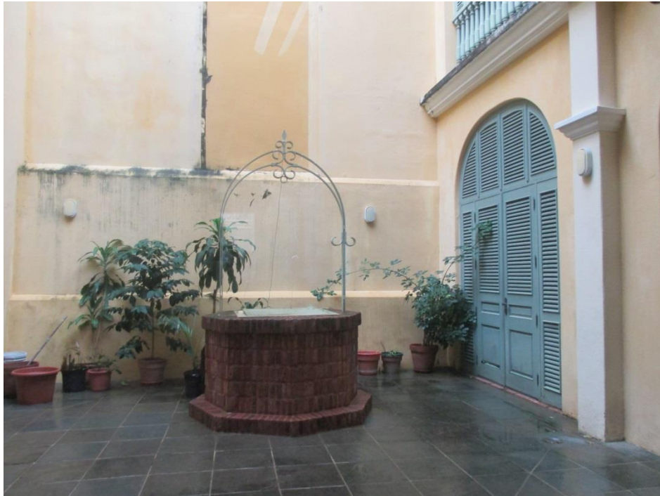
4.17 EJEMPLO DE ALJIBE EN PATIO CENTRAL DE EDIFICIO DE LA CALLE LA FORTALEZA.
