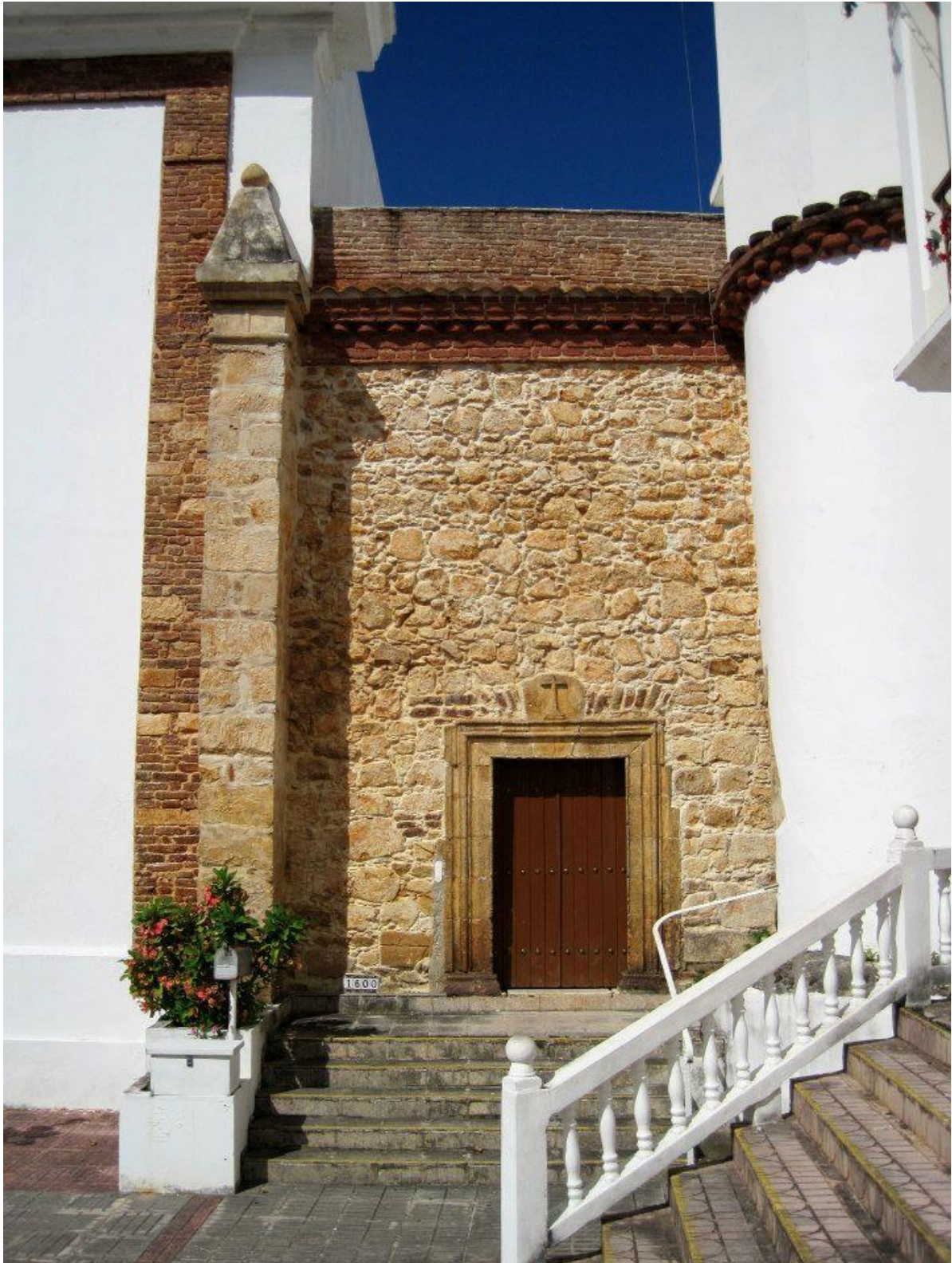
6.32 DETALLE DE LAS PAREDES DE SILLERÍA Y ENTRADA A LA TORRE DEL CAMPANARIO TRASERO.
