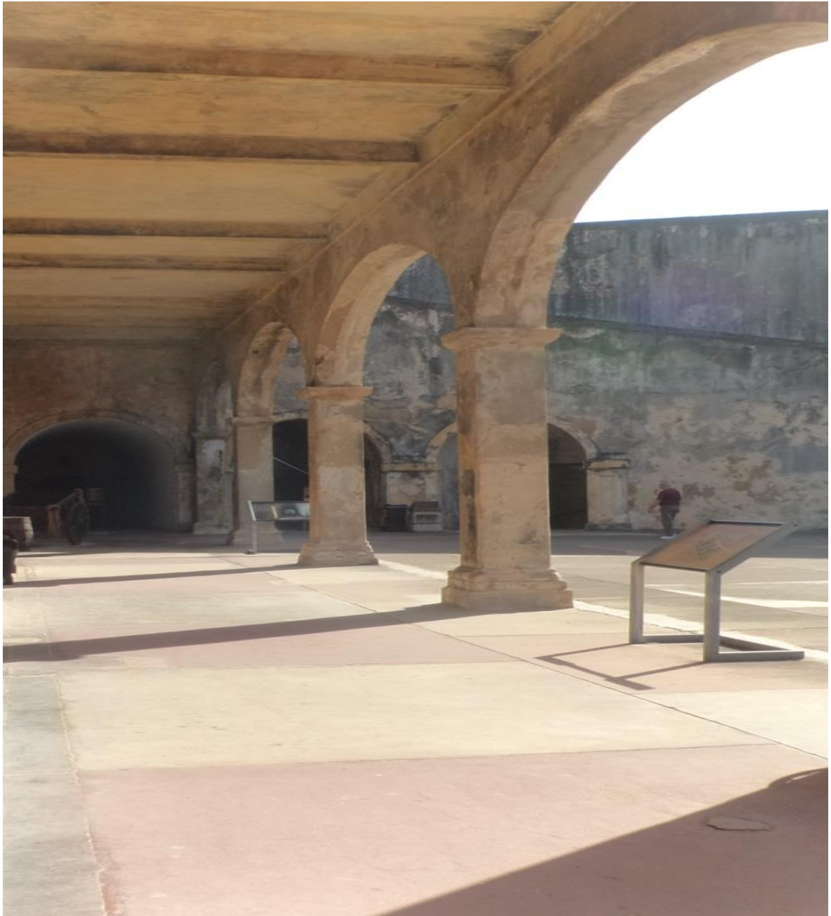
2.1 PLAZA CENTRAL DE MILICIAS EN LA FORTIFICACIÓN DE SAN CRISTÓBAL.
