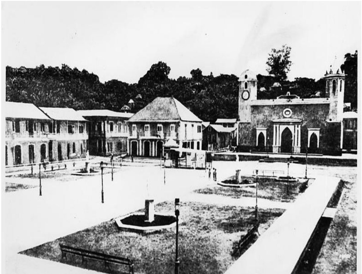
6.33 PLAZA Y PARROQUIA SAN CARLOS BORROMEO DE AGUADILLA C. 1890.
