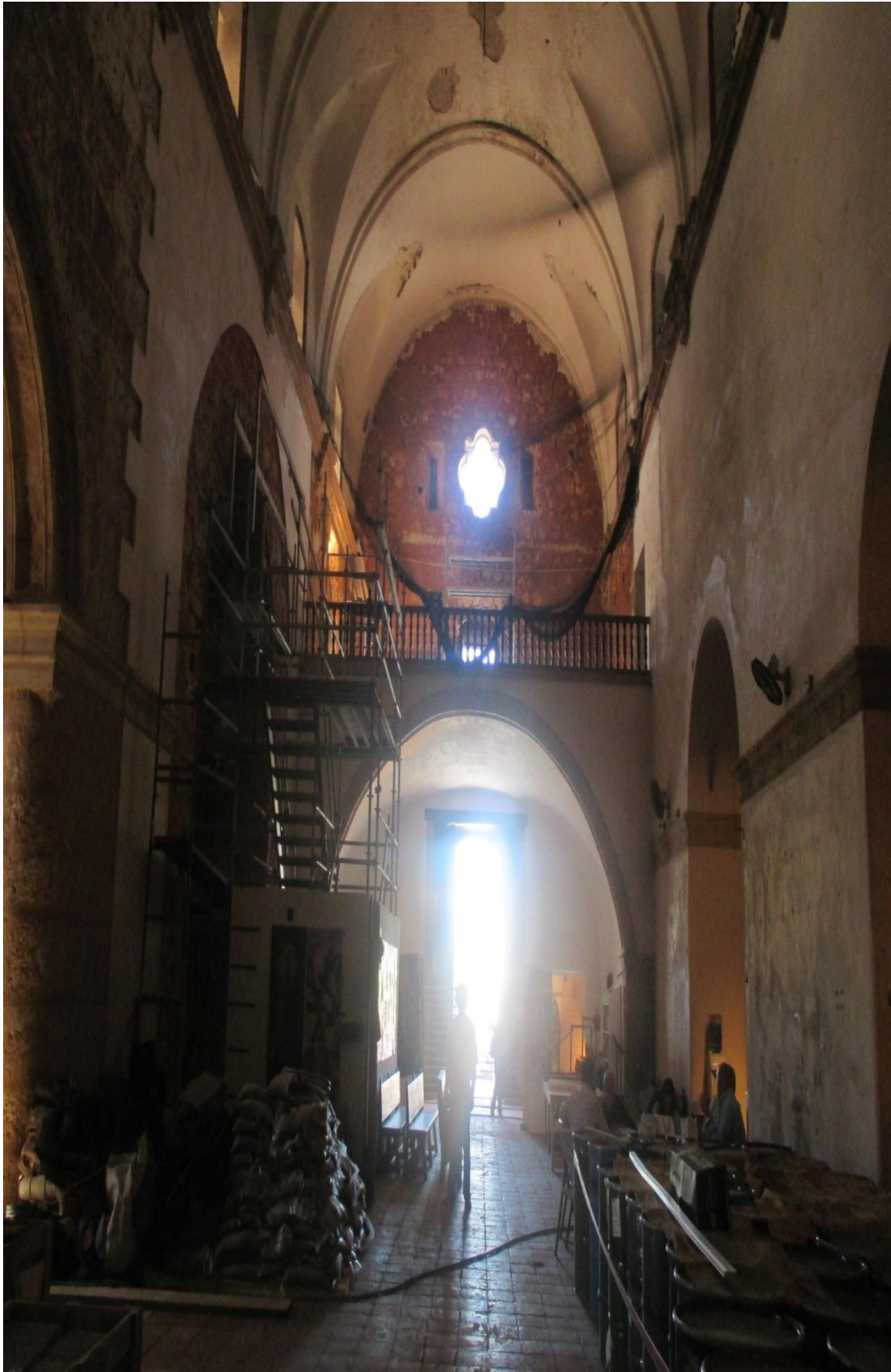
6.15 NAVE CENTRAL EN OBRAS DE RESTAURACIÓN, IGLESIA DE SAN JOSÉ
