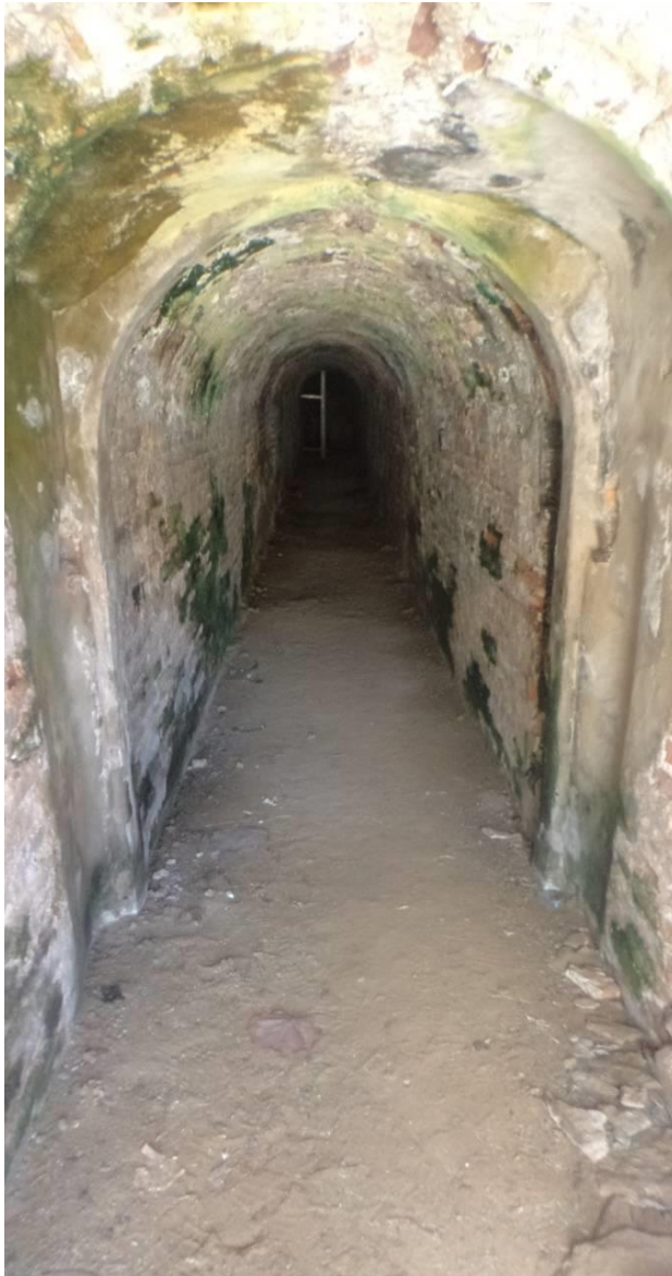
3.36 TÚNEL EN EL CASTILLO SAN CRISTÓBAL
