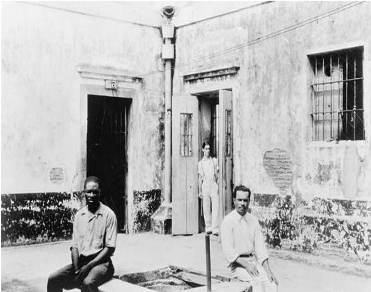
5.2 PATIO CENTRAL RESIDENCIA, OBREROS SOBRE ALJIBE. C.1896.
