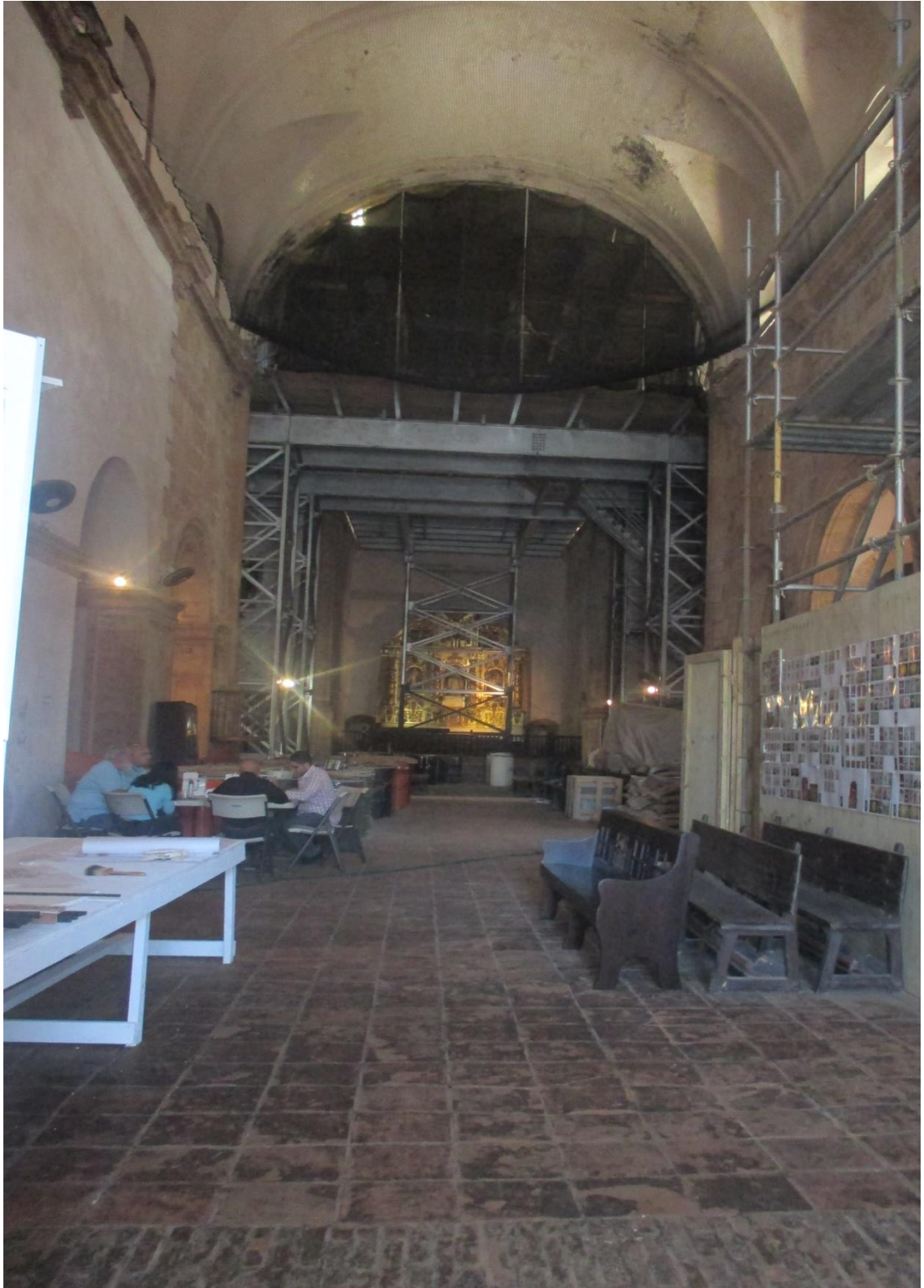
6.14 OBRAS DE RESTAURACIÓN EN LA IGLESIA DE SAN JOSÉ
