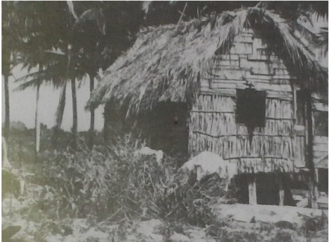
4.1 TIPOLOGÍA DE CASA DE CAÑA Y MADERA LEVANTADA EN POSTES
