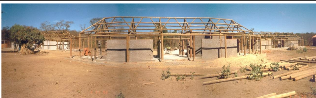
Ilustración 24: Escuela en construcción. Brejo Matafome. Año 2002
