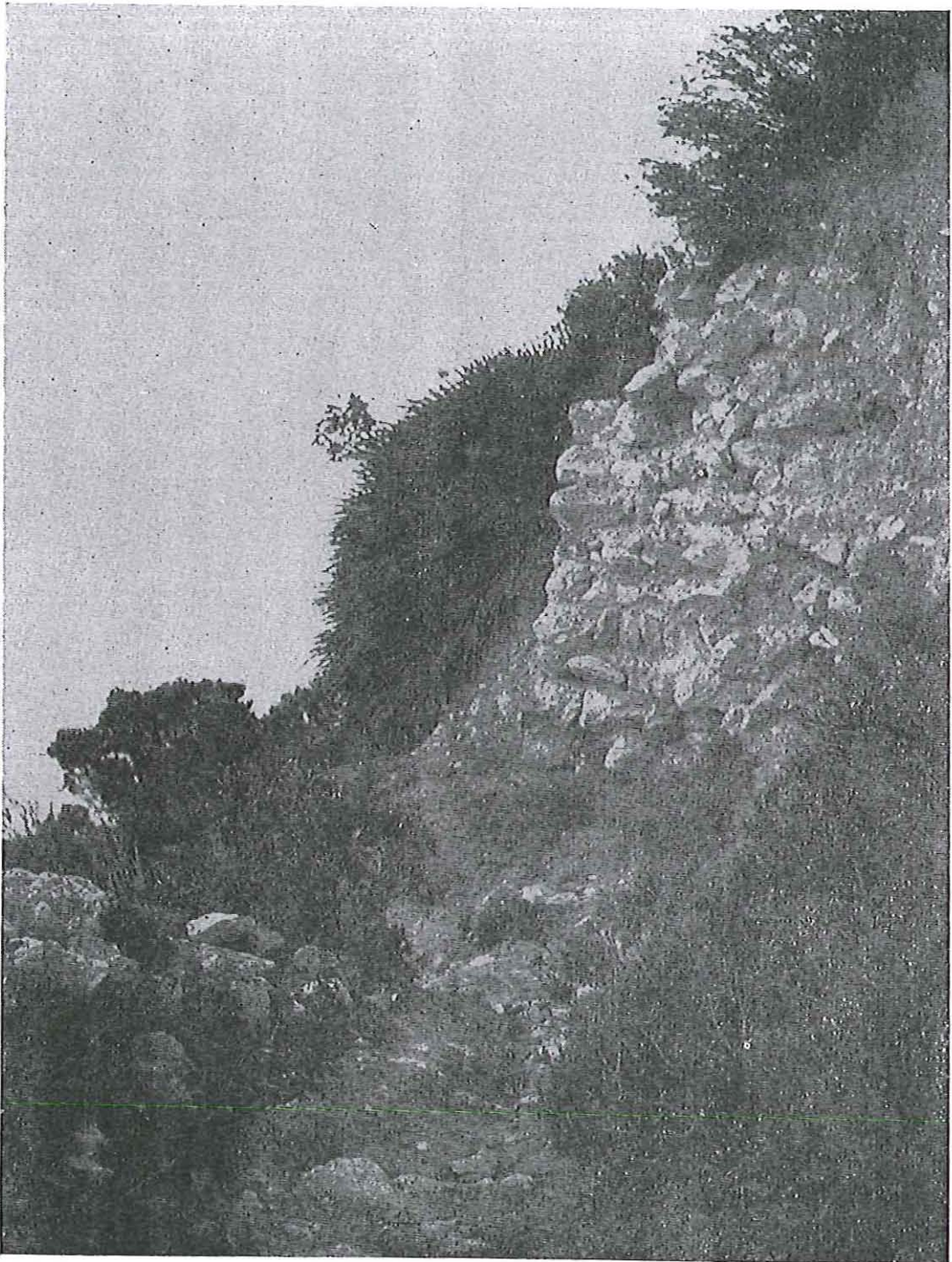
Resto de muralla conservado entre la parte superior y la parte media de la ladéra
