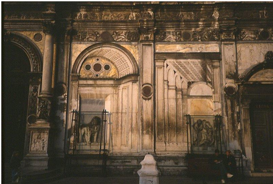
Figura 13. Venecia, Scuola Grande di san Marco , fachada (detalle)
