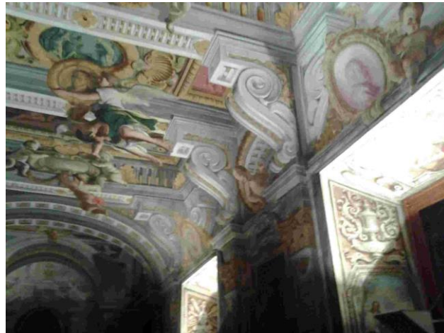
Corrección óptica. El techo abovedado ha sido tratado para que parezca plano.
