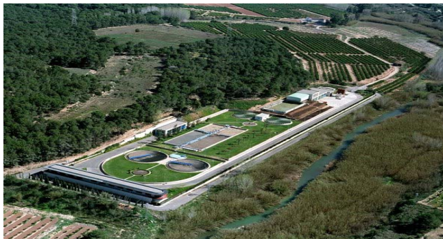
Figura A.18 Vista aérea de la EDAR de Camp de Turia II (Fuente: www.epsar.gva.es )
