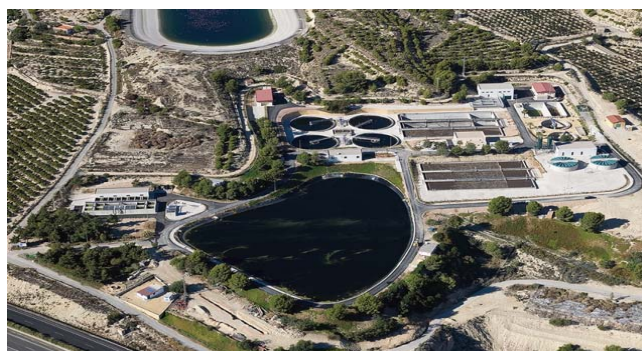
Figura A.11 Vista aérea de la EDAR de la Vila Joiosa (Fuente: www.epsar.gva.es )
