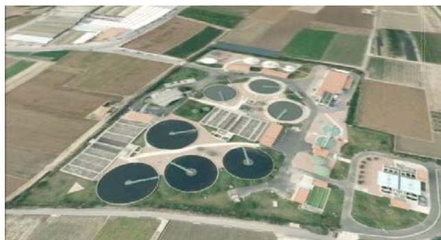
Figura A.4 Vista aérea de la EDAR de la Conca del Carraixet (Fuente: www.epsar.gva.es )
