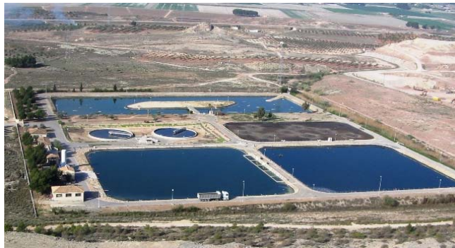
Figura A.20 Vista aérea de la EDAR de Villena (Fuente: www.epsar.gva.es )
