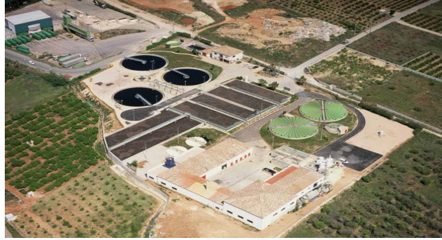
Figura A.9 Vista aérea de la EDAR de Denia-Ondara-Pedreguer (Fuente: www.epsar.gva.es )
