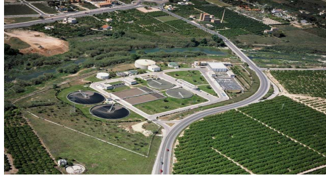
Figura A.15 Vista aérea de la EDAR de Gandía – La Safor (Fuente: www.epsar.gva.es )
