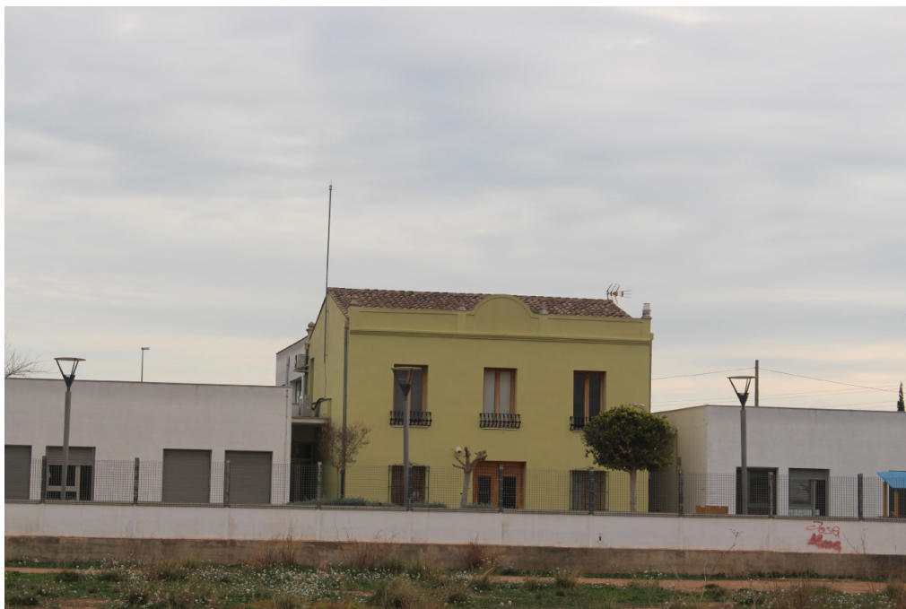
Foto 17. Vista exterior de la escuela. Fachada de la Escuela Municipal Infantil L'Alqueria de Alaquàs vista desde fuera. Se trata de la parte trasera, donde se hace visible la alquería original en el centro de los tres bloques
