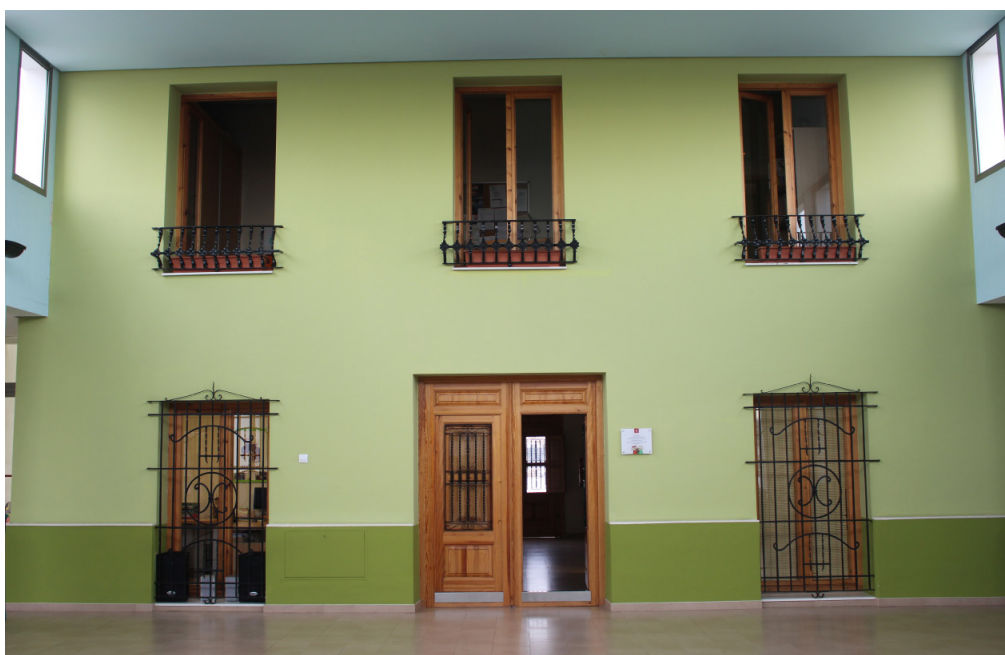
Foto 28. Presentación de la plaza. Fachada de L´Alqueria vista desde la plaza de la escuela. Es la visión que se obtiene de la escuela cuando entras por la entrada. En este edificio se albergan las dependencias de los adultos: sales de reuniones y despachos.
