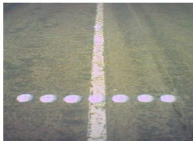
*Figura 12. Configuración de los 7 sensores AMR en línea para re-identificar vehículos (Cheung & Varaiya 2007)*
