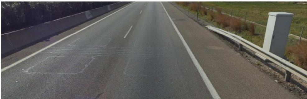
Figura 2. Instalación de espiras en la carretera CV-36 (Valencia)<sup>2</sup>
