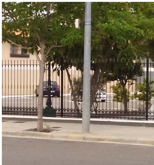
Imagen 148: Instalación sensor 1 rotonda Andana
