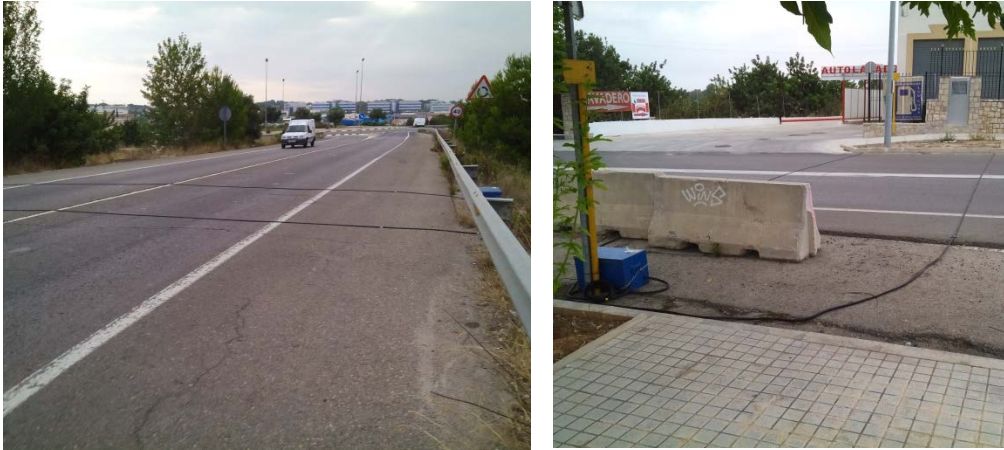
Imagen 150: Instalación aforadores con goXXX rotonda Andana
