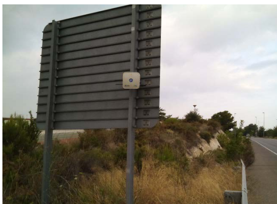
Imagen 149: Instalación sensor 2 rotonda Andana
