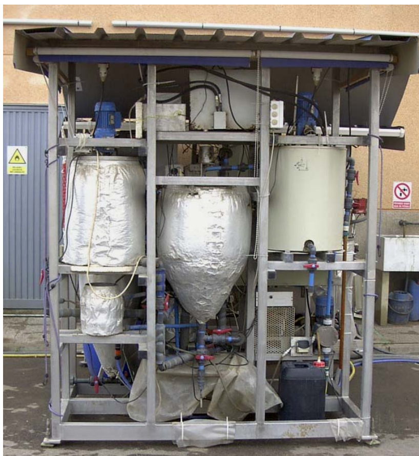
Figura 10.3. Vista general de la planta pilot per la part posterior.
