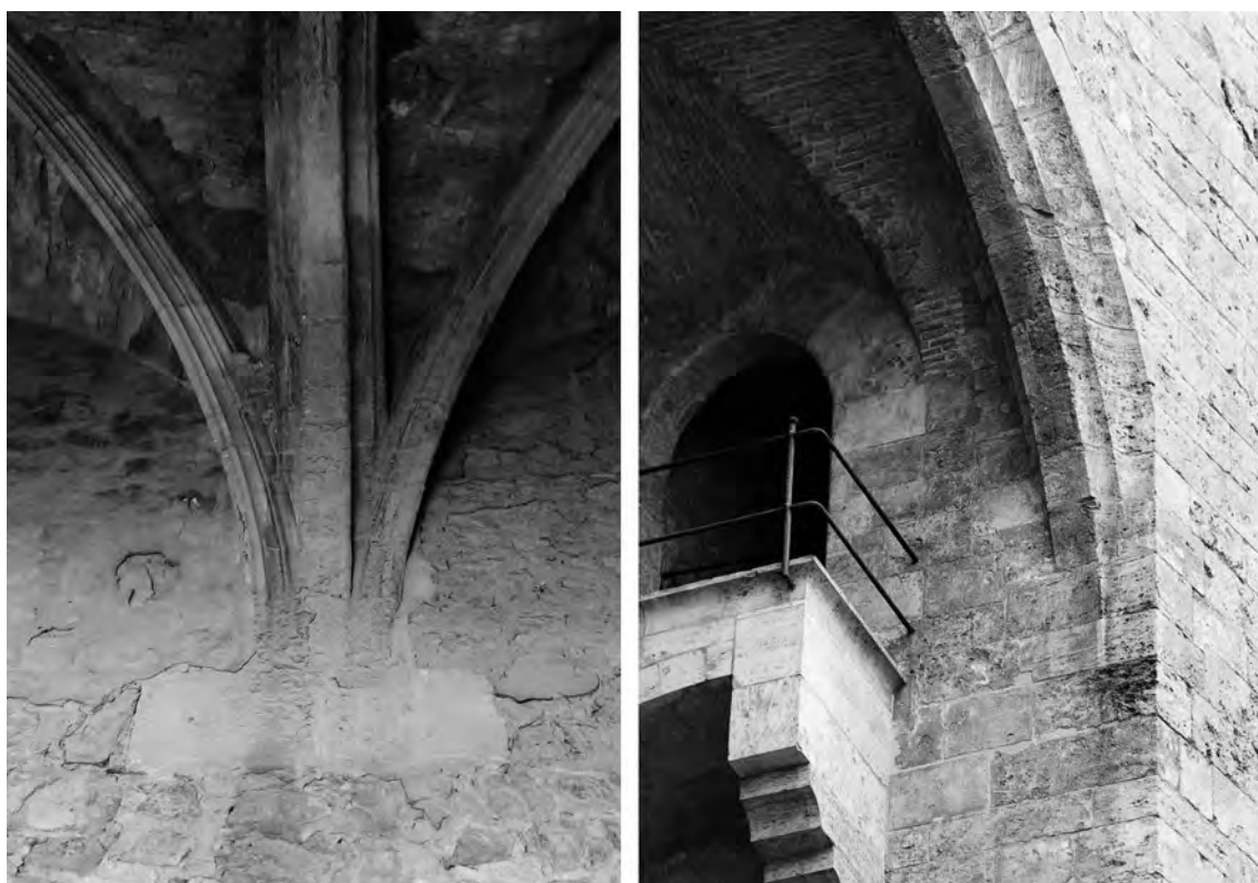
Fig. 2. Jarjamentos continuos sin ménsula. A la izquierda, bóvedas del Castillo de Almansa; a la derecha, arco del Portal de Quart de Valencia, obra de Francesc Baldomar.
