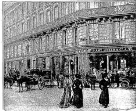
7, rue Cluser & 1, rue Boudreau
