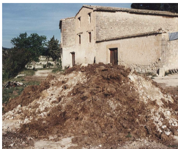
Fig. 4.16. Endulzado o curación del estiércol con aportes de tierra rica en yesos. Valle del Polop (Alicante). Fuente: del autor.
