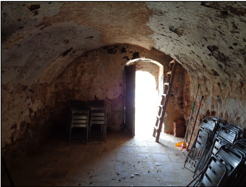
Fig.7 Interior del edificio adosado, mirando hacia la puerta (2015).
