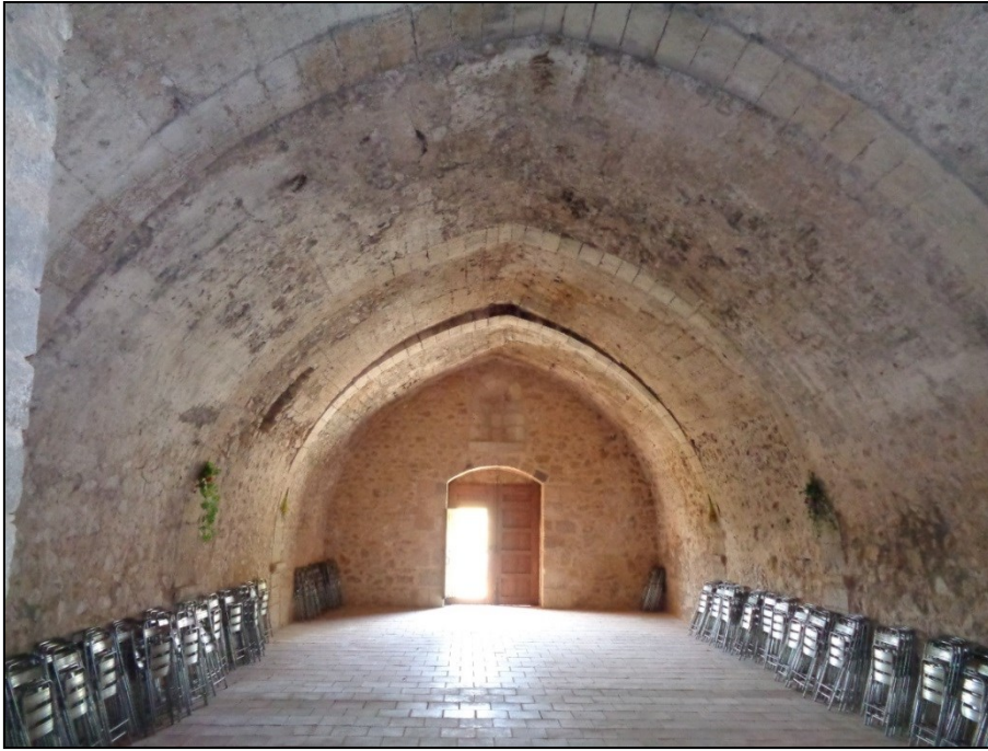
Fig. 6. Vista de la nave hacia la entrada
