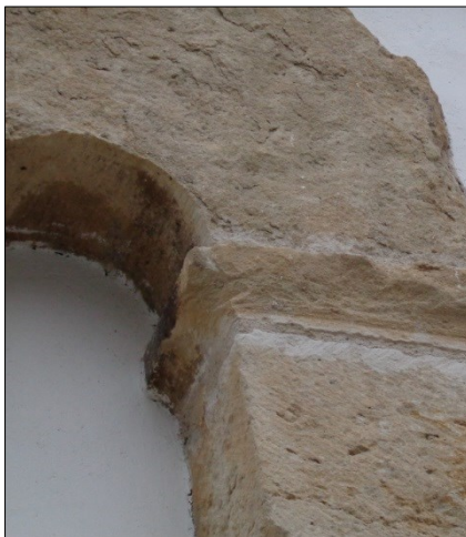
Fig. 3. Detalle de la imposta del ventanal de la primera planta.
