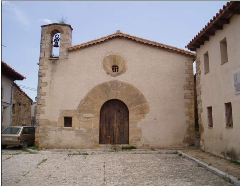
Fig.1 Fachada de la ermita de San Miguel (2004)
