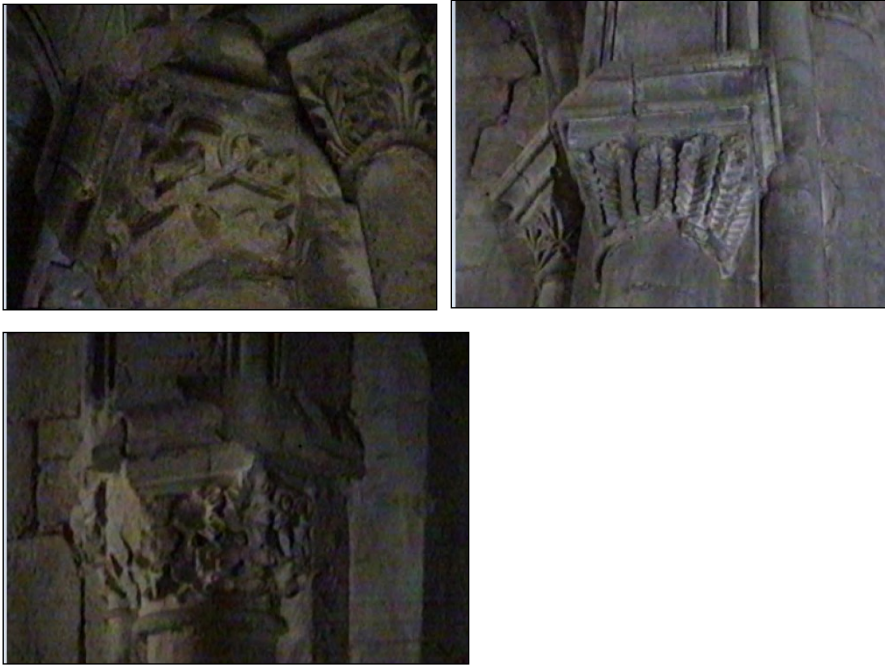
Fig.10 Capiteles de las embocaduras de las capillas del crucero.
