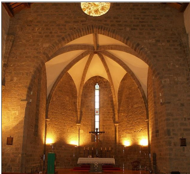
Fig. 4. Vista del ábside y arranques de las nervaduras de la nave.
