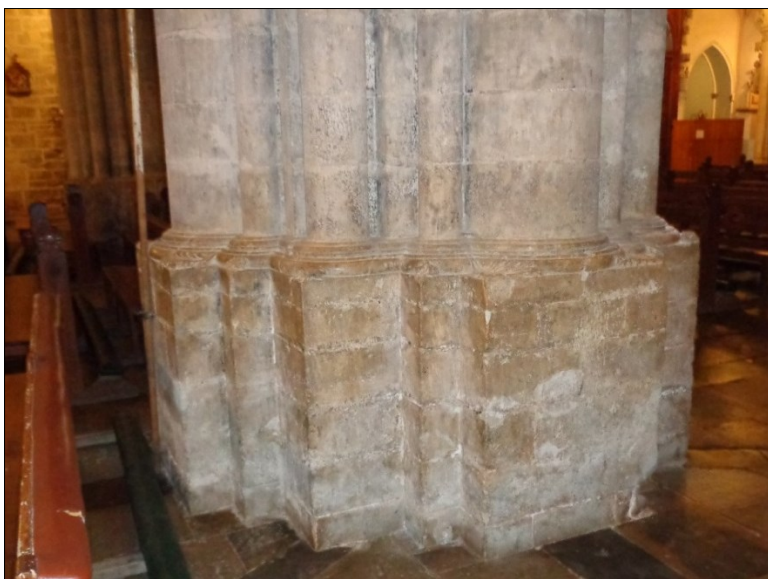
Fig. 3 Detalle de uno de los pilares de la nave.
