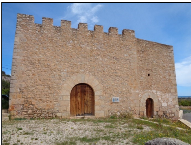
Fig. 1. Fachada SO de la ermita (2015).
