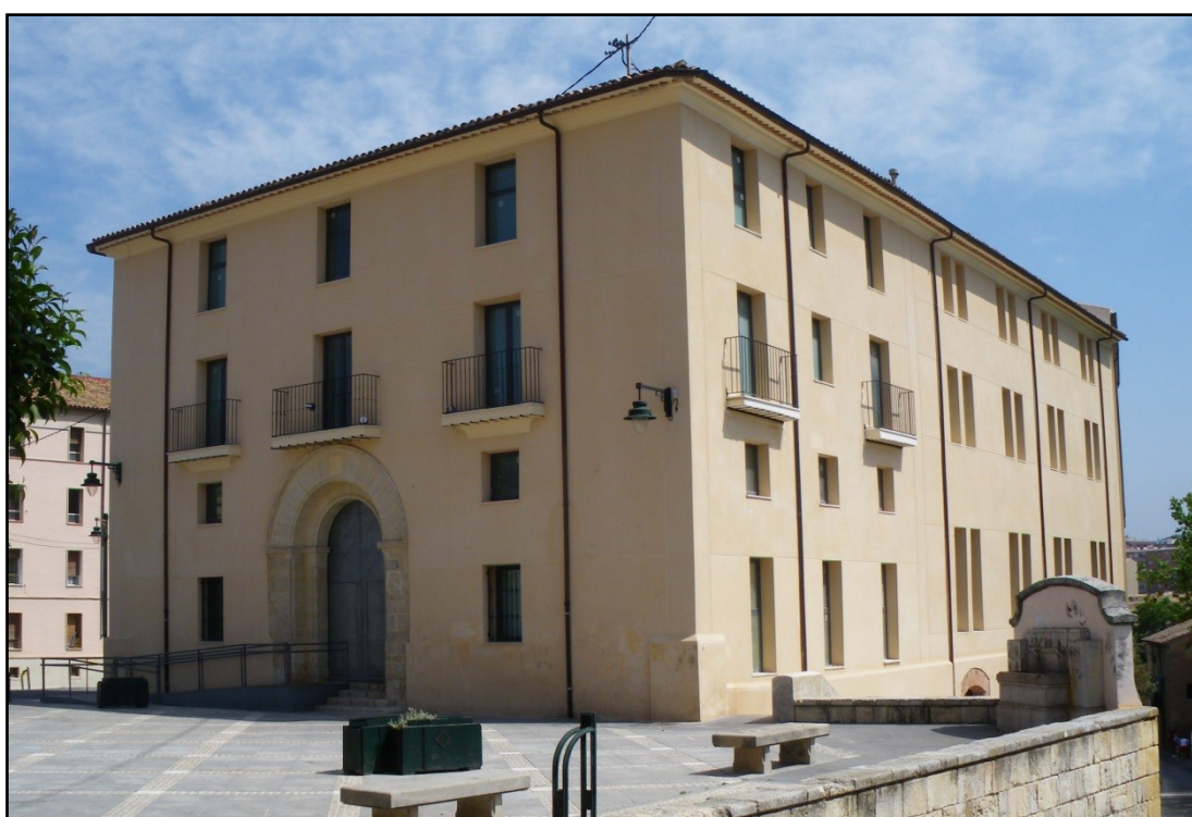
Fig. 3 Edificio de juzgados, antigua iglesia parroquial en cuya fachada SO se puede ver la antigua portada medieval.
