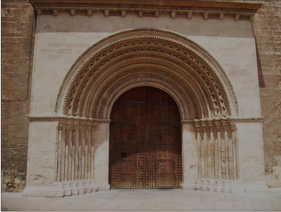
Fig. 12. Portada "del Palau" abierta en el transepto sur de la Catedral.
