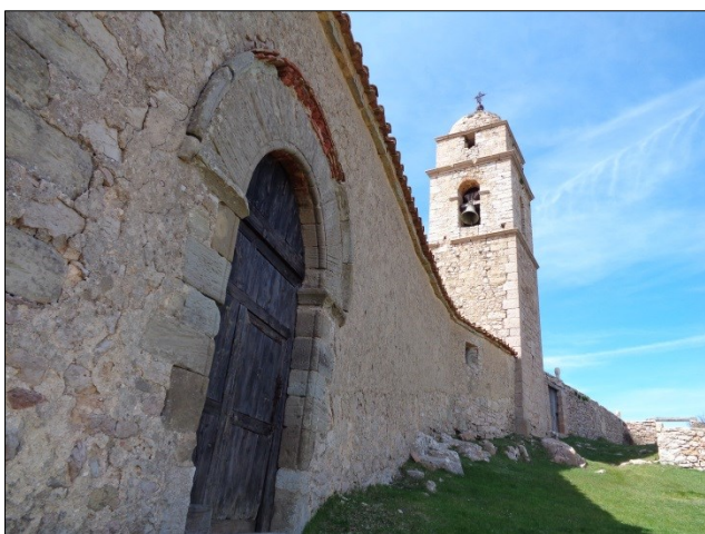
Fig. 1 Fachada de la iglesia con la torre campanario y el cementerio (2015).
