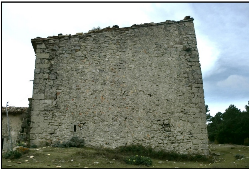
Fig. 2. Muro E, que cierra el presbiterio.
