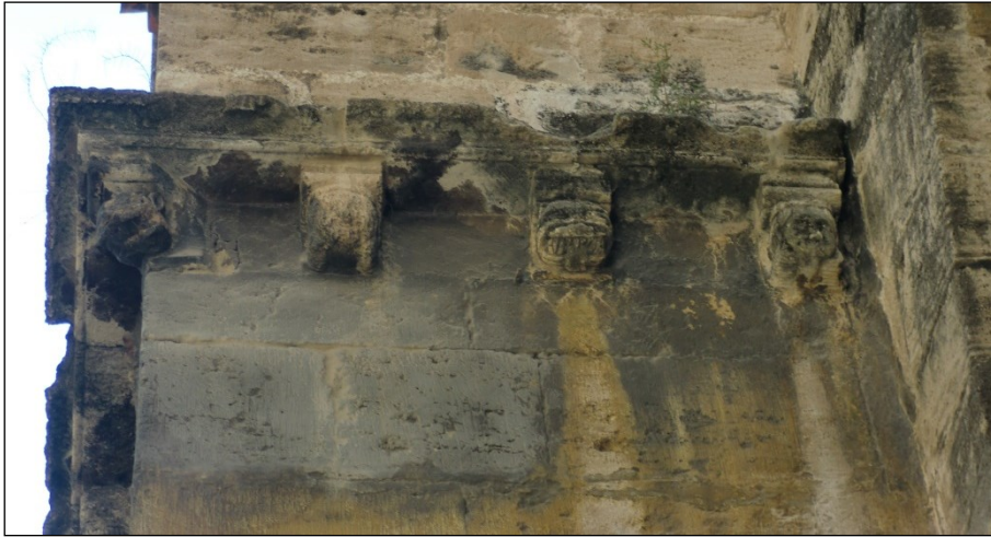
Fig. 6 Muro oeste de la capilla de San Miguel. Detalle de canecillos e imposta.
