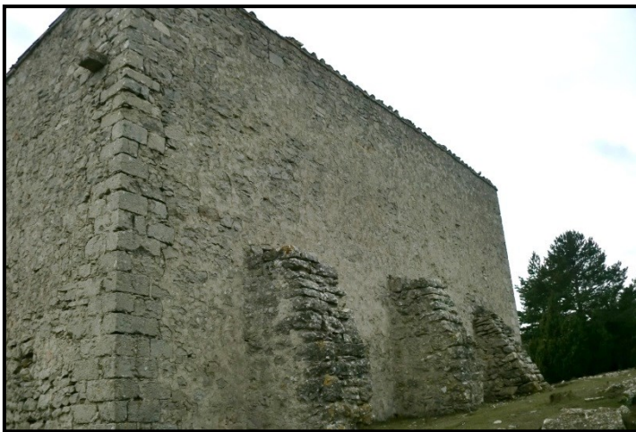
Fig. 12. Detalle del desagüe y contrafuertes del muro norte.
