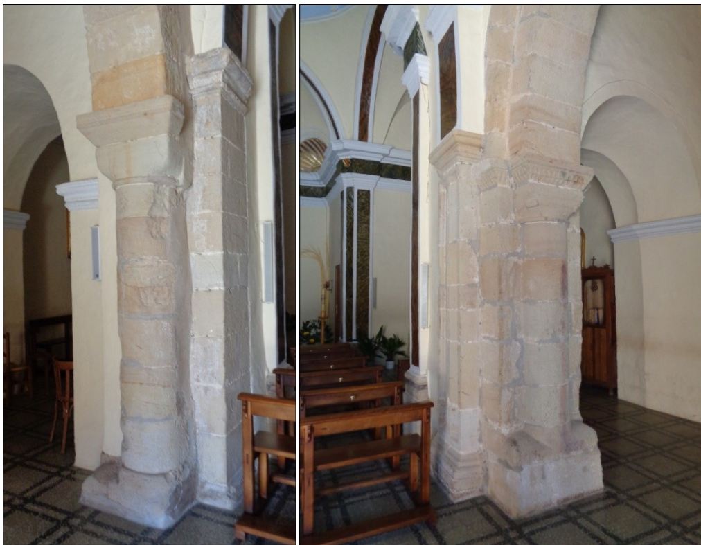
Fig.6 y 7. Pilares del lado NO de la nave. El que se encuentra junto a la portada, desornamentado (fig. 6) y junto al antiguo presbiterio (fig. 7).
