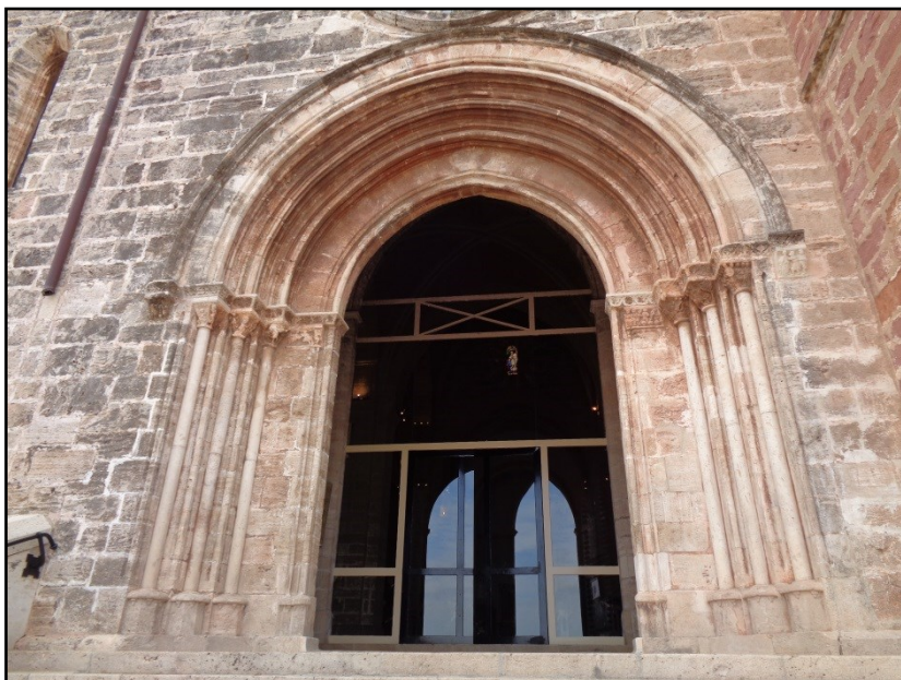
Fig. 14. Vista general de la portada en la actualidad (2014).
