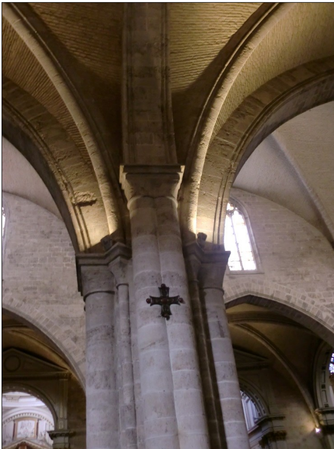
Fig.4. Articulación de columnas y arranque de los arcos en un pilar de la nave lateral del lado de la Epístola.
