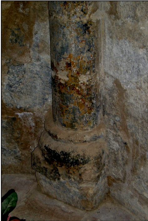
Fig. 12 Basa de una de las columnas adosadas del ábside (2004).
