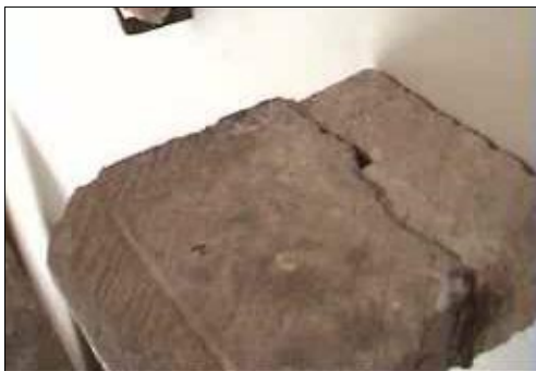
Fig. 3. Vista superior de la imposta A-54 donde se distingue la huella para colocación de la pieza y la parte que debía sobresalir.
