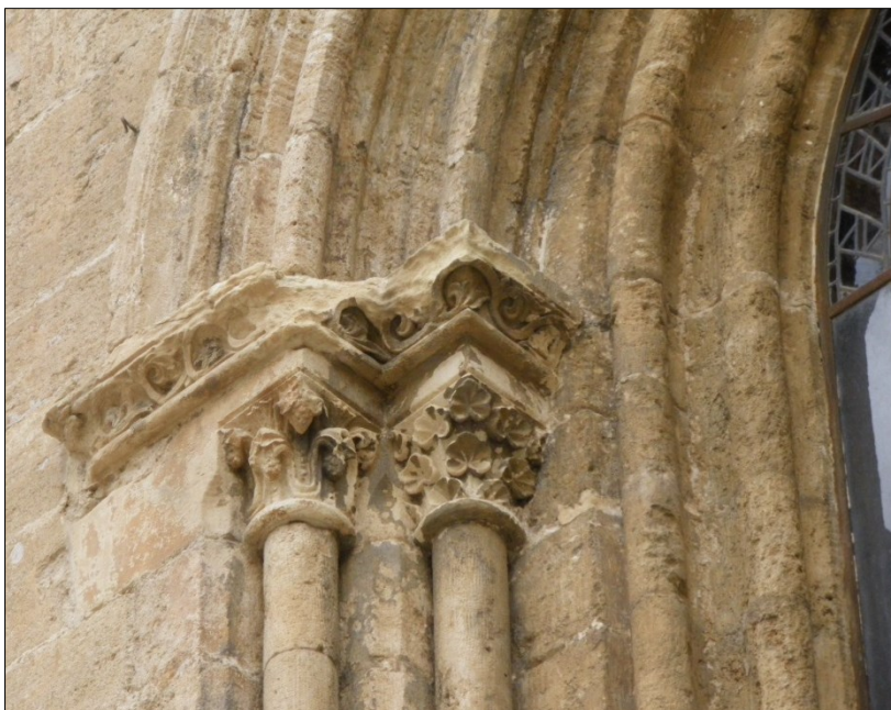
Fig. 58. Imposta y capiteles del lado izquierdo del ventanal de la sacristía.
