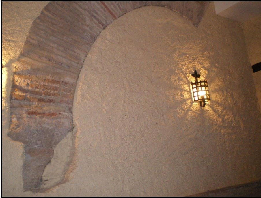
Fig.2. Muro lateral derecho de la capilla donde se aprecia el arco de ladrillo que arranca de imposta y capitel.
