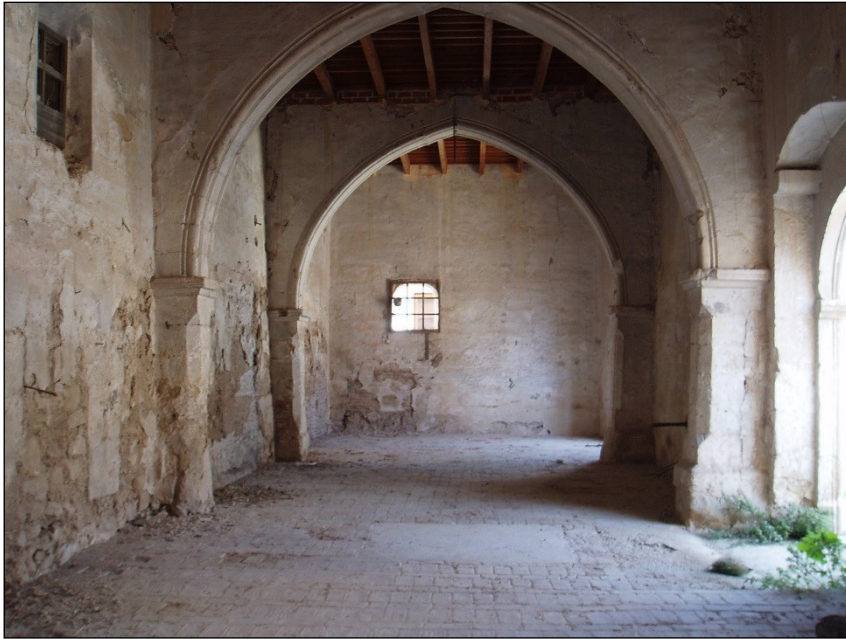
Fig. 3. Interior del salón, mirando hacia el oeste (2004).
