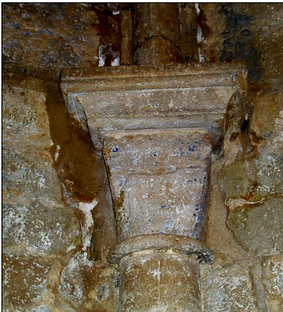
Fig. 17 Cuarto capitel del ábside (2004).
