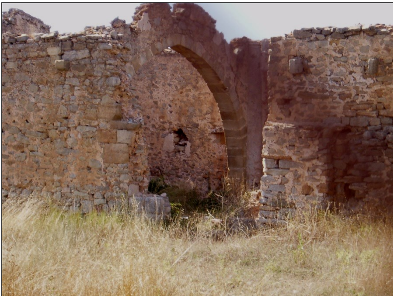
Fig. 5. Detalle del lugar donde se encontraba la portada y el último de los arcos diafragma.
