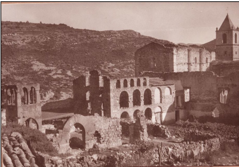
Fig.31. Fotografía anterior a la reconstrucción del monasterio que muestra a la izquierda los restos del palacio abacial (siglo XIV). El edificio de dos plantas con arcadas fue derribado (Archivo de la Cartuja).
