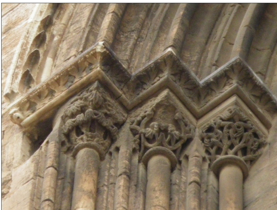
Fig. 50. Capiteles de lado izquierdo del ventanal sobre la portada del Palau.
