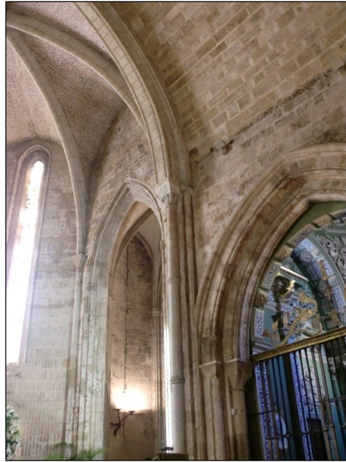
Figs. 14 y 15. Detalle del arco de ingreso, con la embocadura de la capilla de San Miguel (izquierda). La embocadura de la capilla nueva de Santa Bárbara (derecha) es una reconstrucción utilizando dovelas de otro conjunto.
