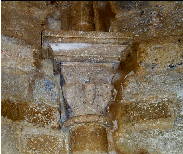
Fig. 16. Tercer capitel del ábside (2004).
