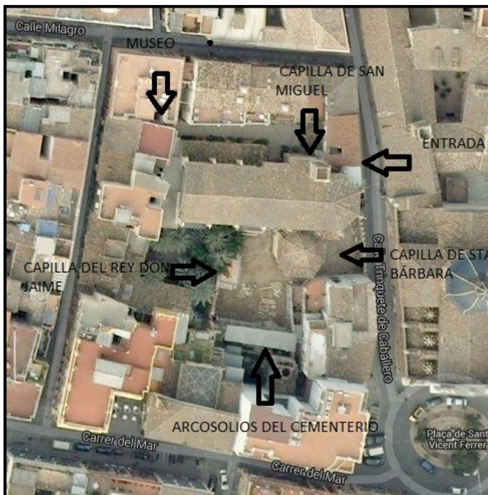
Fig.1. Vista aérea del conjunto con indicación de sus diferentes partes (foto: Google maps, 2013).
