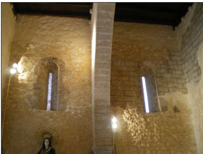
Fig.4. Ventanales abocinados situados en los dos primeros tramos del muro este.
