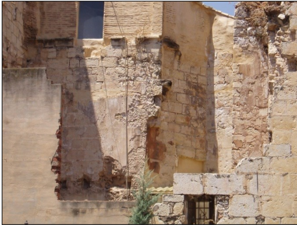
Fig. 4. Vista lateral desde el exterior del antiguo ábside.
