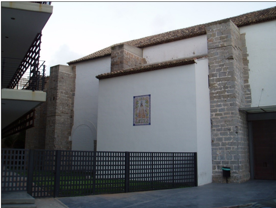
Fig. 6. Aspecto en la actualidad del lado exterior izquierdo, construido con tapial.
