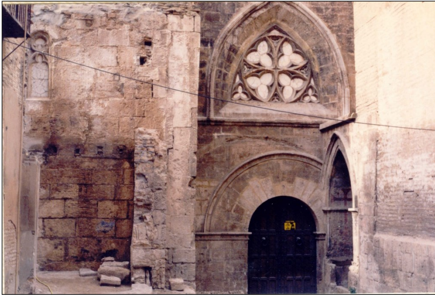
Fig. 34. Portada del muro sur y arcosolio adosado a su derecha (1997). Los arcosolios que faltan a su izquierda fueron reconstruidos posteriormente en estilo.
