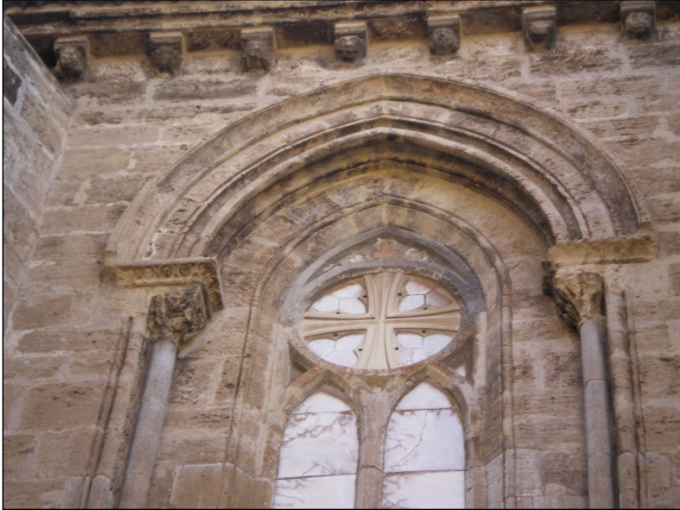
Fig. 19. Parte superior del ventanal central del ábside desde el exterior.
