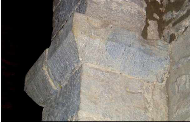
Fig.3 Detalle de una de las imposta de los pilares de la nave (2004).
