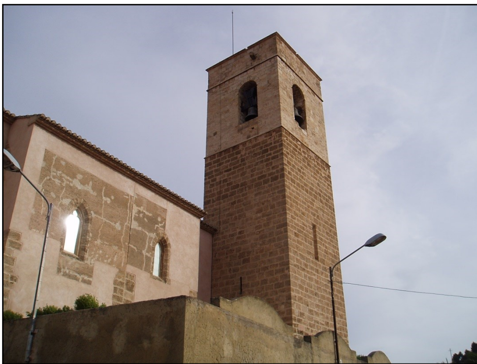
Fig. 3 Torre campanario, tras eliminar los añadidos de estilo barroco.
