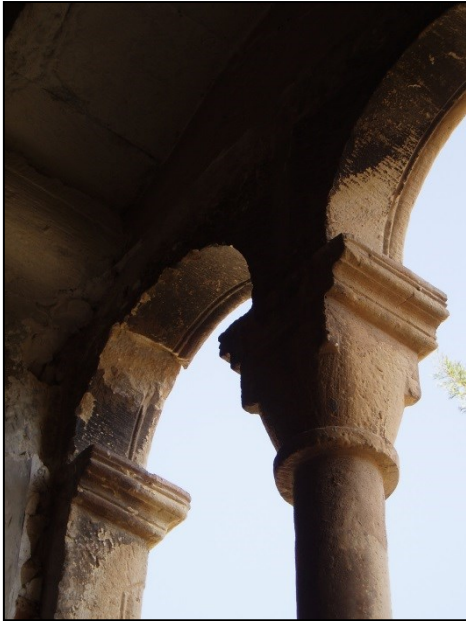
Fig. 8. Detalle de impostas y capitel del ventanal desde el interior (2004).
