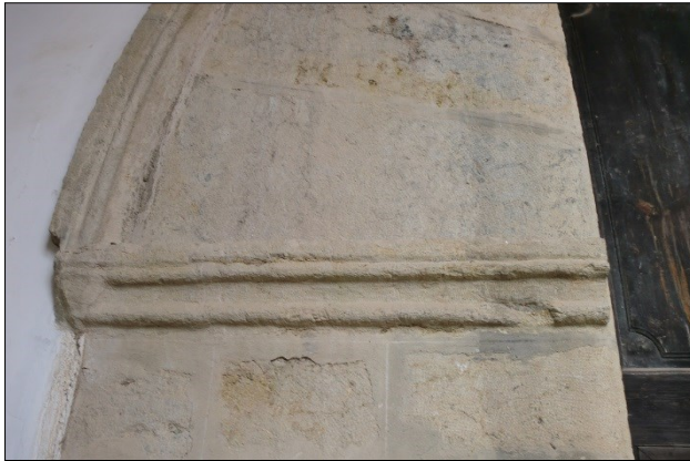
Fig.4. Detalle de imposta izquierda y cul-de-lamp.
