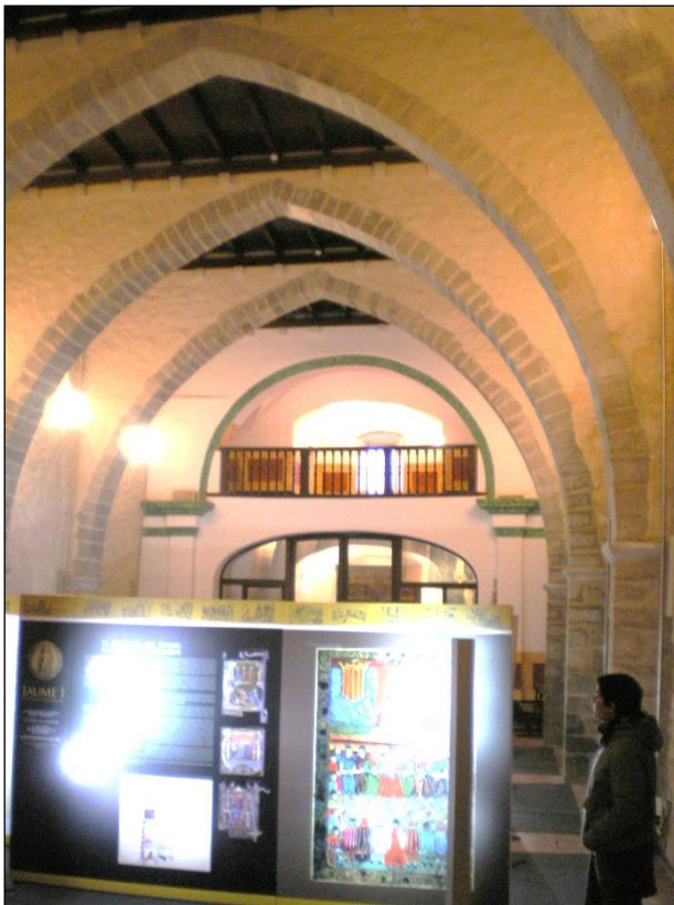
Fig. 3. Vista hacia el muro norte de los pilares e impostas sobre los que se tienden los arcos (2005)
