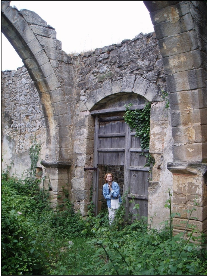
Fig.4 Vista de la portada desde el interior del templo con los pilares y arranques de dos arcos diafragma.
