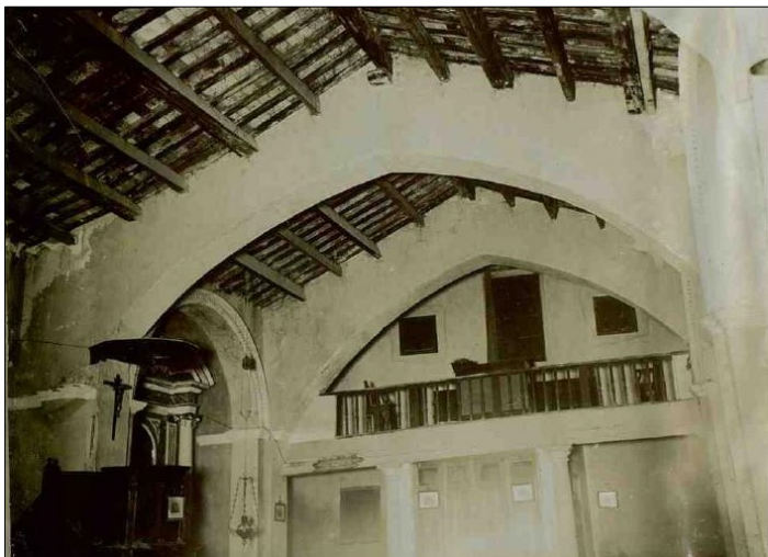
Fig. 1 Aspecto de la nave primitiva desde el presbiterio (fotografía Luis Tramoyeres, ca. 1917)
