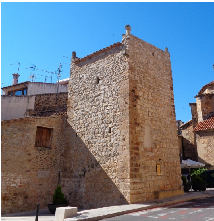
Fig.2. Vista posterior de la Torre de la Cárcel (2015).
