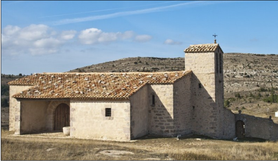
Fig. 1 Exterior templo desde el sur.
