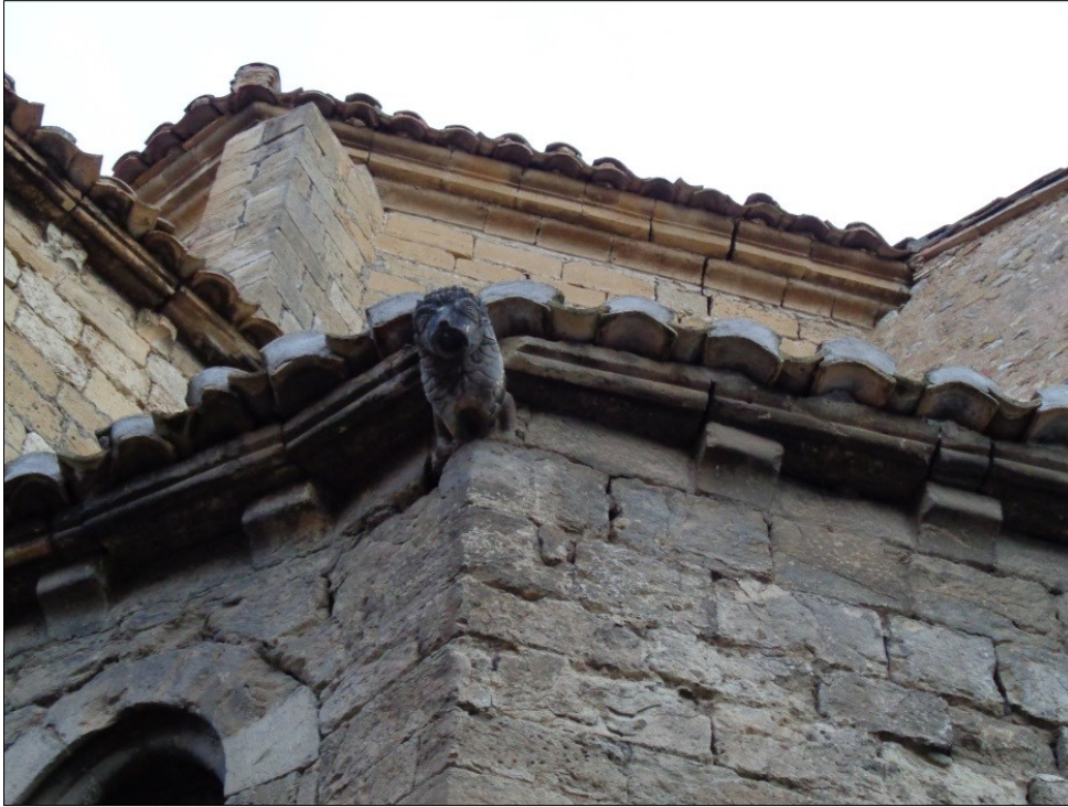
Fig. 4. Detalle de gárgola y canecillos en el exterior de una de las capillas que se abrían al ábside.
