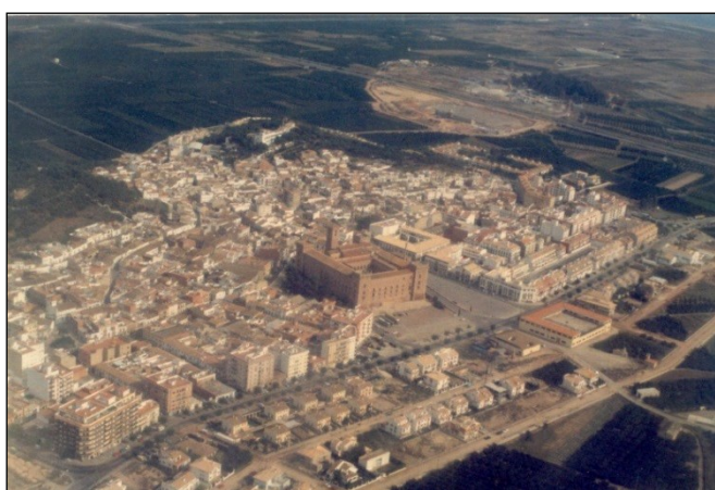
Fig. 1 Vista aérea del Puig ( 1991).
