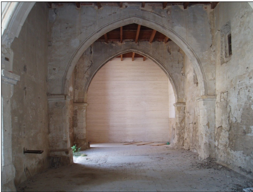
Fig. 4 Interior, mirando hacia el este (2004).
