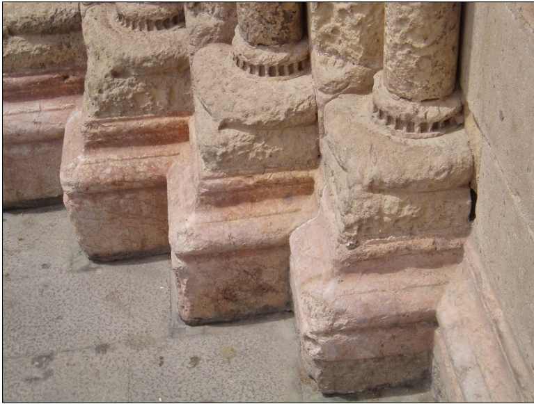
Fig. 13. Detalle de las basas y zócalo de la portada del Palau.
