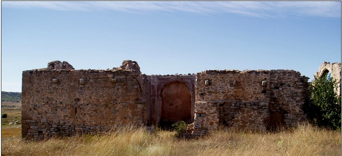
Fig. 1. Aspecto de la ermita desde su fachada SE (2004).
