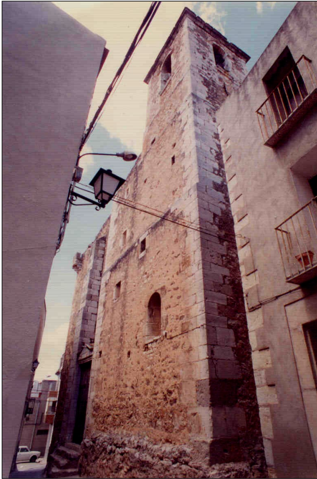
Fig. 3 Torre campanario y puerta practicada en el antiguo presbiterio construido en el siglo XVI (1994).
