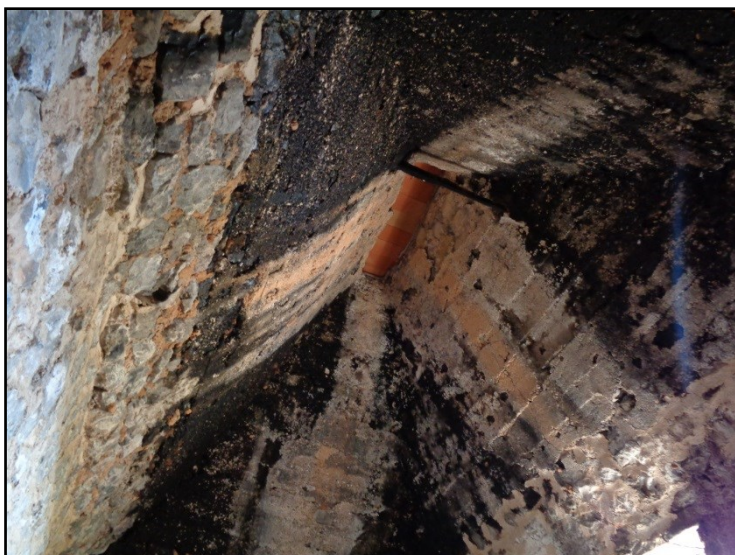
Fig.8 Cubierta de la planta superior del edificio adosado, bóveda (2015).
