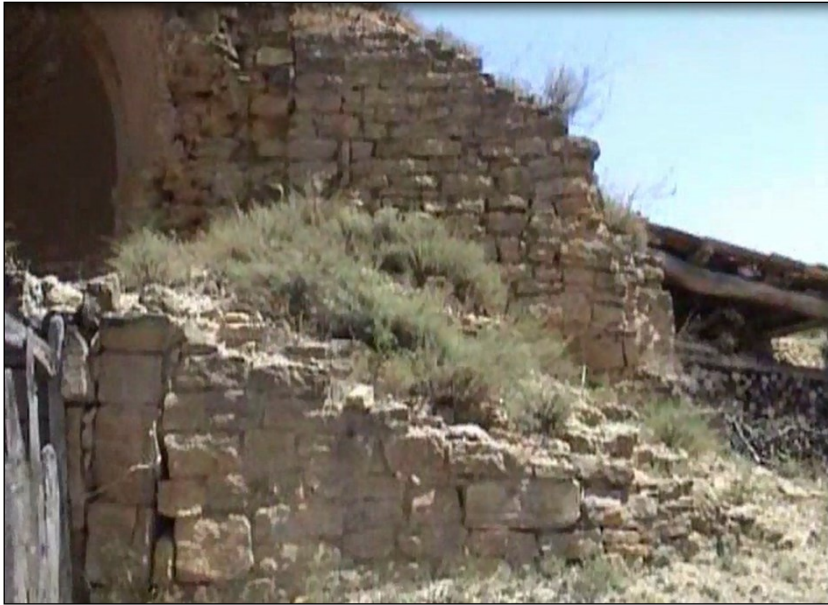
Fig. 6. Vista de restos de la portada soportados por materiales procedentes de muros y bóveda, así como de la torre en el muro norte
