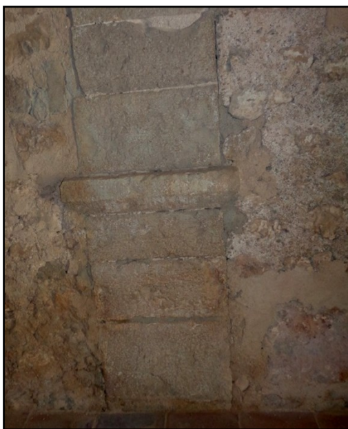
Fig. 5. Detalle de uno de los pilares del lado de la Epistola.
