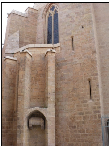
Fig. 8 Detalle de la base de la Torre del Caragol y del arcosolio encajado entre los contrafuertes de la primera absidiola (2010).
