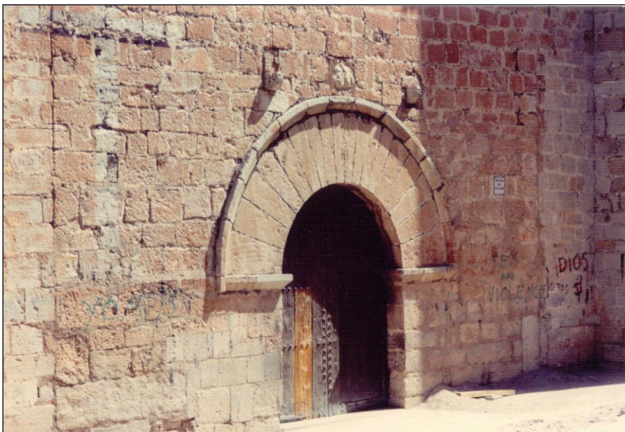
Fig. 3. Aspecto de la portada en 1992. El nivel del suelo era más elevado en el exterior, apreciándose perfectamente las dimensiones de la fachada de la iglesia primitiva. (Fot. F.J. Soriano)
