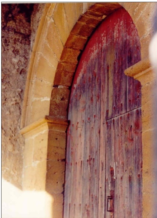
Fig. 4 Vista lateral de la portada.
