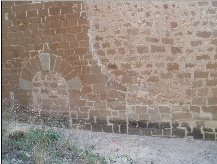
Fig.5. Aspecto de las dos portadas cegadas en el muro NE (2004).
