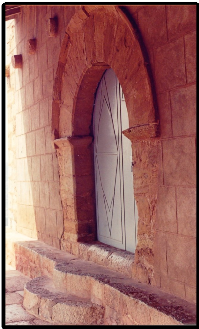
Fig.5. Vista lateral de la portada (2003).
