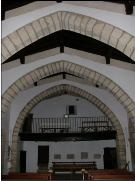
Fig.3 Vista de la nave hacia el coro (2012)
