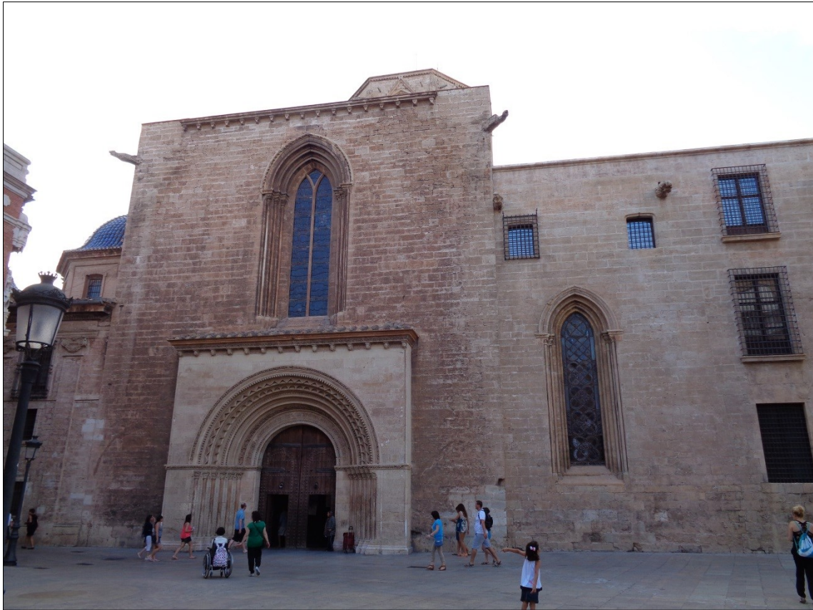
Fig. 11 Fachada sur de la catedral, con la puerta de la Almoína y el ventanal de la sacristía.
