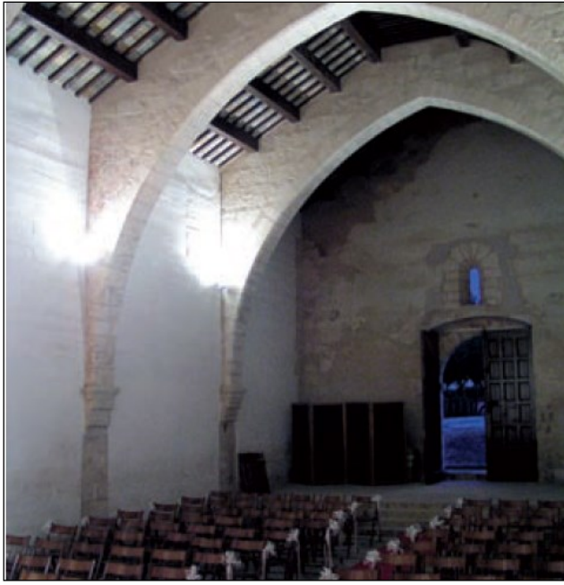
Fig.4 Interior mirando hacia el Este (Ayuntamiento de Carcaixent, 2008)
