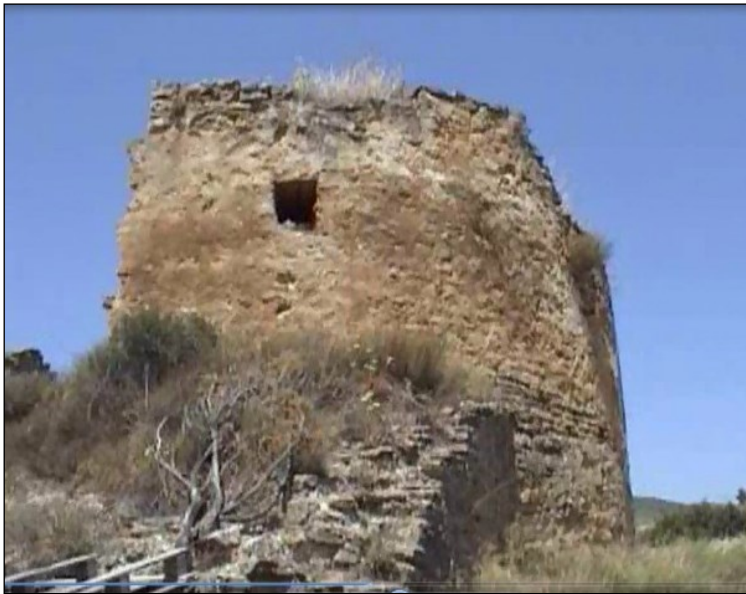
Fig. 11. Muro de la torre, conectado con el parapeto sobre el ábside, hoy totalmente enterrado.
