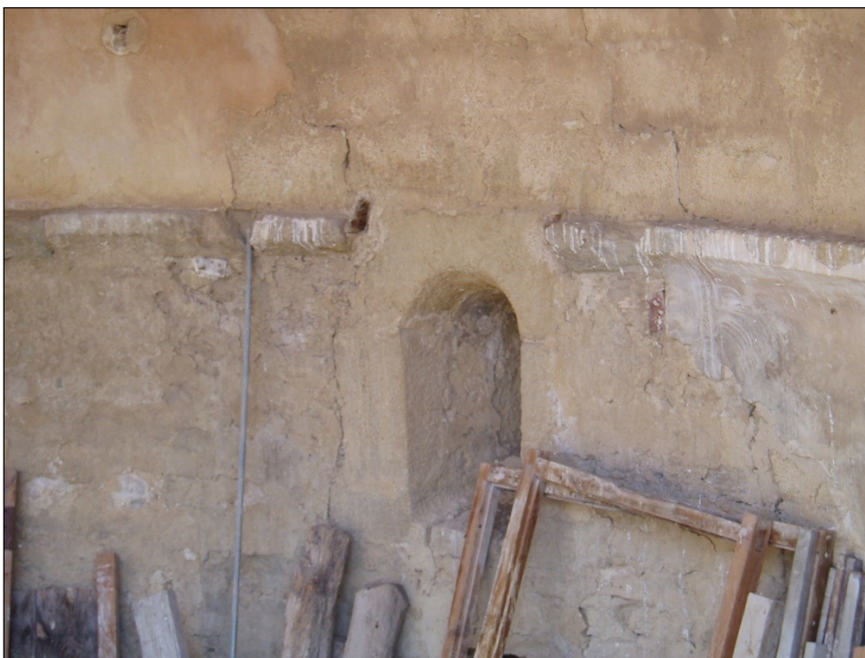
Fig. 4. Detalle de la ventana central del ábside y de la moldura que lo recorría.
