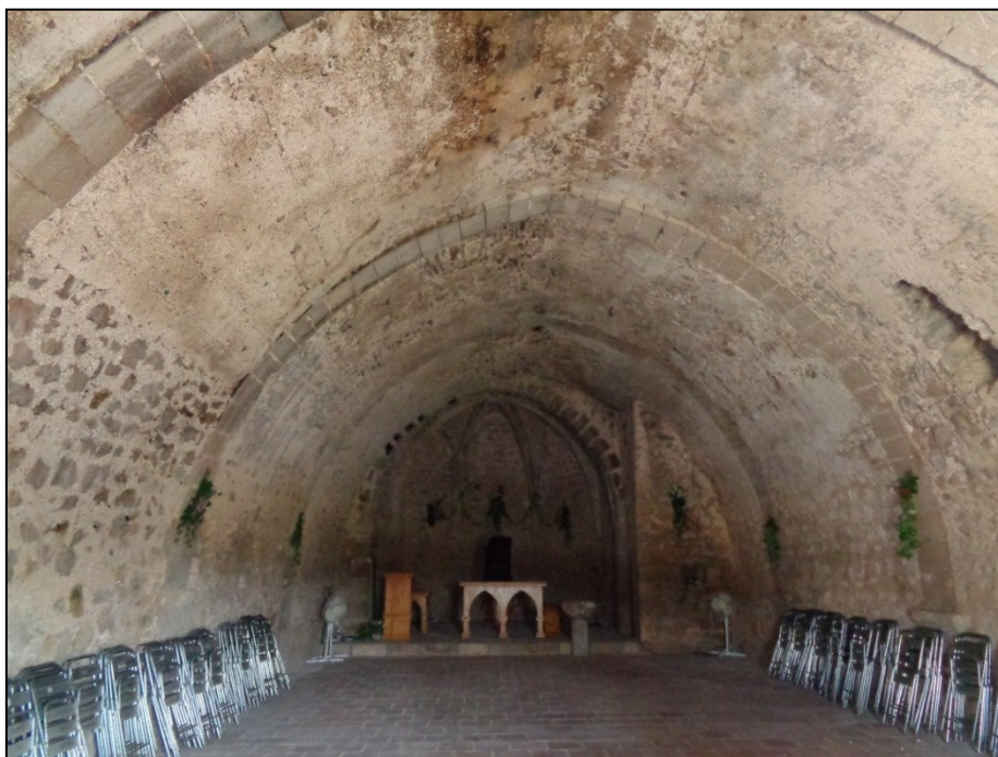
Fig.3 Vista del interior de la nave hacia el presbiterio. A la derecha, el acceso a la torre.
