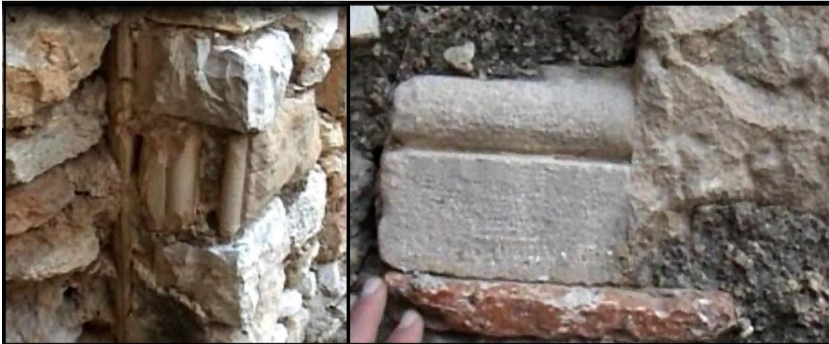
Fig. 10. Fragmentos de molduras medievales utilizadas como relleno en el muro de la capilla de Comuni3n. En la fotograf3a de la izquierda se aprecia el mismo tipo de moldura utilizado en la portada.
