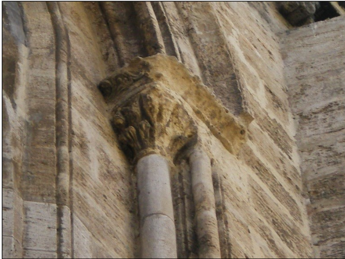
Fig. 21. Ventanal central del ábside. Detalle de imposta y capitel derecho.
