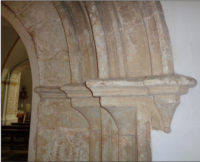
Fig. 13. Vista de capiteles, cul de lampe e imposta del lado derecho de la portada.
