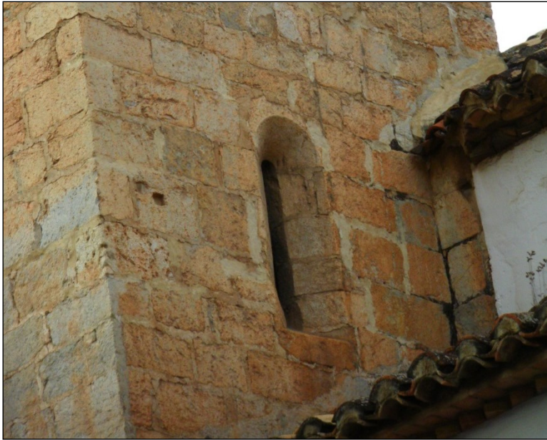
Fig. 5. Ventana abocinada de la torre campanario hacia el muro sur.
