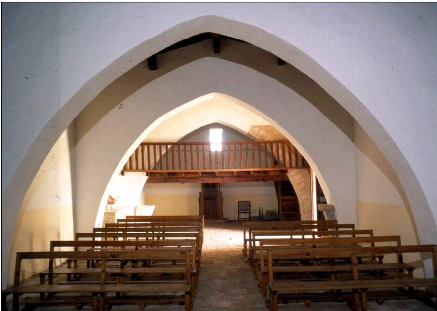
Fig. 2. Interior hacia el oeste .
