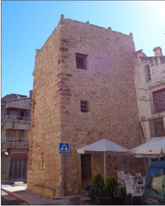
Fig.1. Fachada de la Torre de la Cárcel (2015).
