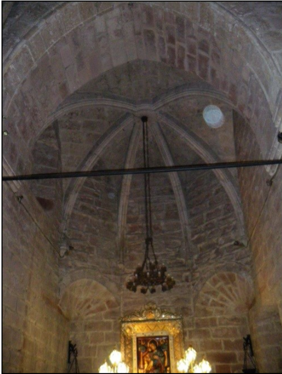
Fig. 7. Base de la torre campanario, con potente arco de entrada y bóveda sexpartita sobre trompas.
