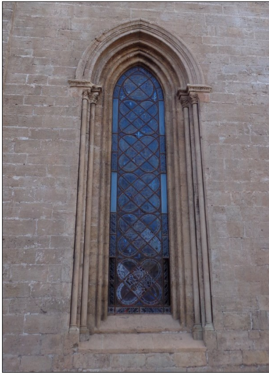
Fig. 56 Ventanal situado en la fachada sur, iluminando la sacristía.
