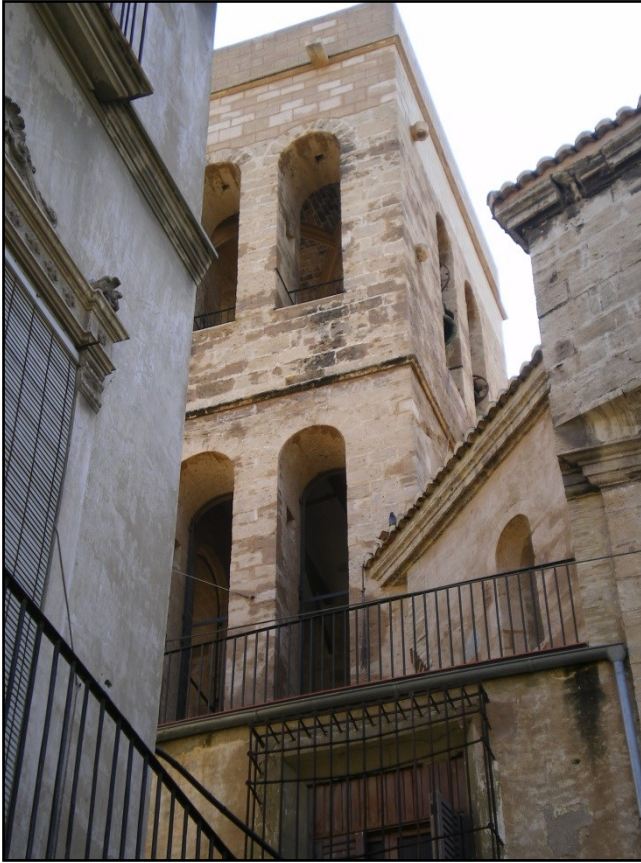
Fig. 3 .Torre campanario medieval de la iglesia tras su restauración.
