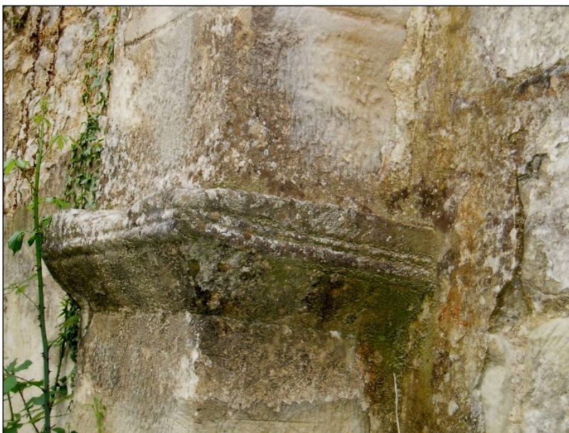
Fig.3 Detalle de imposta del interior del templo.
