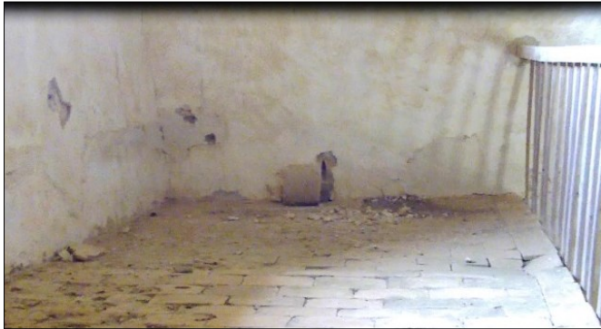
Fig. 11. Can medieval de piedra sobre el piso del coro.
