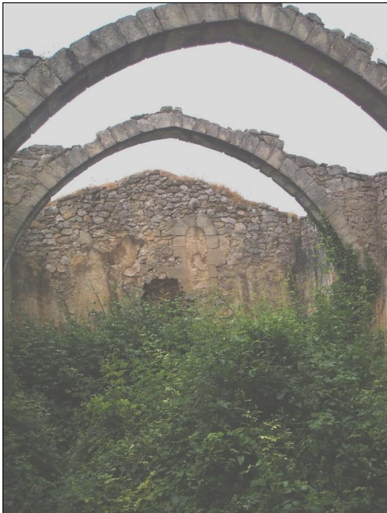
Fig.5. Vista del interior hacia el presbiterio.
