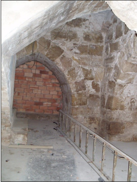
Fig. 13. Base de la torre. En el ángulo se aprecia un cul de lamp .
