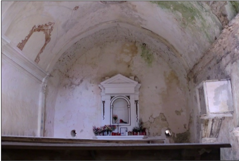
Fig. 5 Vista del interior hacia el presbiterio.
