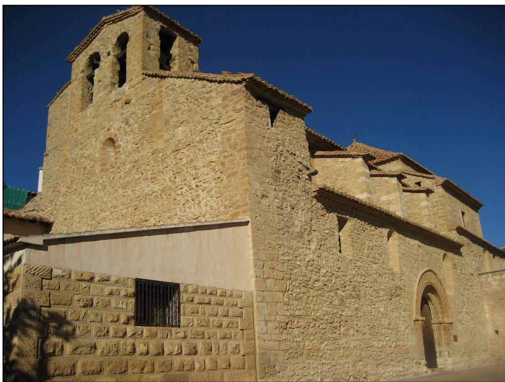
Fig.1. Vista de la iglesia en la actualidad desde el suroeste.
