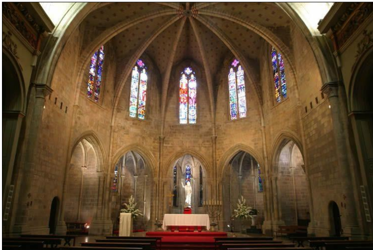
Fig.1 Aspecto del interior del ábside en la actualidad.
