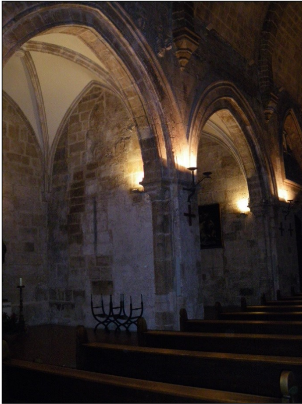
Fig. 28. Capillas laterales del muro norte del templo mirando hacia la cabecera.
