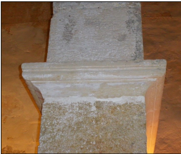
Fig.5. Detalle de una de las molduras de pilares del lado sur.
