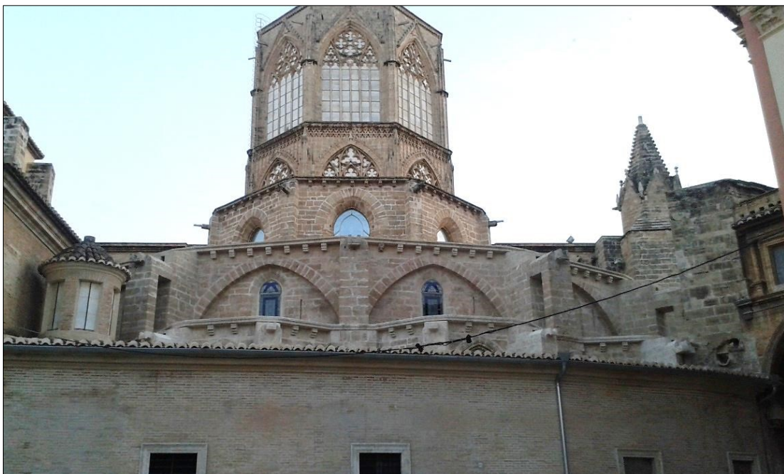
Fig.2. Aspecto exterior del ábside con su característico escalonamiento de volúmenes(2015).
