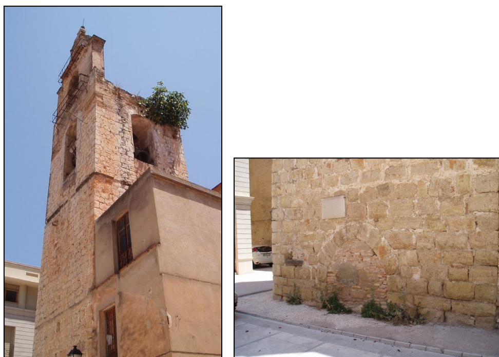
Fig. 12. Lado SW de la torre, cuerpo de campanas y basamento (2004).
