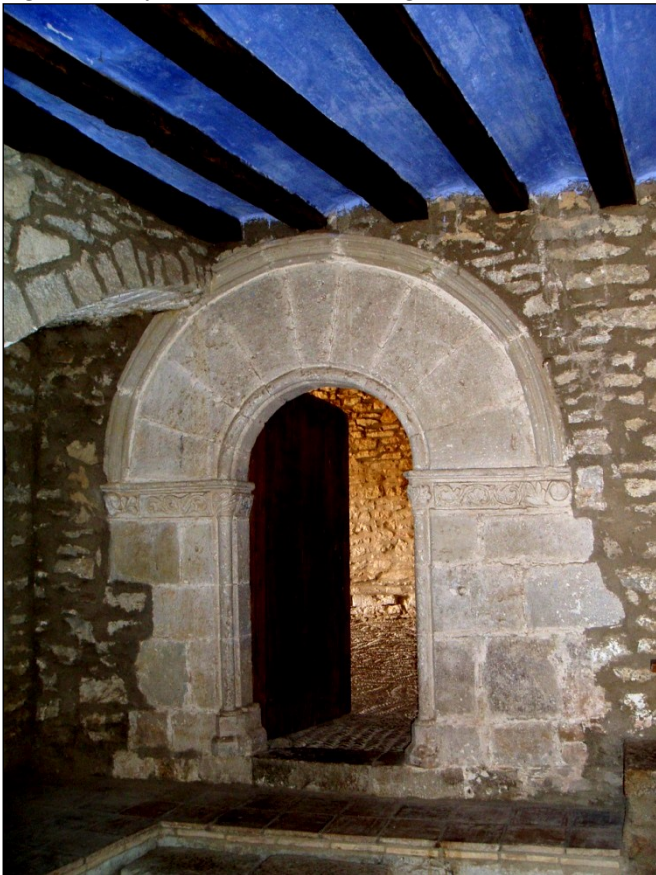
Fig. 6 Portada del templo que se abre en el muro sur (2004)
