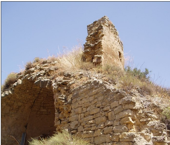
Fig 10. Vista del muro superpuesto al ábside desde abajo.
