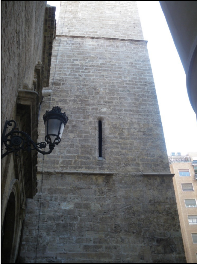
Fig. 6. Detalle del ventanal en el muro este de la torre.
