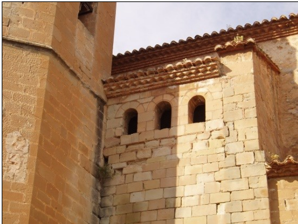
Fig 2. Fachada de la iglesia. Galería sobre la portada.
