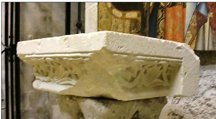
Fig.68. Vista lateral de la imposta, con la fractura en el ángulo.
