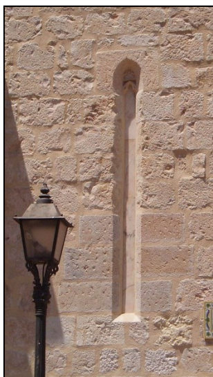
Fig. 10 Detalle de una de las ventanas situadas en el antiguo lado de la Epístola (2004)
