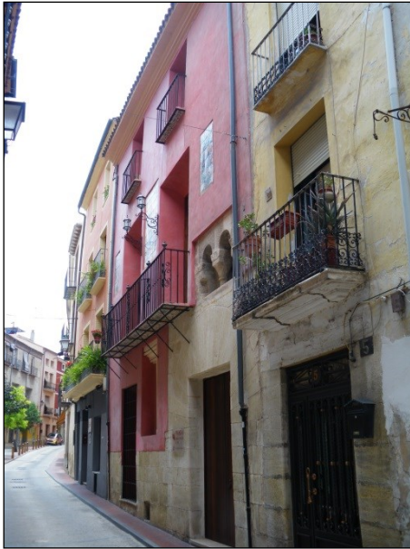
Fig.1 Fachada del edificio de la calle Mayor nº 3.
