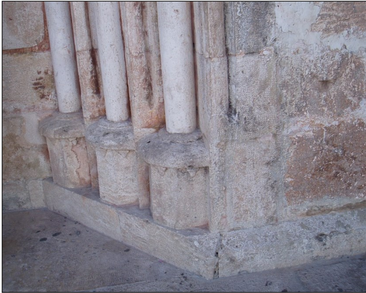
Fig. 15. Detalle del basamento moderno del lado derecho de la portada.
