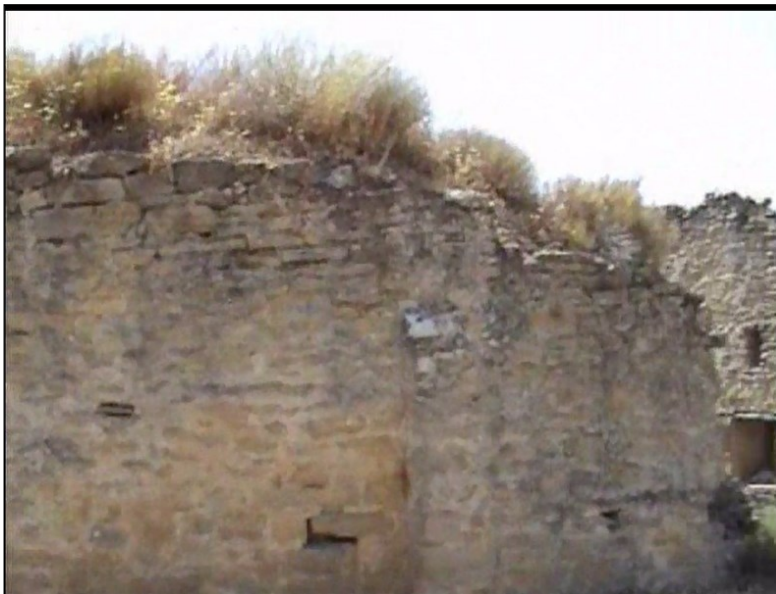
Fig. 12. Vista de la parte sur del parapeto, y al fondo, el testero, con el hueco cuadrado en forma de aspillera.
