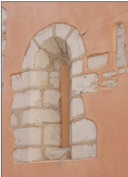
Fig. 2 Detalle del ventanal del muro sur en la actualidad.
