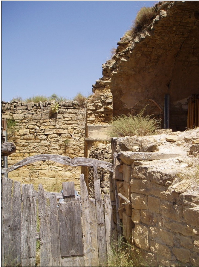
Fig. 5 Vista desde el muro norte. Se aprecia en primer plano restos de la parte derecha de la portada y el arranque del arco y resto de bóveda de cañón del primer tramo.
