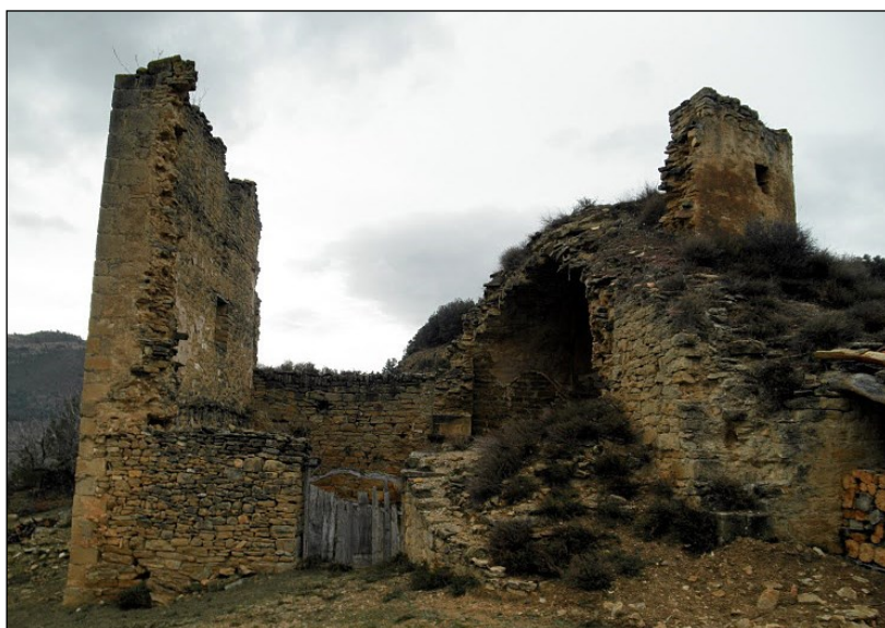
Fig 1. Vista del edificio desde el muro N.
