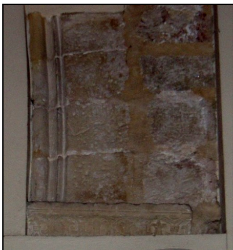
Fig.9. Arranque de arco diafragma de la nave. de capilla sobre imposta con roleos de cintas perladas, antiguo lado del Evangelio (2006).
