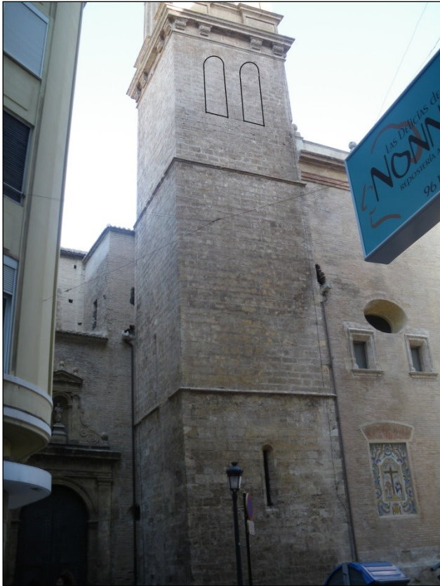
Fig.3. Vista general de la torre, con la puerta de San Pedro a su izquierda con el trazado de las antiguas ventanas del cuerpo de campanas ( Francisco J. Soriano).
