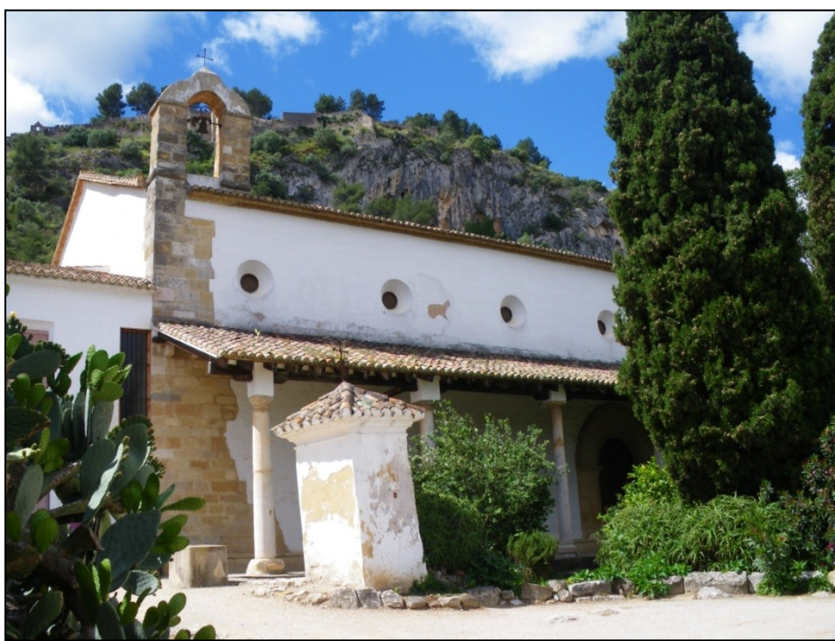
Fig.1. Exterior de la ermita desde el norte.
