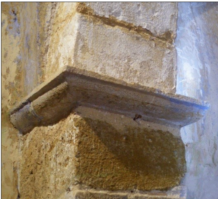
Fig.4. Detalle de la imposta de una de las pilastras del templo.
