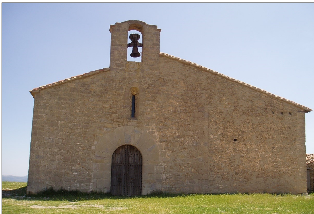
Fig. 1. Fotografía de la fachada oeste de la ermita de San Pedro.
