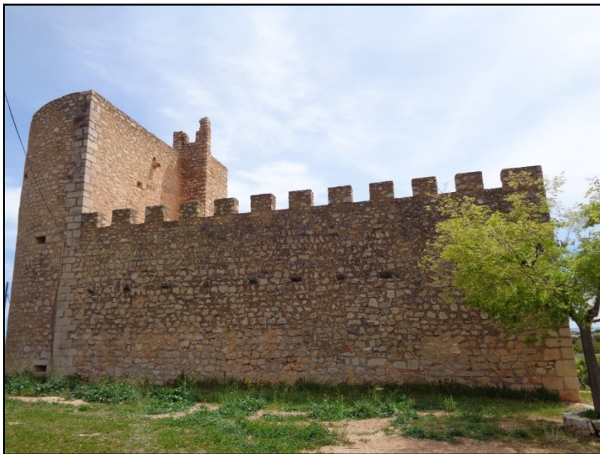
Fig. 2 Vista del lado exterior NO del edificio. La fila de canes indica la existencia de un porche. Obsérvese el resto de espadaña en la parte superior.
