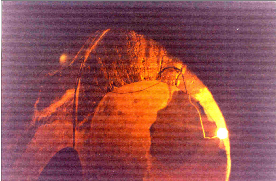
Fig. 5. Antiguo acceso a la torre, tapiado (1997).
