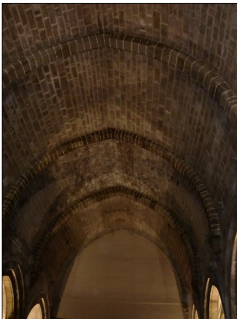
Fig. 13. Vista de las bóvedas de la nave mirando hacia el hastial.
