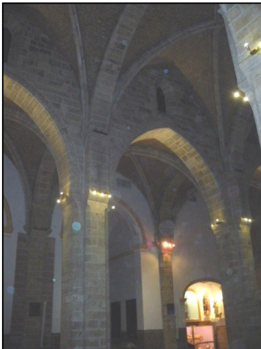
Fig. 6 Nave central y cuerpo de luces.
