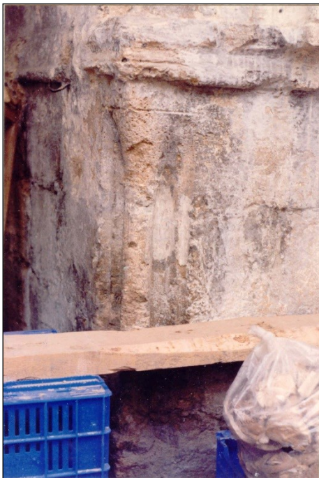
Fig. 36. Detalle de baquetón derecho en forma de columna adosada.
