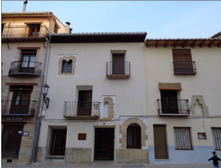
Fig. 1. Fachada de la casa n°11 de la plaza Mayor de Forcall (2015).
