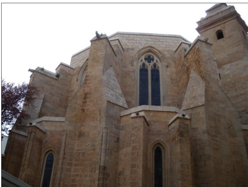
Fig.2 Aspecto exterior del ábside en la actualidad tras la eliminación de tejados, recreado de muros y reconstrucción de remates y detalles decorativos (2010)
