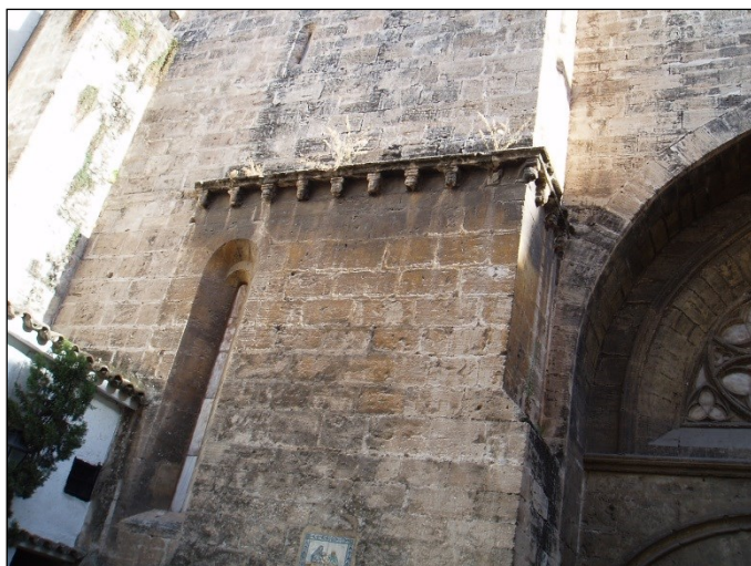
Fig. 5. Fachada norte de la capilla de San Miguel.
