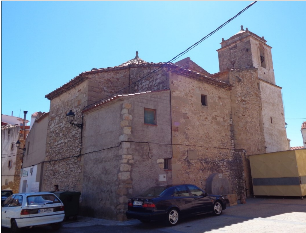
Fig. 2 Vista de fachada SO donde se aprecia la torre y ampliación con presbiterio.
