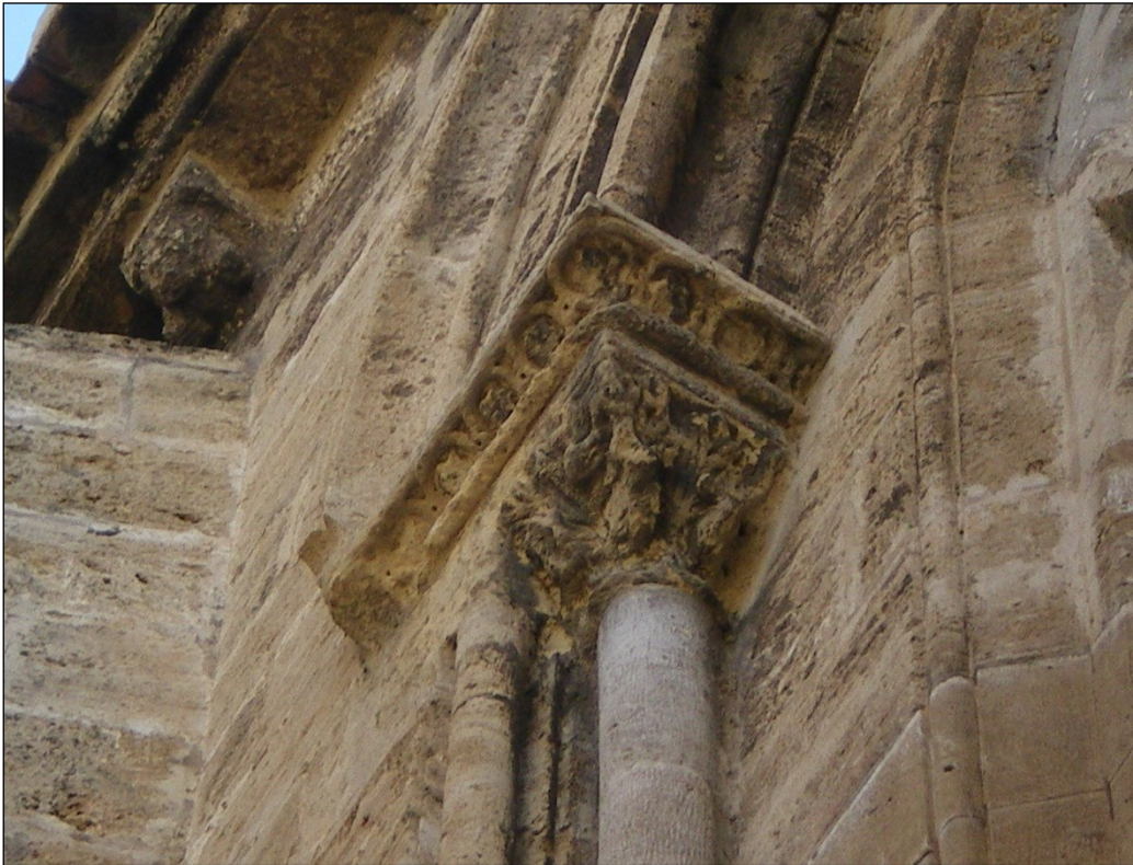
Fig. 20. Ventanal central del ábside. Detalle de imposta y capitel izquierdo.
