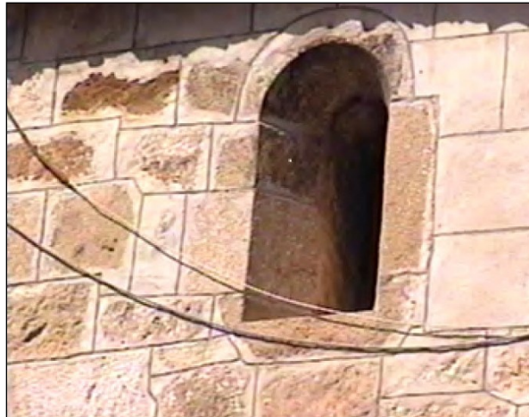
Figs. 5 y 6. Perfil de imposta en los pilares de la nave y ventana abocinada de la fachada.
