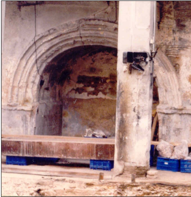
Fig. 35. Vista general del arcosolio nº 3 en 1997.
