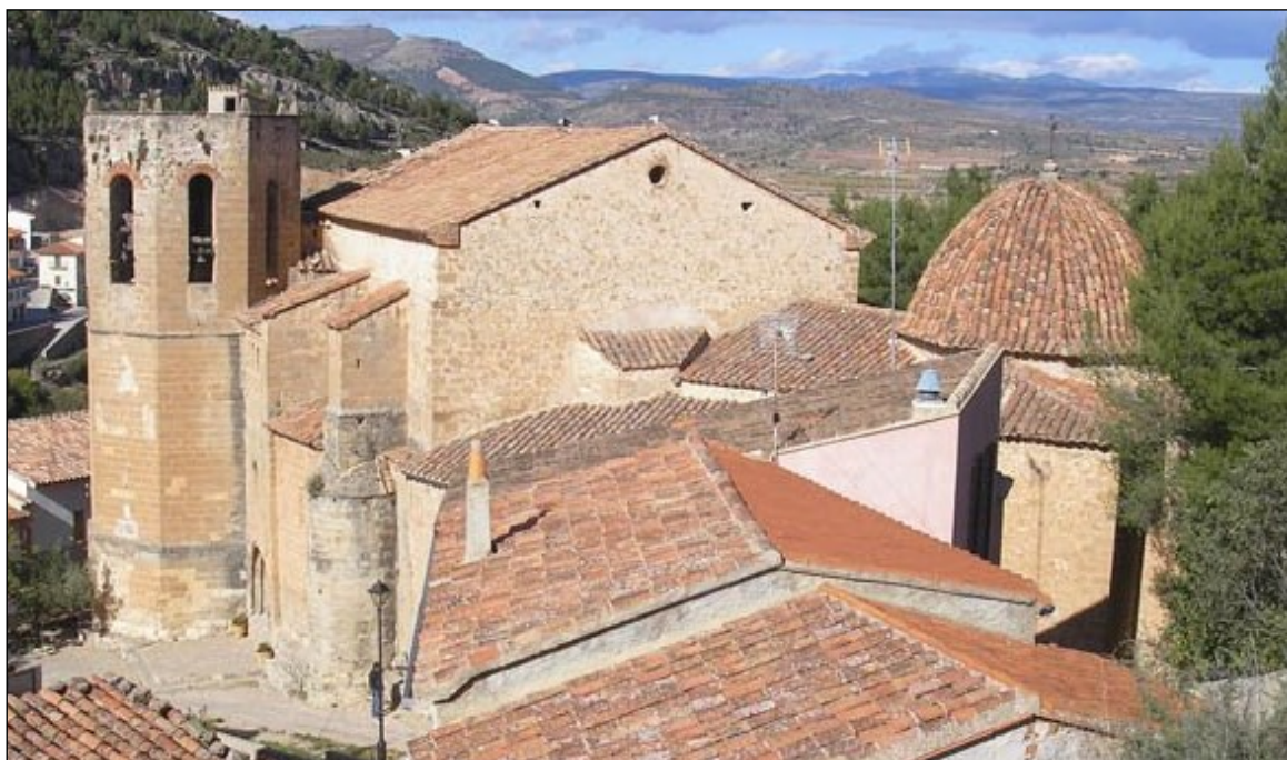
Fig.1. Vista de la iglesia.
