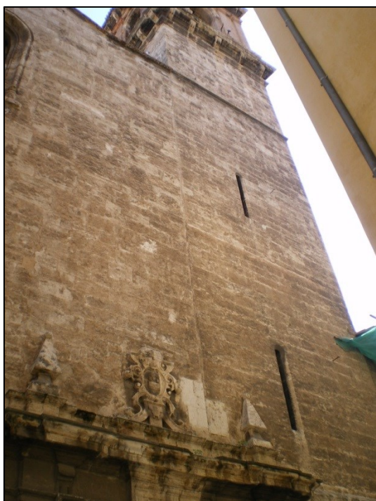
Fig. 3 Aspecto de la torre en su cara oeste (2007).
