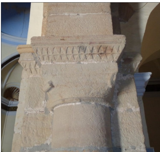
Fig.8 Detalle del capitel e impostas del pilar NO junto al antiguo presbiterio.
