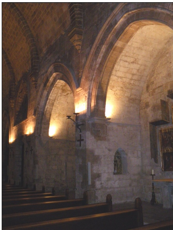
Fig. 24. Vista de las capillas del lado sur, con la puerta de acceso al cementerio.
