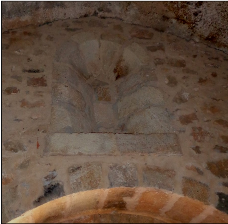
Fig.4. Detalle de la ventana sobre la puerta de entrada.
