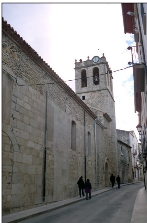
Fig. 1. Exterior de la iglesia en el carrer Major. Se aprecian las capillas cortadas para su ensanche.
