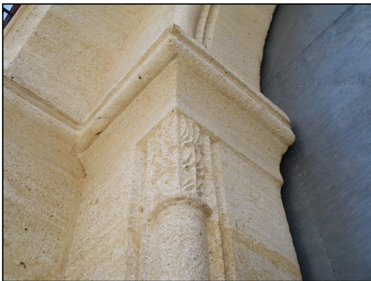
Fig.6 Detalle del capitel izquierdo y detalle de la imposta.
