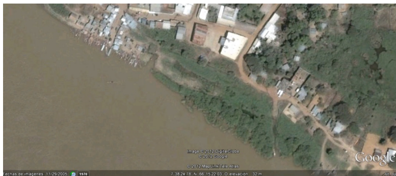
Figura IV.5.1. Imagen del puerto de Cabruta (Guárico), con elevación del nivel de base del río Orinoco (Google Earth, 2012).
