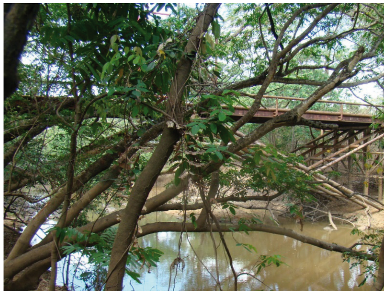
Figura IV.2.24. Puente sobre el río Zuata en época seca.
