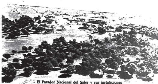
El Parador Nacional del Saler y sus instalaciones
