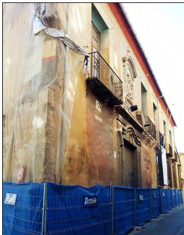
Figura 16: Obras de restauración en el Colegio del Arte Mayor de la Seda de Valencia.
