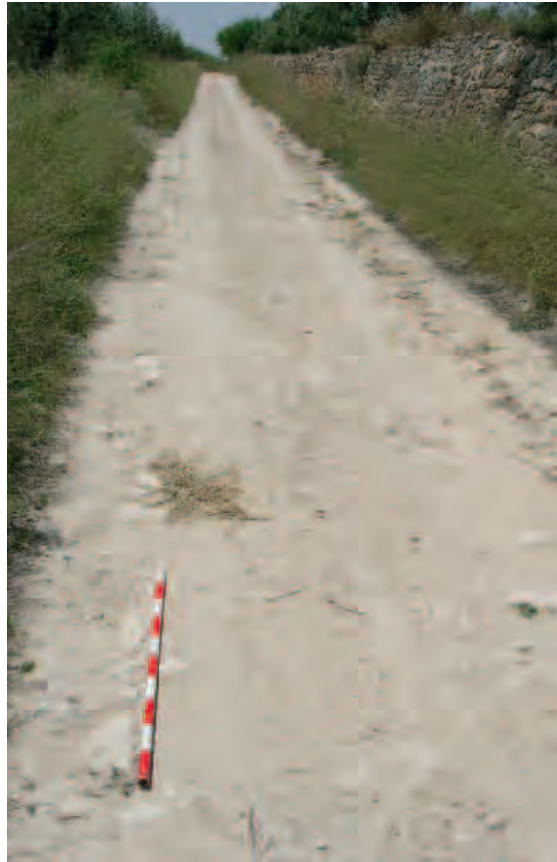
Hilada de piedras correspondiente a uno de los umbones de la vía (Moixent). Fotografía de F. Arasa.
