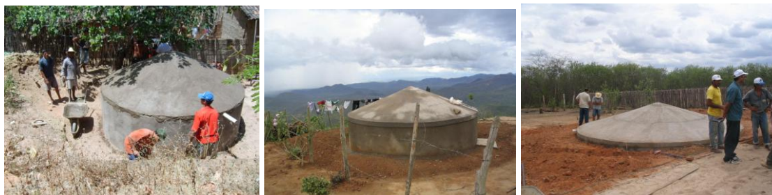
Ilustración 10: Construcción de cisternas en el semi-arido
