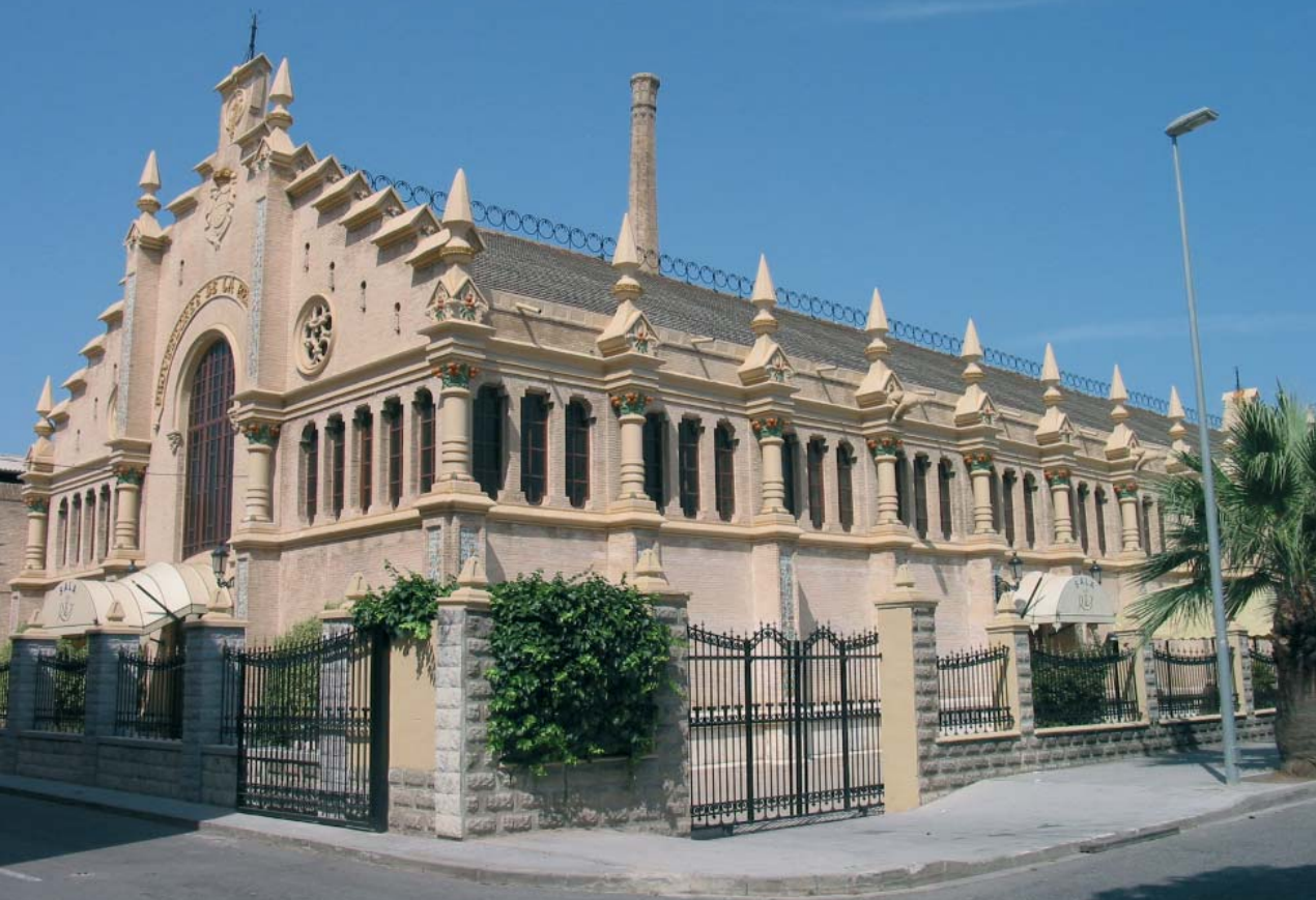
Antic magatzem de taronja de Peris Puig a Alzira, rehabilitat com a saló de banquets.
