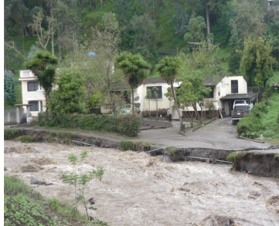
Foto 6.5: Afectaciones de crecidas del río Guaranda, sector Los Molinos, sector el Peñón (DPGR-B, 20/04/2012)
