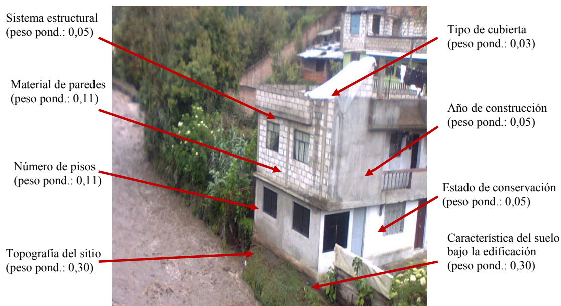
Figura 6.26 Indicadores con pesos de ponderación para evaluar la vulnerabilidad de edificaciones ante la amenaza de inundación
