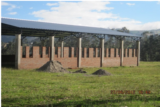
Foto 7.23: Galpón en construcción abandonado en el área del Parque Industrial de Guaranda, 2012
