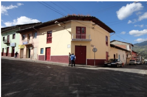
Foto 7.9: Edificación patrimonial (particular), Centro Histórico de Guaranda, localizado en zona de amenaza alta a sismos por problemas geotécnicos (calidad de suelo), 2013
