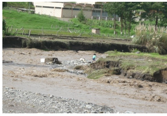
Foto 6.7: Afectaciones de crecidas del río Guaranda, parte sur del sector Marcopamba (DPGR-B, 20/02/2012)
