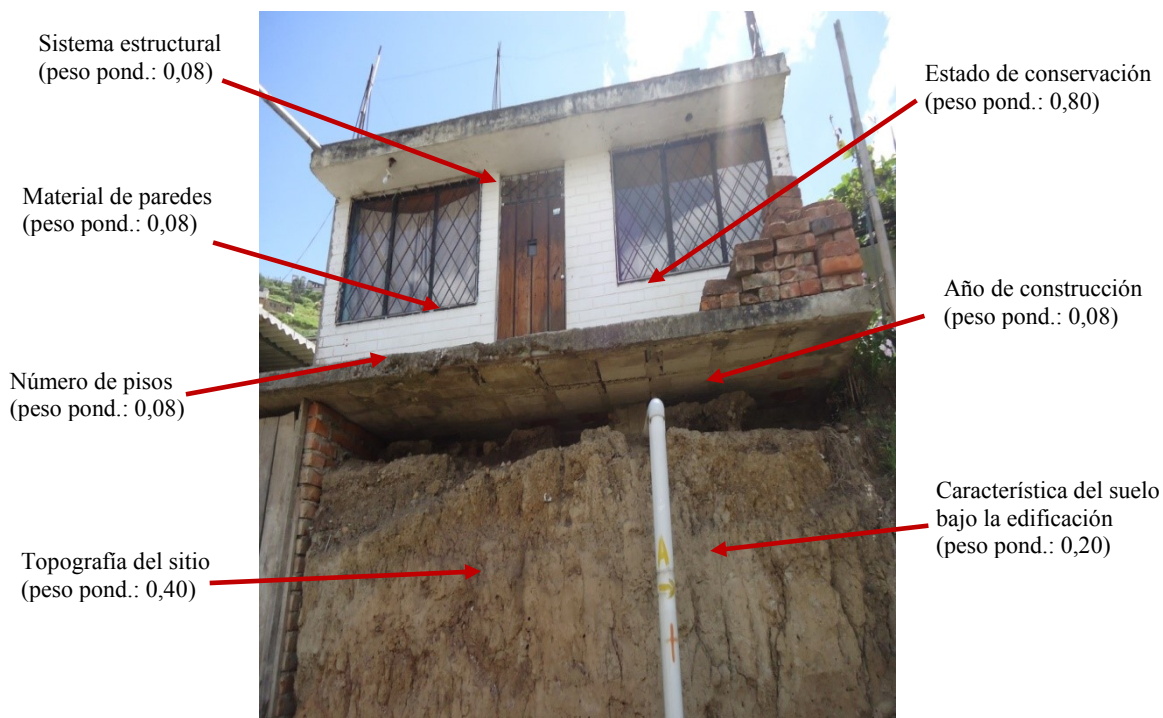
Figura 6.25 Indicadores con pesos de ponderación para evaluar la vulnerabilidad de edificaciones ante la amenaza de deslizamientos
