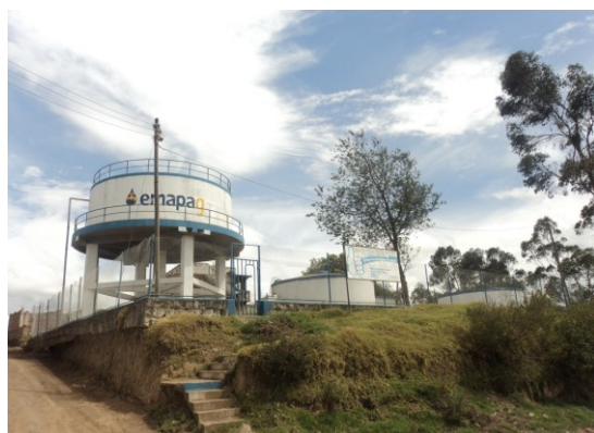
Foto 6.16 Tanque de distribución de agua, sector Guanujo. Arellano (tesis UEB, 2013)
