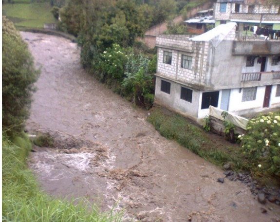
Foto 6.4: Afectaciones de crecidas del río Guaranda, barrio Los Molinos, sector el Peñón (DPGR-B, 20/04/2012)
