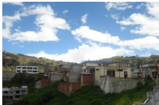
Foto 7.14: Edificación localizada en zona de amenaza alta por problemas geotécnicos (calidad de suelo), sector Guanguliquin, 2013
