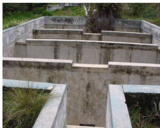
Foto 6.19 Planta de tratamiento de aguas servidas abandonadas de EMAPA-G. Paucar, 2013
