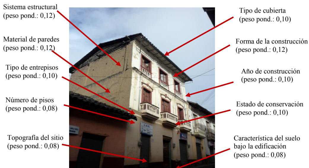
Figura 6.24 Indicadores con pesos de ponderación para evaluar la vulnerabilidad de edificaciones ante la amenaza de sismos
