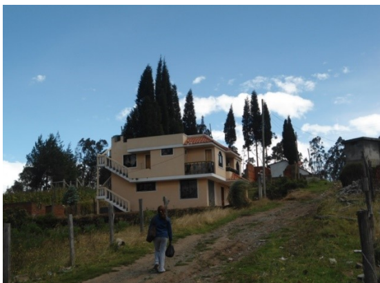
Foto 7.17: Edificación en zona urbanizable con nivel medio de amenaza a sismos y deslizamientos, sector Joyocoto, 2013
