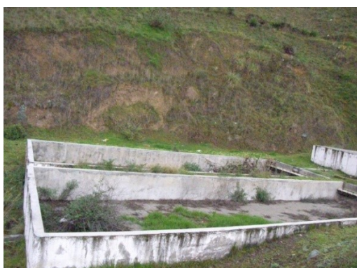
Foto 6.18 Planta de tratamiento de aguas servidas abandonadas de EMAPA-G. Paucar, 2013
