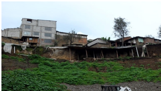
Foto 7.11: Edificaciones localizadas en laderas de la colina San Jacinto con amenaza alta a sismos y deslizamientos, sector 5 de junio, 2013
