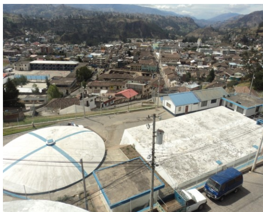
Foto 6.14 Tanque de distribución de agua, sector Los Tanques. Arellano (tesis UEB, 2013)
