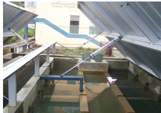
Foto 6.13 Tanque tratamiento (cloración), sector Chaquishca. Arellano (tesis UEB, 2013)
