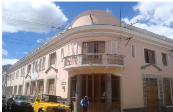
Foto 7.10: Edificación de Hospital antiguo, Centro Histórico de Guaranda, localizado en zona de amenaza alta a sismos por problemas geotécnicos (calidad de suelo), 2013
