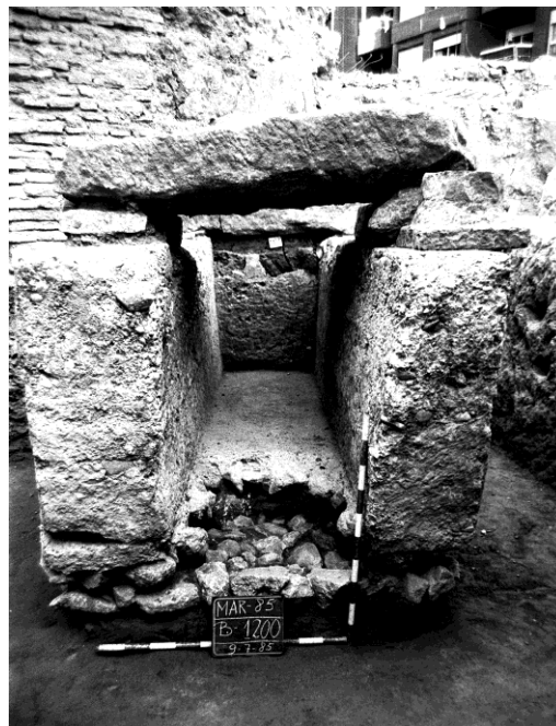
Figura 85: Final del canal de la cloaca on s'hi pot observar els procés constructiu.
