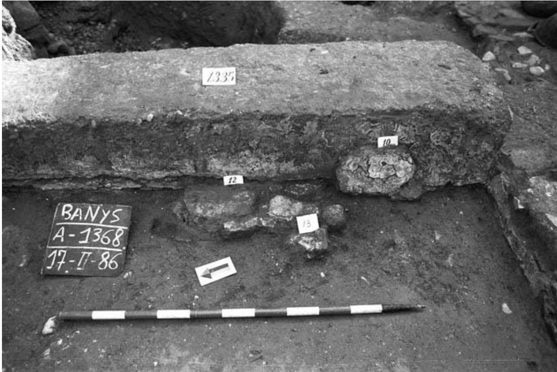
Figura 58: Estrats d'abandonament i enderroc de l'edifici nord datats en el segle III dE. Arxiu SIAM.
