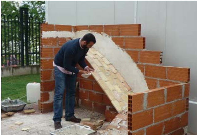
Figura 7. Proceso de ejecución de la primera rosca del segundo tramo de una escalera tabicada (IV). Curso 2011-12.
