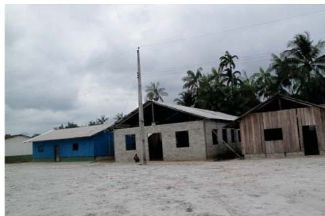
Figura 3. Habitaciones nuevas, de madera y cubierta de asbesto-cemento. Fotografía: Ida Hamoy, 2010.
