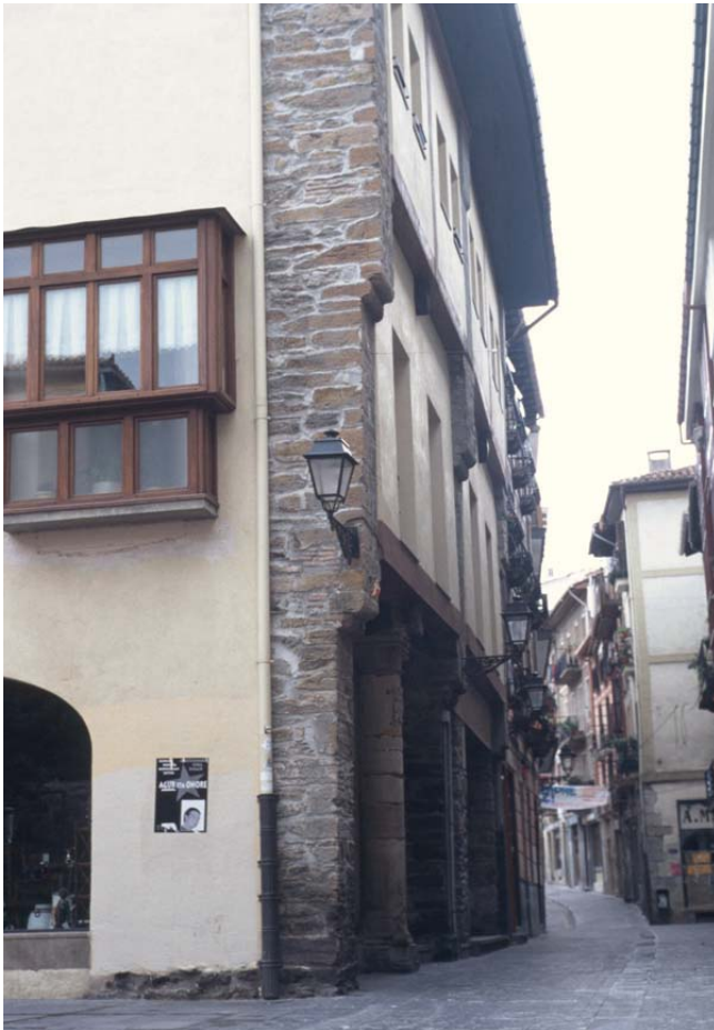
Figura 5. Perfil de una casa de la calle Ferrerías. Se notan los voladizos de medio codo de longitud por planta. Fotografía: Ana Isabel Ugalde.
