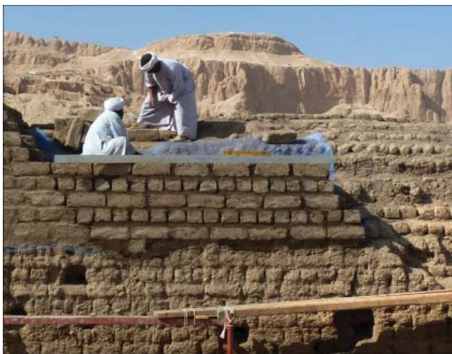
Figura 3. Conservación del muro de adobes. Fotografía: Fathy Yaseen. Inspector.
