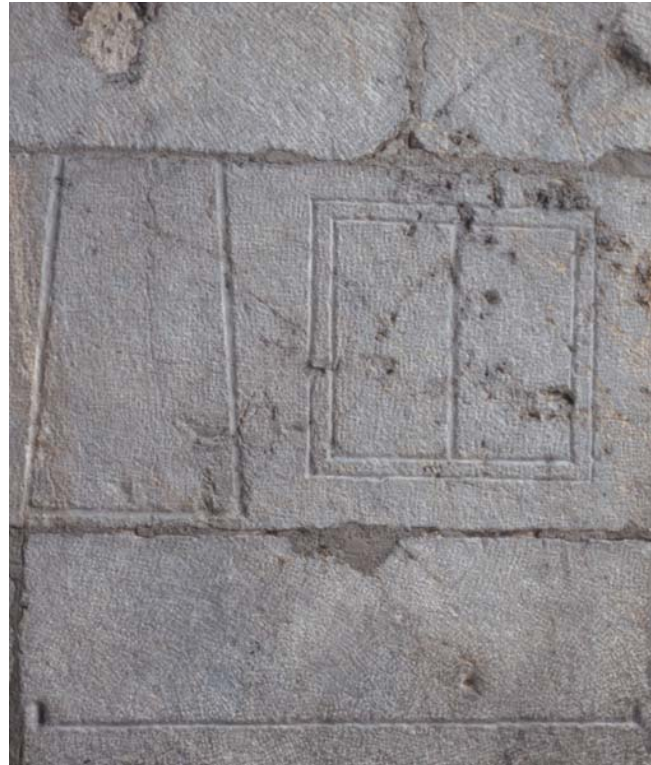
Figura 10. Medidas grabadas en un pilar de los soportales del ayuntamiento. Molde de teja, de ladrillos (doble) y medida de la vara.
