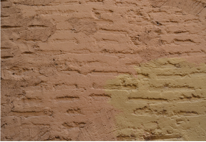
Fig. 80. (Arriba) Detalle de muro de tapia valenciana en la fachada norte del palacio de los Ruiz de Alarcón.
