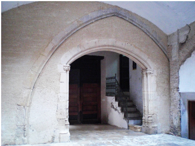
Fig. 40. Vista de la entrada de la casa Fenollet desde el patio.
