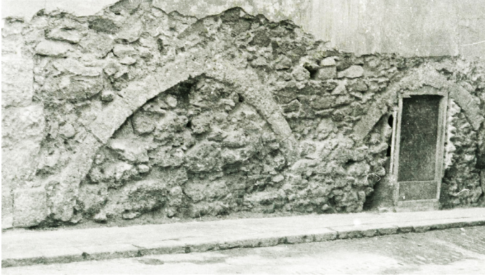
Fig. 38. Arcos apuntados en la fachada de la casa de los Pardo.
