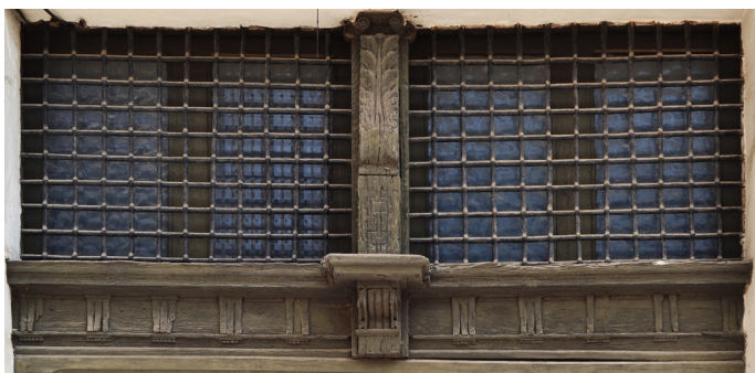
Fig. 77. (Arriba) Detalle de carpintería renacentista en la casa del conde de Olocau.
