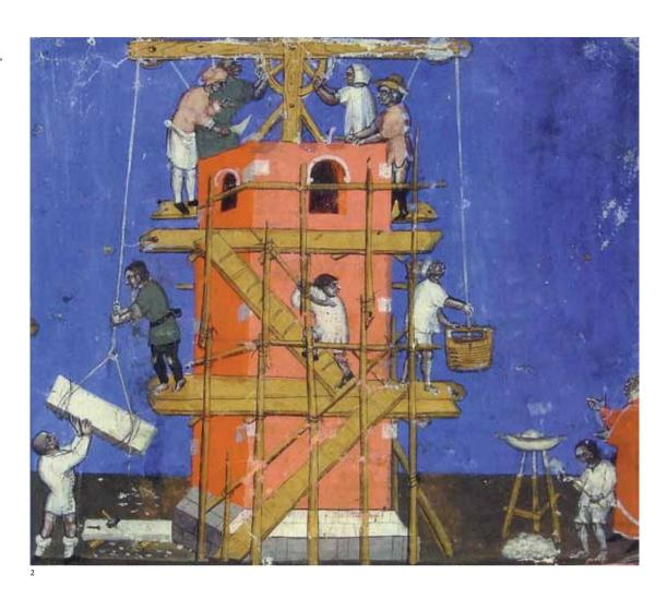
los materiales con garantías. La estabilidad del andamio se aseguraba en el suelo mediante estacas que servían para tensar las cuerdas y dotar al conjunto de la máxima elasticidad y firmeza ante la acción del viento. Estas estacas en forma de cuña se contemplan raramente en la contabilidad, salvo alguna mención recogida en textos ingleses donde vienen indicadas con los vocablos *warroks* o *warrokes*<sup>24</sup>.
