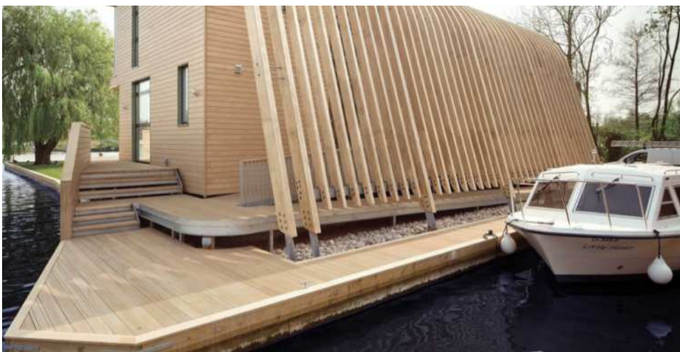
Utilización en construcción de casas sostenibles. Madera acetilada laminada Reino Unido 2 .
