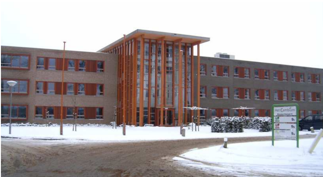
Utilización en fachadas y estructuras de edificios. SHR Wageningen (Países Bajos) 1 .
