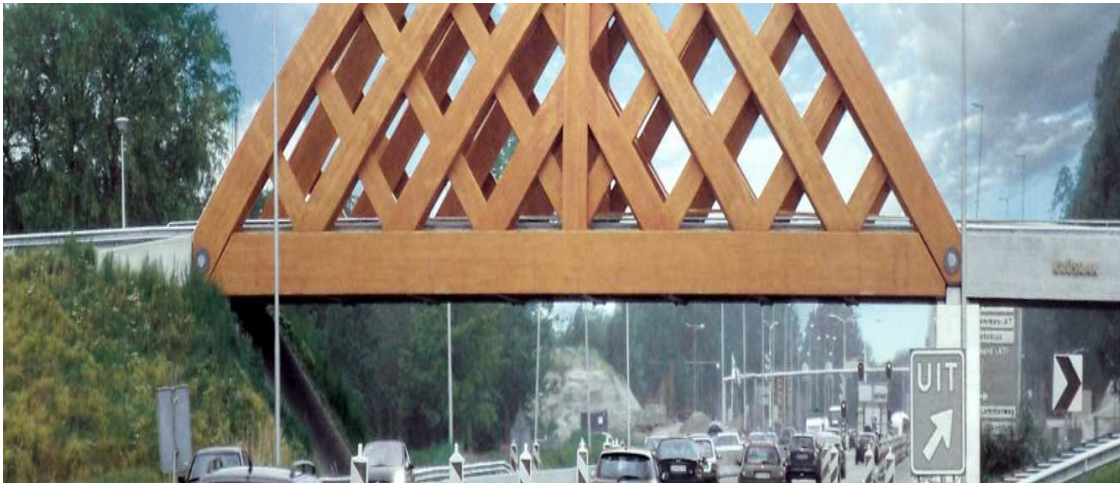
Puente para paso de vehículos. Madera acetilada laminada. Países Bajos 2 .
