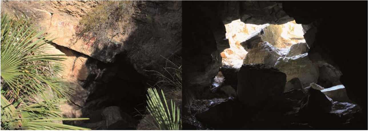
Fig. 4.102. Boca de entrada a la cavidad: vista desde el exterior (izquierda) y desde el interior, donde se observan los desprendimientos actuales (derecha).
