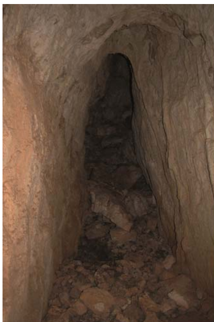
Fig. 4.127. Posible acceso en la zona Suroeste, actualmente bloqueado por un desprendimiento.
