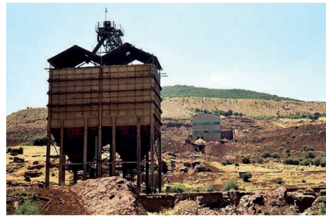
Sierra Menera. Tolvas de carga sobre vagón y nave de clasificación de mineral, 2000
