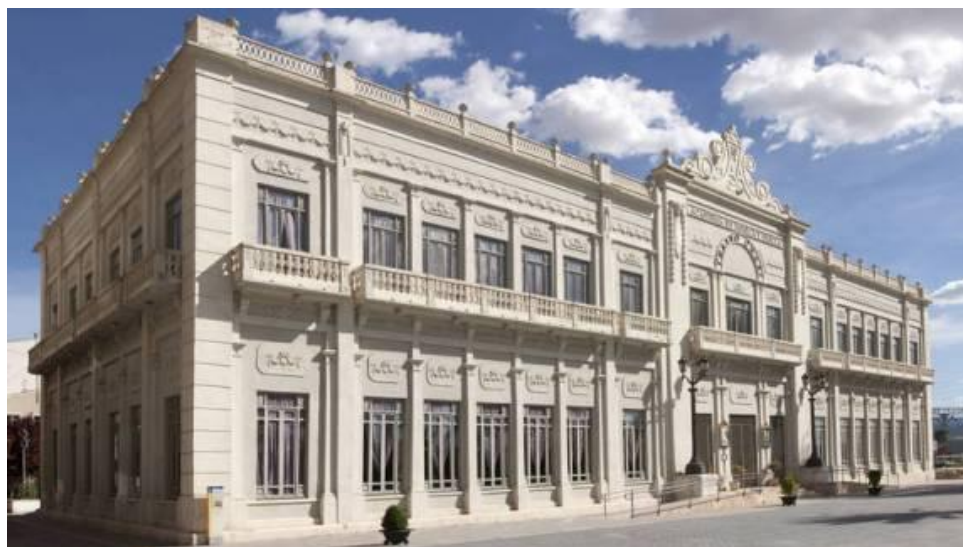
Fachada del Teatro Chapí en la actualidad 96
