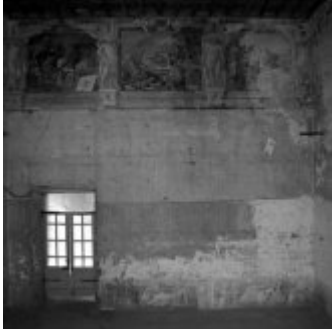
Fig. 249: Reggia di Diana before restoration
