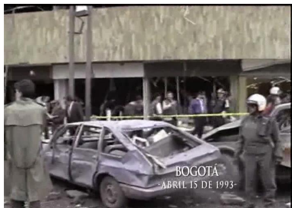
Fotograma 14. Explosión Edificio Centro 93
