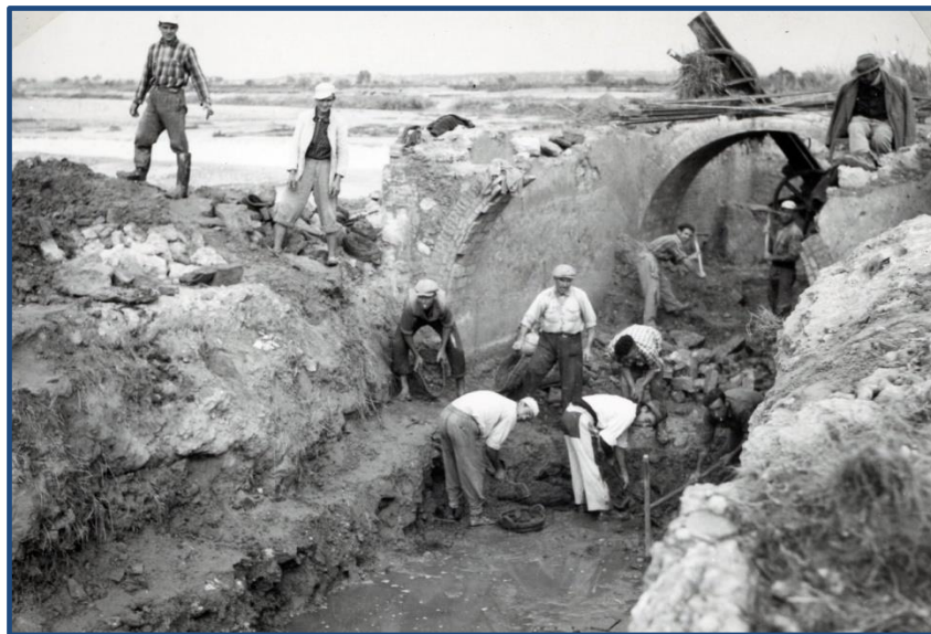
Fig. 7.17. Retirada de lodo en la acequia de Mestalla
