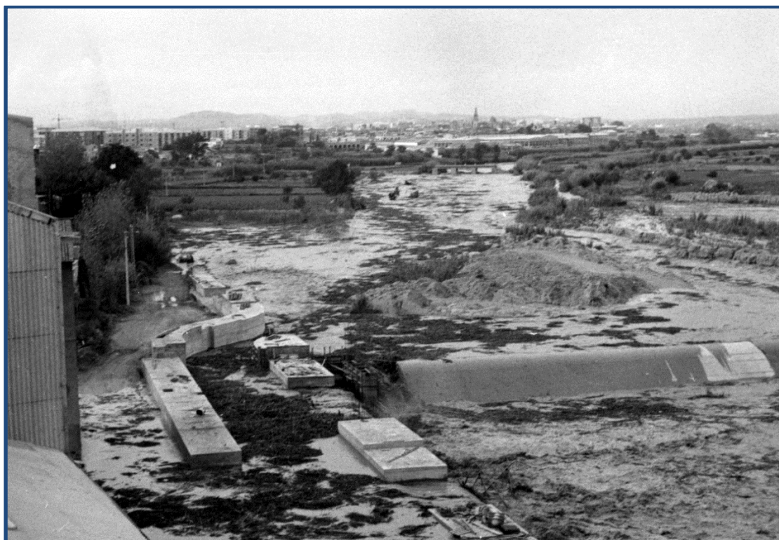
Fig. 8.10. Crecida del Turia durante las obras del Assut del Repartiment (1971)
