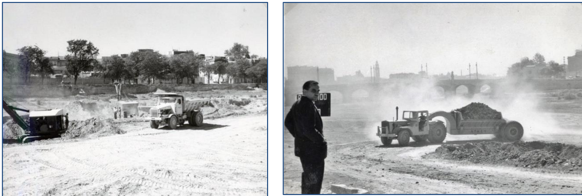
Fig. 7.22. Trabajos de reparación y dragado del cauce (1958)
