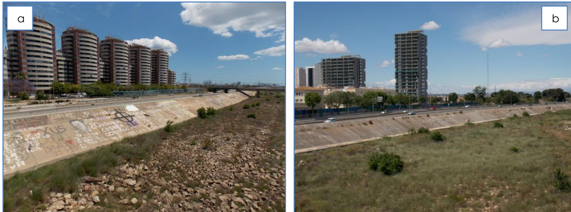
Fig. 13.1. Construcciones modernas en el nuevo borde fluvial de Valencia
