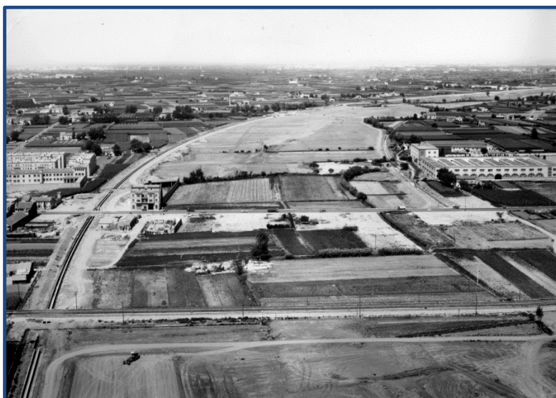
Fig. 9.11. Inmuebles afectados por las obras del nuevo cauce (barrio de La Torre)
