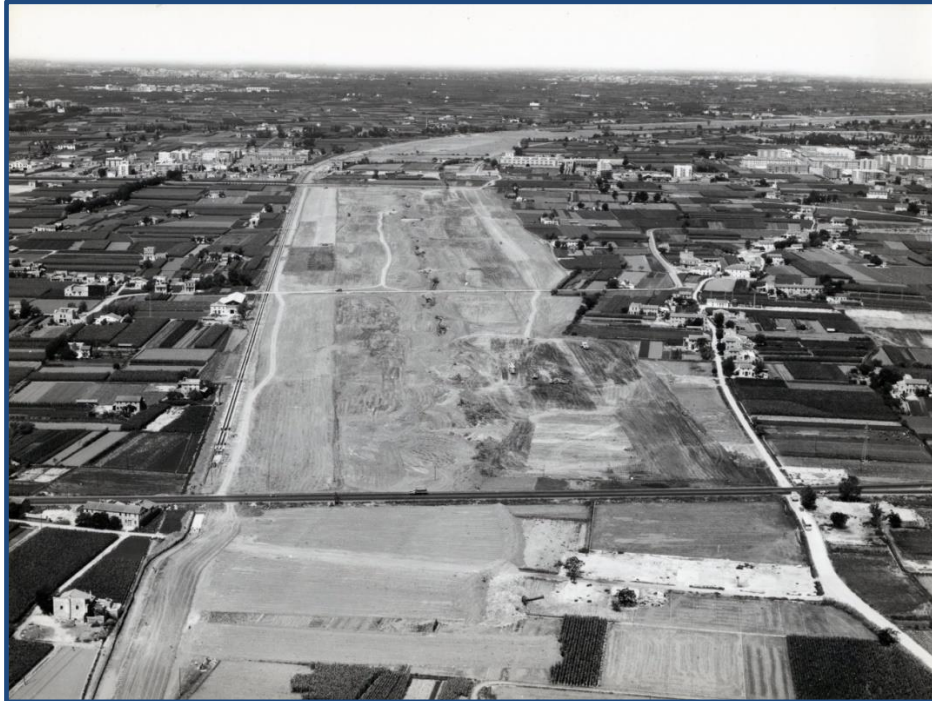
Fig. 9.4. Fragmentación de l'Horta por obras del nuevo cauce
