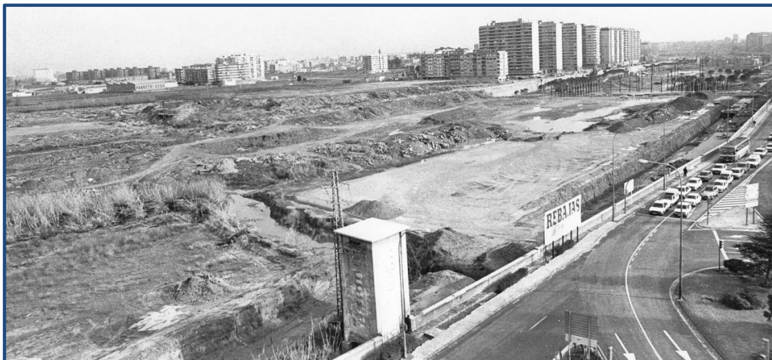
Fig. 11.11. Operaciones de ajardinamiento en el tramo recayente a Campanar (1987)
