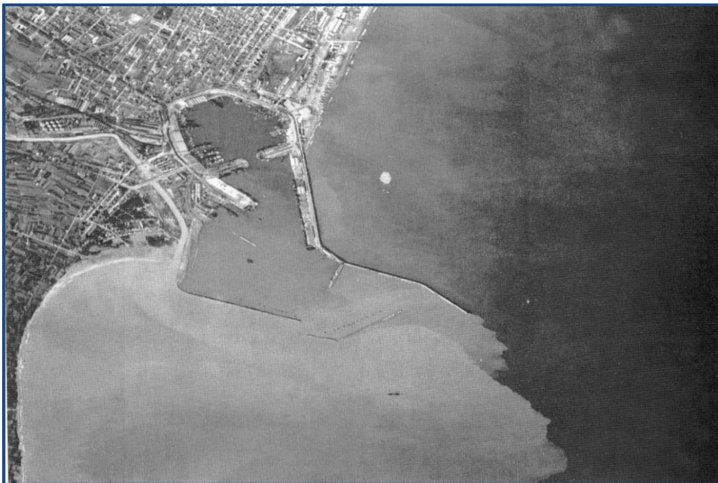
Fig. 3.7. Descarga sólida del Turia en su desembocadura (crecida de 1937)
