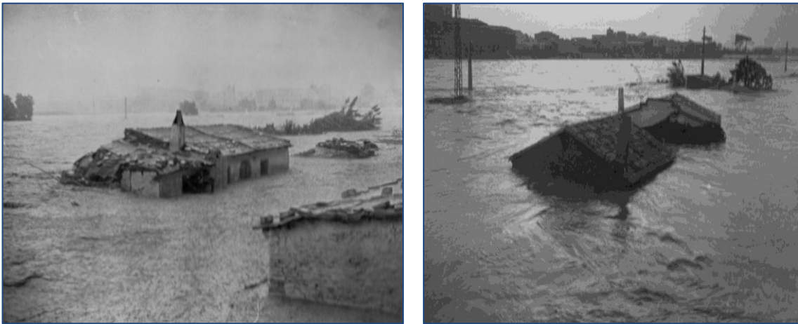
Fig. 3.10. Barracas adosadas a los pretiles y sumergidas por la crecida (1949)
