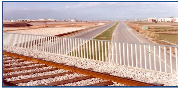
Fig. 9.8. Autovías laterales y paso de ferrocarril en el nuevo cauce
