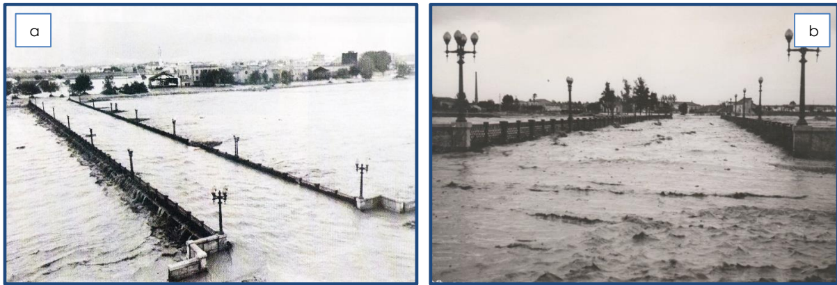
Fig. 7.5. Efecto acueducto inducido por el Pont de Campanar
