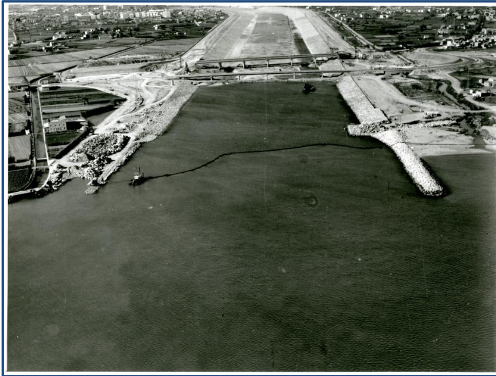
Fig. 8.9. Trabajos en la desembocadura (1967)
