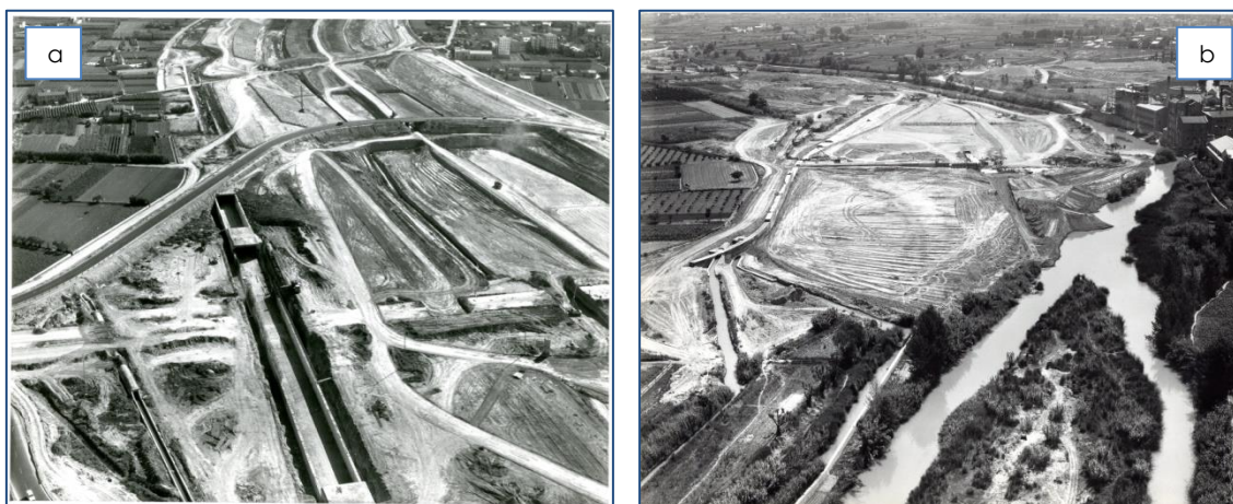
Fig. 8.8. Obras del Plan Sur (1968)
