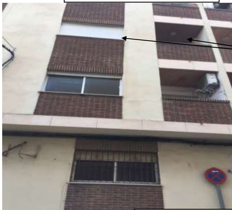
Foto n°17: Fachada del piso
