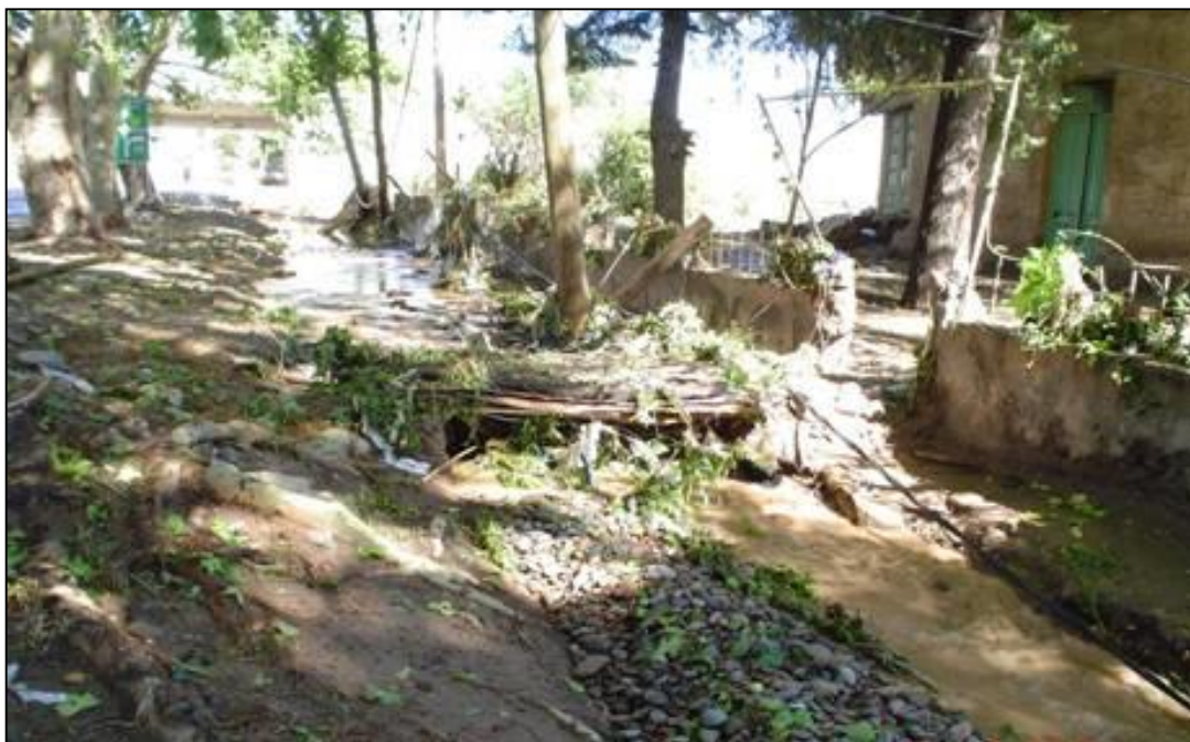
Figura 2.37 Colmatación de cauces de riego por afectación de volúmenes torrenciales
