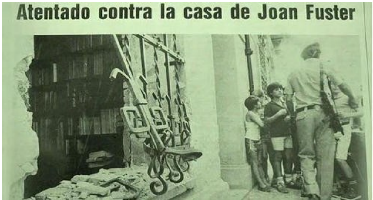
Imagen exterior de la casa de Joan Fuster tras la explosión de dos artefactos explosivos colocados en la fachada de su domicilio.
