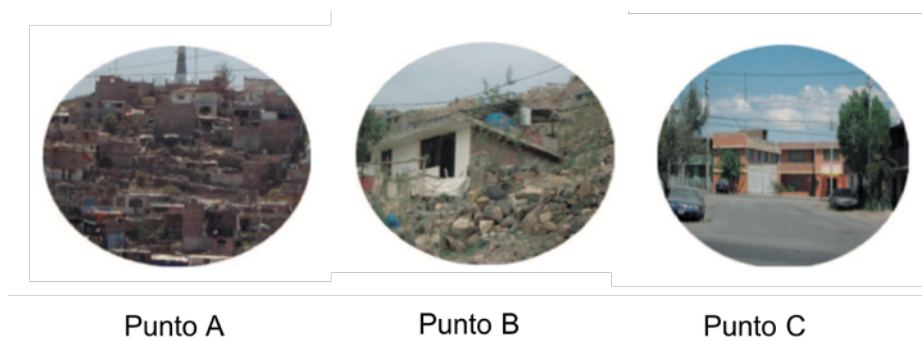
Figura 15: Imágenes de viviendas construidas en la periferia de Arequipa, que va desde el punto A, en el que se encuentran las recientemente erigidas, en los bordes del cerro, hasta las de la zona urbanizada del distrito Mariano Melgar (punto C), y una zona intermedia (punto B) que incluye “pueblos jóvenes”. Imagen adaptada de (Náquira, 2014).
