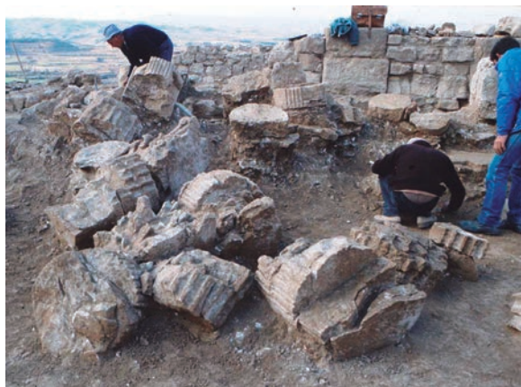
Fig. 8: Detalle del desplome de columnas y capiteles de la scaenae frons .
