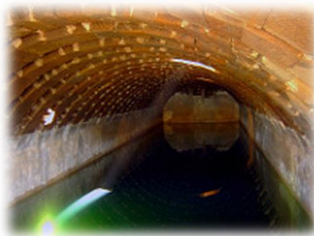
Ilustración 19: aljibe viste interior, disposición de los arcos. Juan Cazorla.
