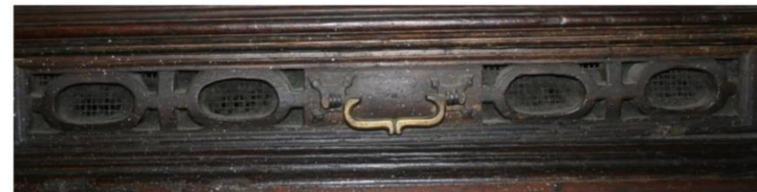
Figura.9. Ultimo cajón para ventilación decorado por una placa recalada a modo de cadena de óvalos detrás de la que hay una malla de hierro .
