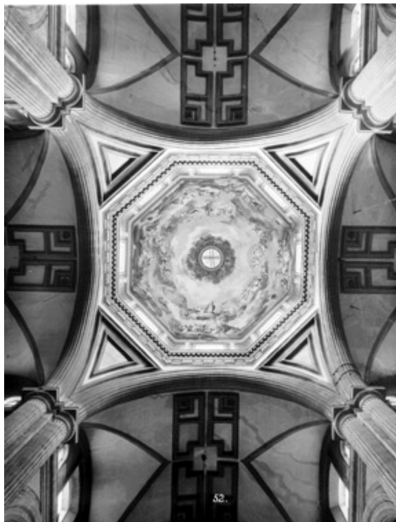
Interior de la cúpula de la Catedral Metropolitana Fotografía. Guillermo Kahlo. 1909 Sinafo (Sistema Nacional de Fototecas). INAH
